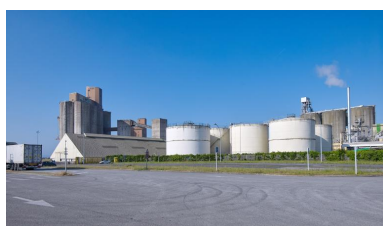
Citernes, magasins de stockage, silos à proximité de la plate-forme multimodale Phot. Bernard Bègne IVR53_20232900388NUCA
