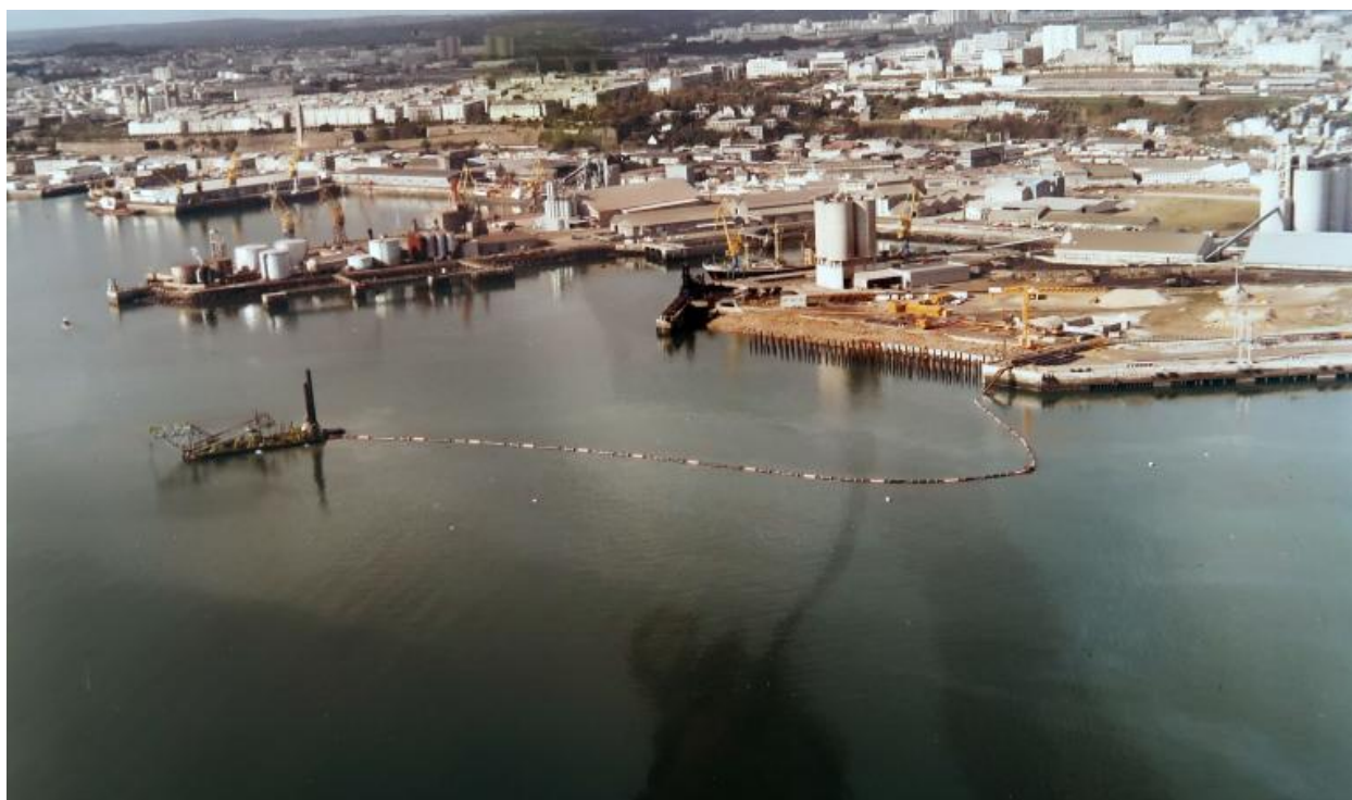
Bassin 6, quai sud en cours de construction (1977)
