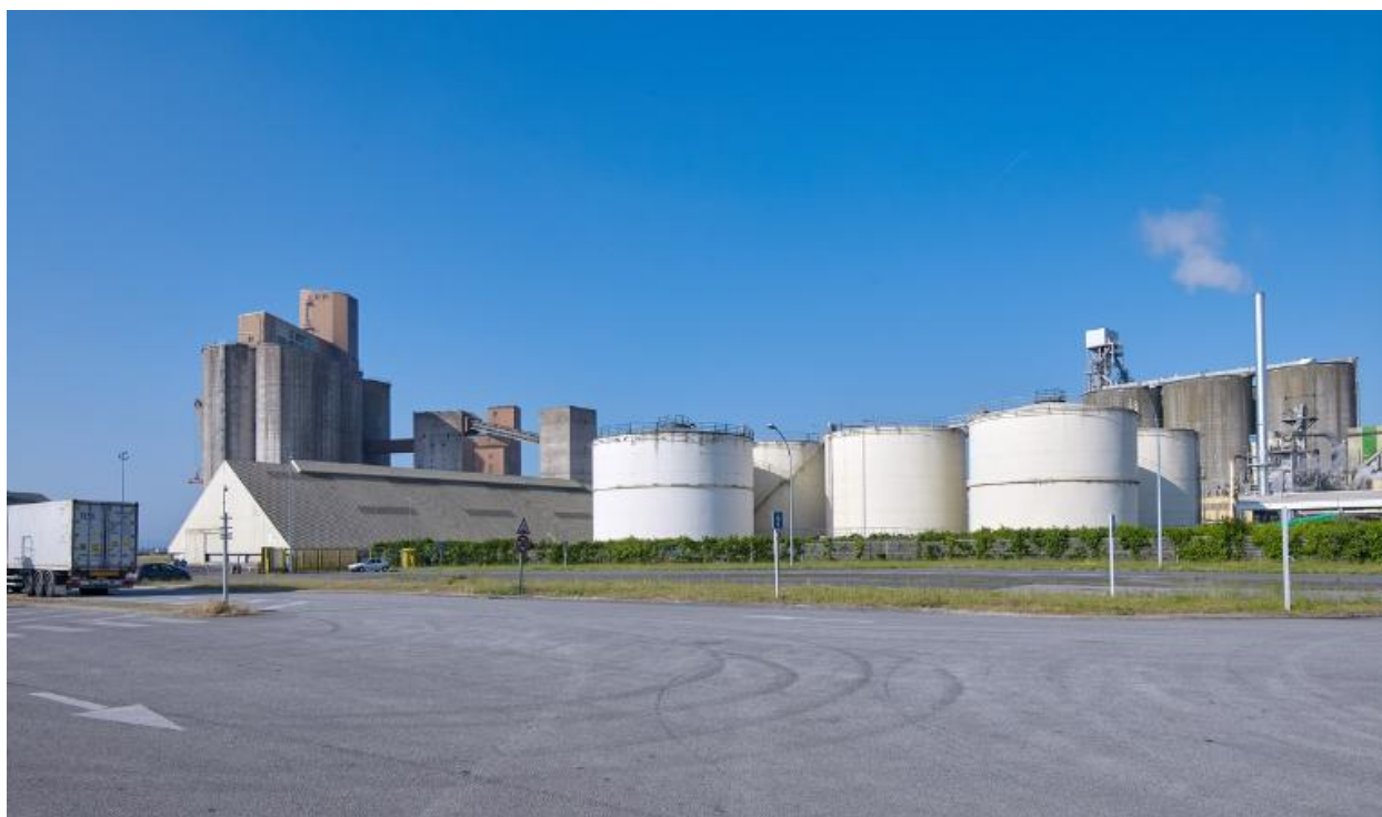
Citermes, magasins de stockage, silos à proximité de la plate-forme multimodale
