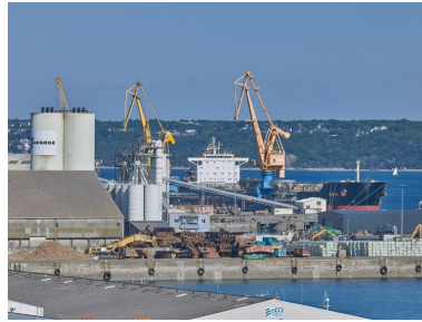
Vues des activités des 5e et 6e bassin Phot. Bernard Bègne IVR53_20232900421NUCA
