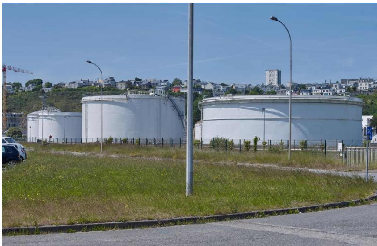
Périmètre SEVESO : stockage de produits pétroliers raffinés liquides
