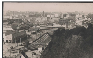
Zone industrialo-portuaire, vers début 1960 IVR53_20232905879NUCB
