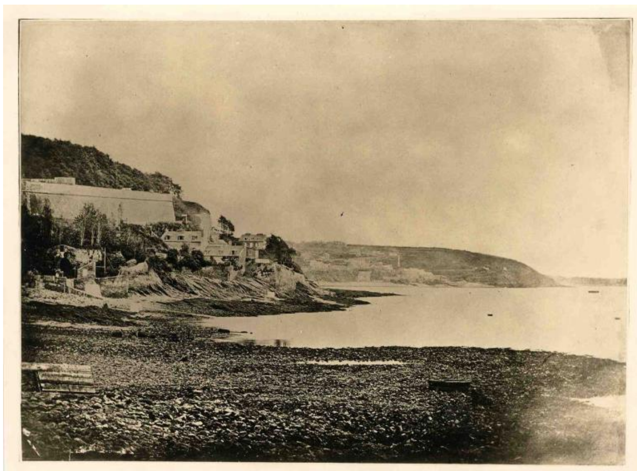
Anse de Porstrein avant les travaux du port de commerce (av. 1860)
