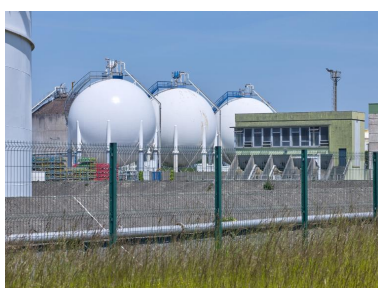
Zone SEVESO : stockage à haut risque Phot. Bernard Bègne IVR53_20232900386NUCA
