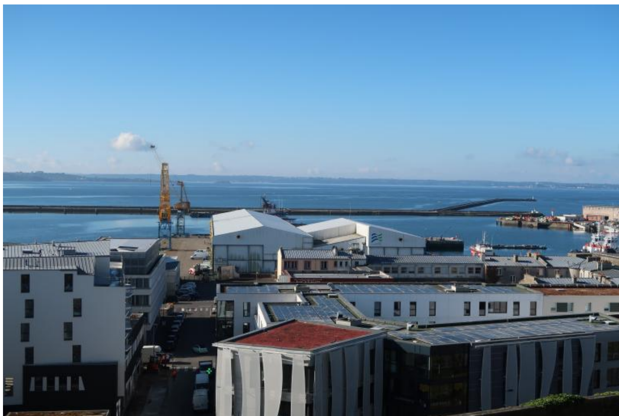
5e bassin (quai Ouest), grues protégées au titre des Monuments historiques, digue sud et développement urbain (interface-ville-port)
