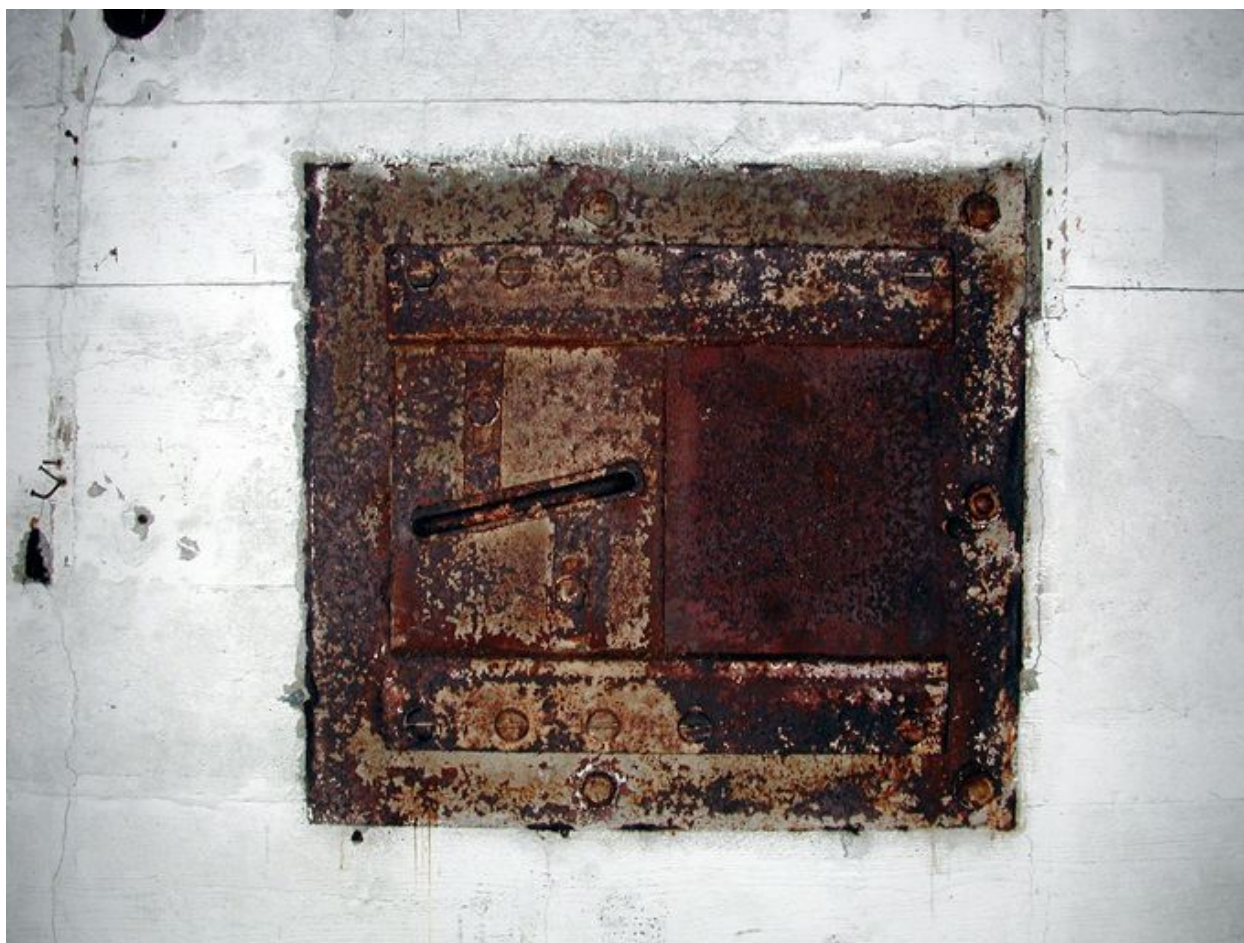
Landéda, île Cézon : abri pour un groupe de type 501 du fort Cézon, vue intérieure, créneau blindé de défense
