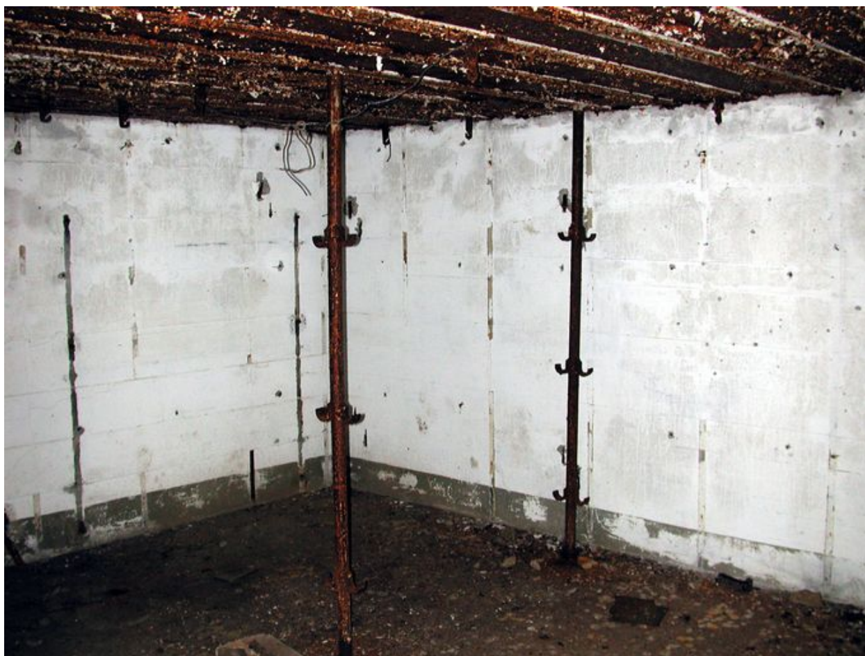
Landéda, île Cézou : abri pour un groupe de type 501 du fort Cézou, vue intérieure. Les supports des couchettes tubulaires sont encore en place
