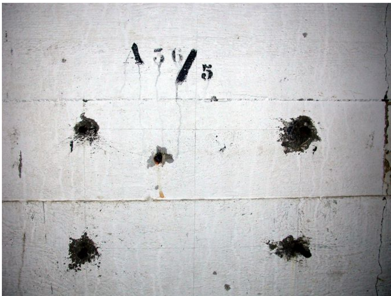
Landéda, île Cézon : abri pour un groupe de type 501 du fort Cézon, vue intérieure. Le numéro de l'ensemble fortifié : "A 36" et le numéro du blockhaus : "5" sont peints au-dessus du boîtier de connexion téléphonique (disparu)
