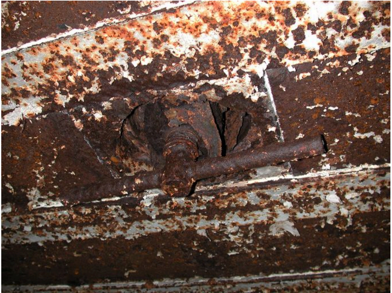
Landéda, île Cézon : abri pour un groupe de type 501 du fort Cézon, vue intérieure. Détail de l'orifice d'entrée du périscope
