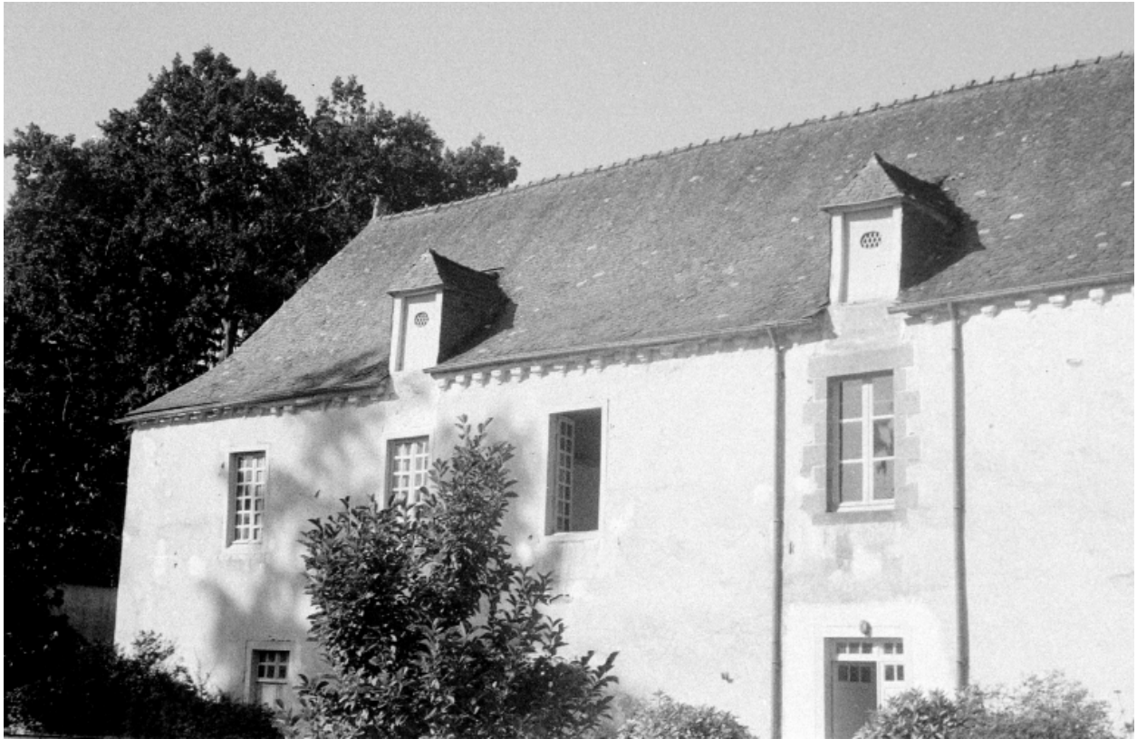
Détail de la façade
