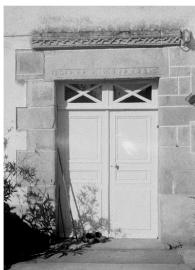
Détail de la porte Phot. A. Le Bihan IVR53_19703501777Z
