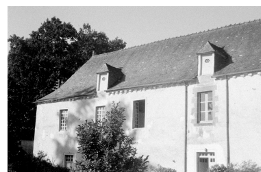
Détail de la façade Phot. A. Le Bihan IVR53_19703501774Z
