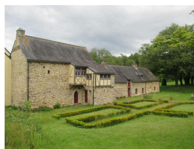
Façade nord, vue générale Phot. Béatrice Chollet d'Amour IVR53_20265611015NUCA
