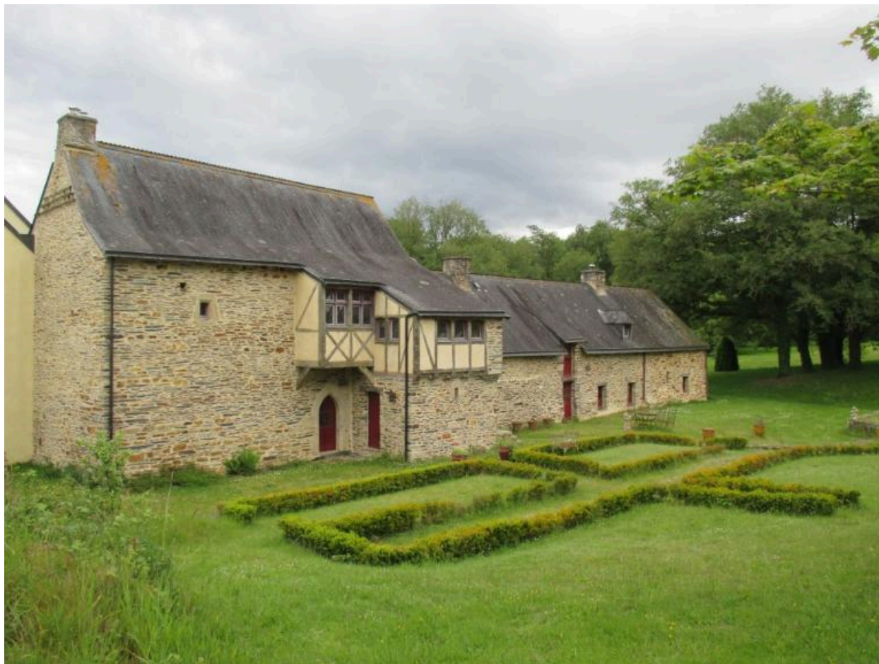
Façade nord, vue générale
