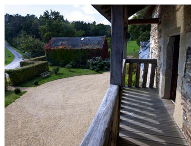
Manoir, logis : coursière en encorbellement (état en 2011) Phot. Bernard Bègne IVR53_20115601723NUCA
