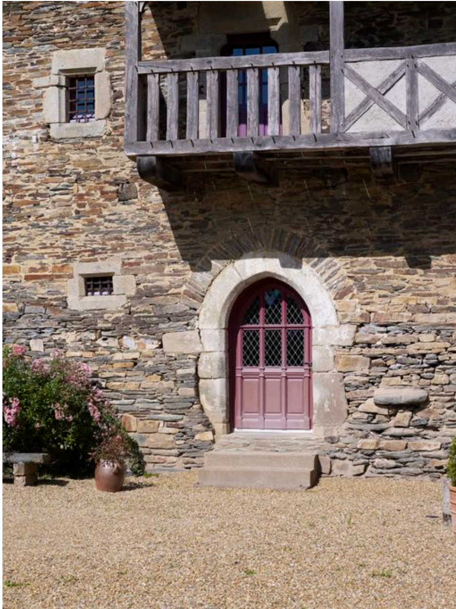
Manoir, logis : porte avec arc de décharge, surmontée d'une coursière en encorbellement ; à droite de la porte, la sortie de l'évier (état en 2011)
