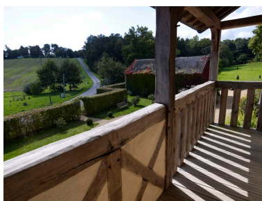
Manoir, logis : coursière en encorbellement (état en 2011) Phot. Bernard Bègne IVR53_20115601724NUCA
