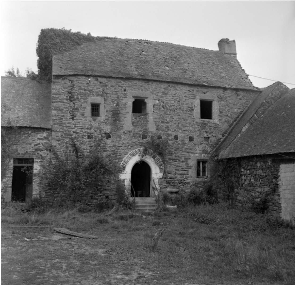
Manoir : vue générale prise du sud (état en 1984)
