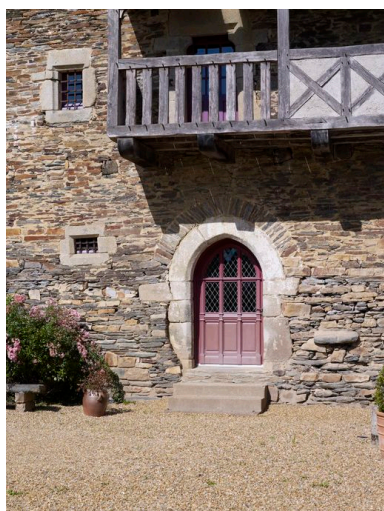
Manoir, logis : porte avec arc de décharge, surmontée d'une coursière en encorbellement ; à droite de la porte, la sortie de l'évier (état en 2011)
