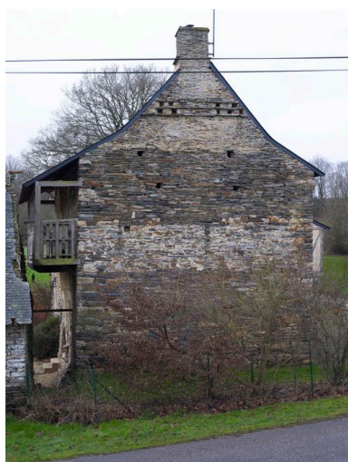
Manoir : vue générale prise de l'est ; dans le pignon sous la souche de cheminée, les boulins (état en 2012)
