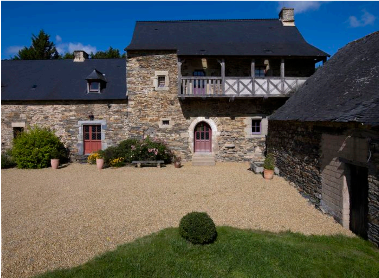
Manoir : vue générale prise du sud (état en 2011)
