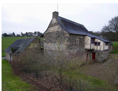
Manoir : vue générale prise du nord-est (état en 2012) Phot. Bernard Bègne IVR53_20125601172NUCA
