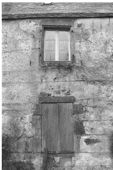
Manoir, état en 1979, élévation ouest, détail des ouvertures Phot. Guy Artur, Phot. Norbert Lambart IVR53_19842901395Z
