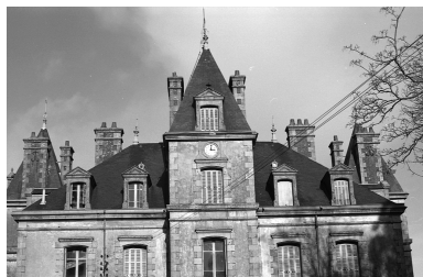
Château, élévation est, détail des parties hautes Phot. Guy Artur, Phot. Norbert Lambart IVR53_19842901385Z
