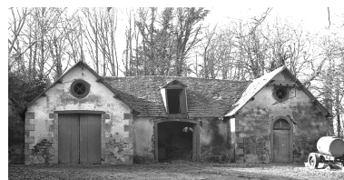
Communs, état en 1979, aile est, vue générale Phot. Guy Artur, Phot. Norbert Lambart IVR53_19842901389Z
