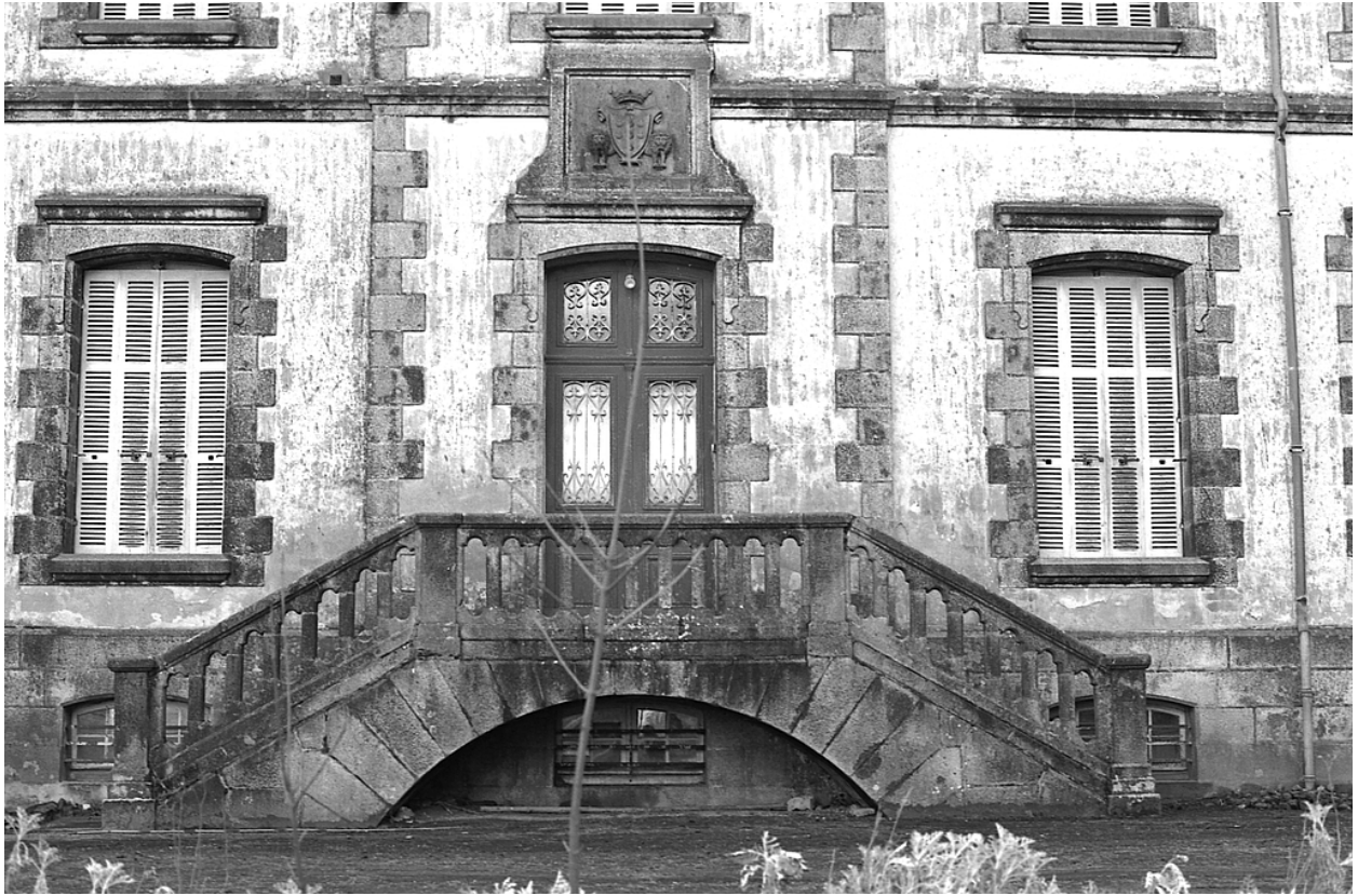
Château, élévation ouest, détail de l'escalier extérieur
