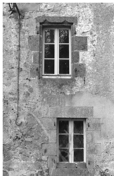
Manoir, état en 1979, élévation ouest, détail des ouvertures Phot. Guy Artur, Phot. Norbert Lambart IVR53_19842901396Z
