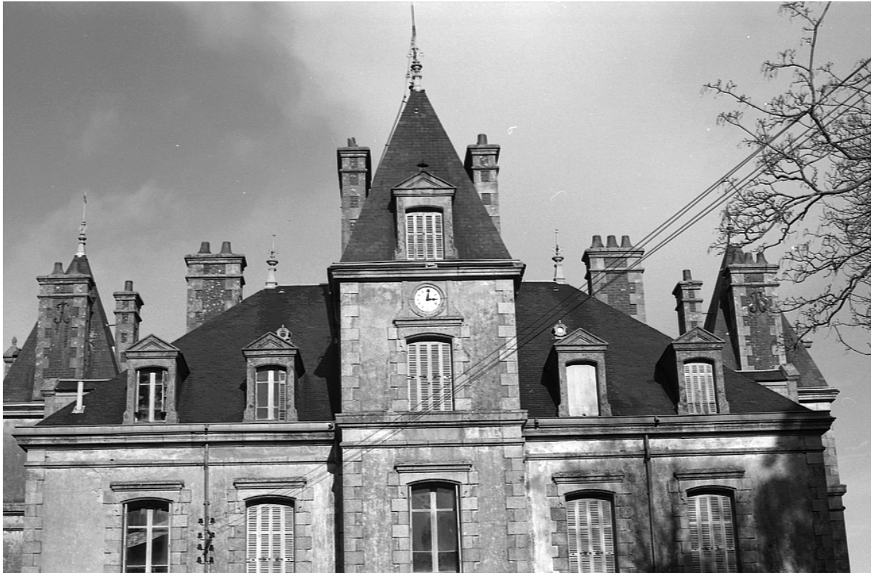
Château, élévation est, détail des parties hautes
