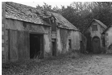
Communs, état en 1979, élévation nord, vue générale Phot. Guy Artur, Phot. Norbert Lambart IVR53_19842901397Z
