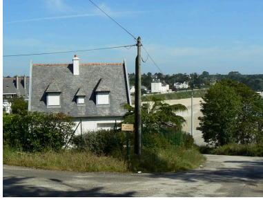
Vue de face Phot. Johan Vincent IVR53_20072908820NUCA
