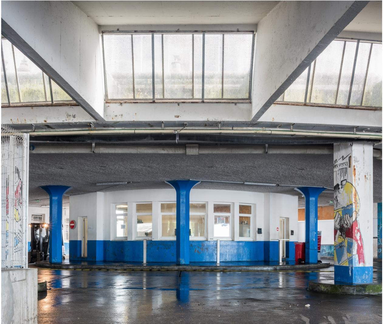
Structure porteuse de la zone de circulation de la criée ; ouverture en hauteur participant à un éclairage zénithal
