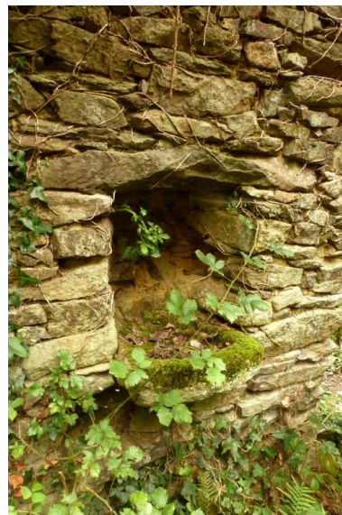
Ancien logis (?) daté 1780 devenu creche. Auge intégrée à la maçonnerie intérieure du mur sud. (2021) Phot. Fabien Serre IVR53_20212906162NUCA
