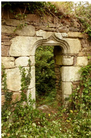
Ancien logis (?) daté 1780 devenu creche. Détail de la porte en anse de panier. (2021) Phot. Fabien Serre IVR53_20212906161NUCA
