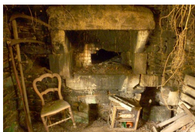
Fournil isolé au sud de la cour, détail de la cheminée et gueule du four. (2021) Phot. Fabien Serre IVR53_20212906151NUCA
