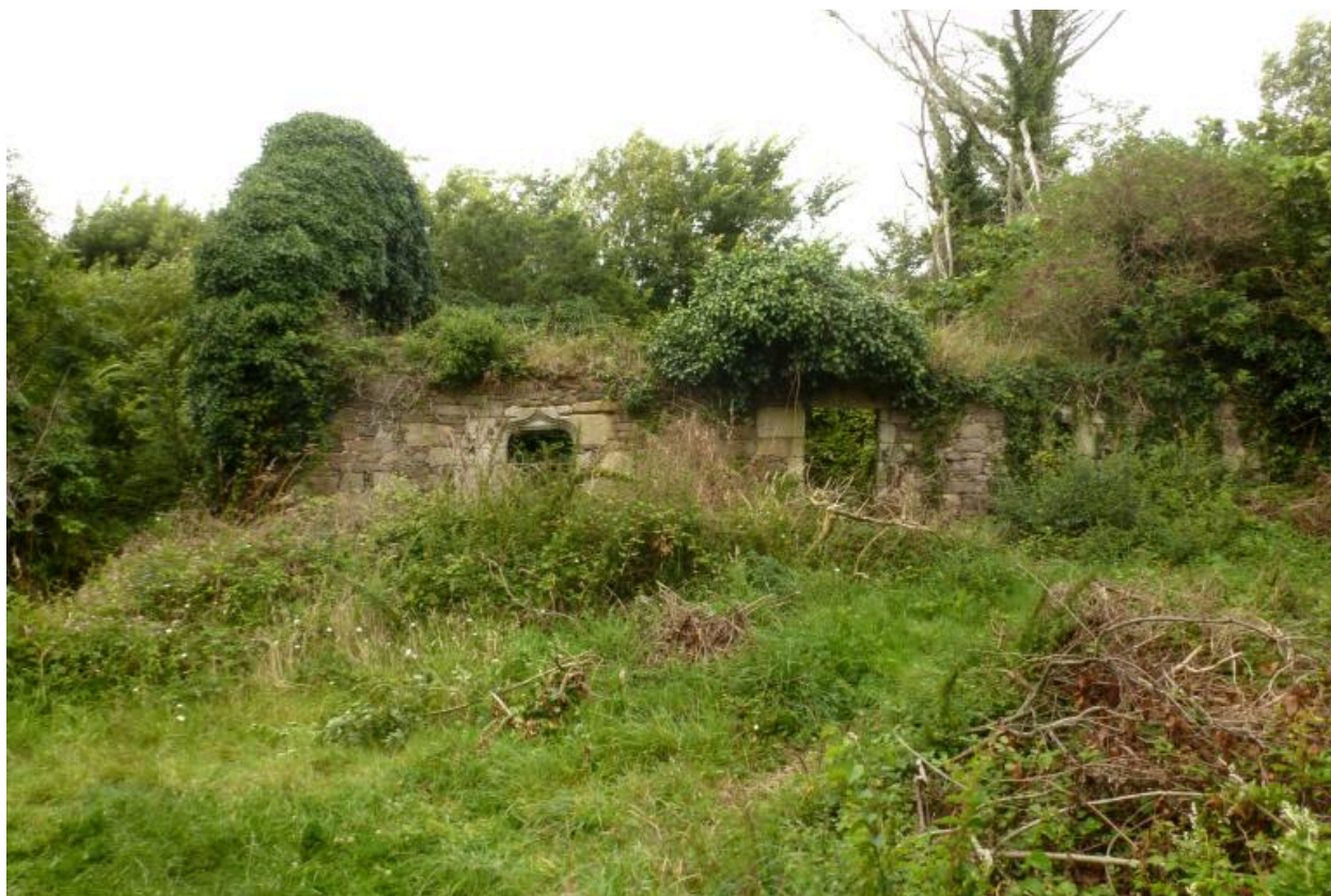
Ancien logis (?) daté 1780 devenu creche. Vue générale des vestiges. (2021)
