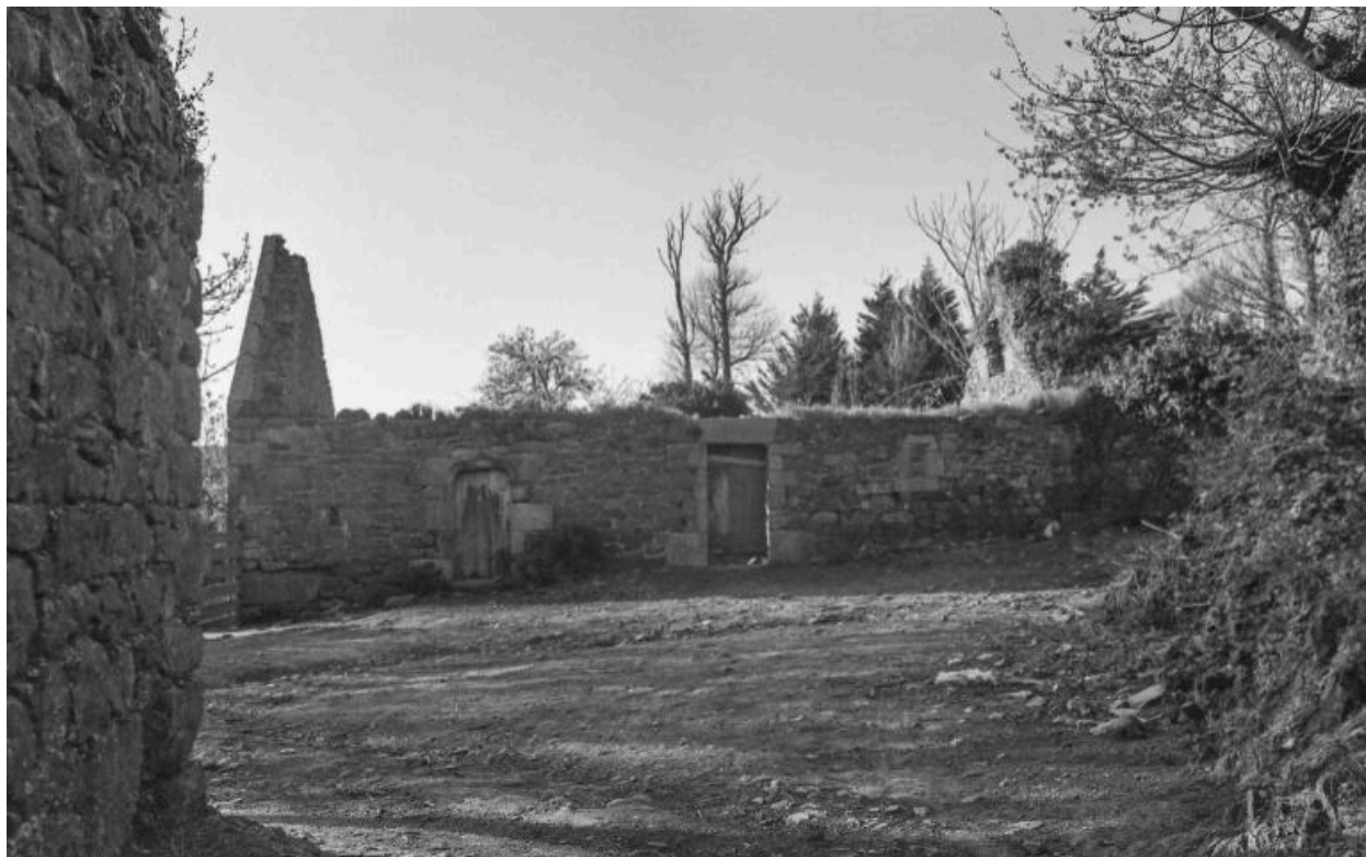
Ancien logis (?) daté 1780 devenu creche. Vue générale des vestiges. (1977)
