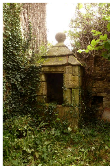
Puits daté 1820 accolé au nord du logis. (2021) Phot. Fabien Serre IVR53_20212906156NUCA
