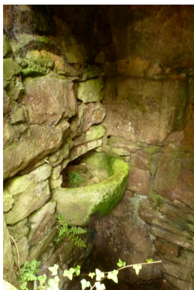
Puits daté 1820 accolé au nord du logis, auge intégrée dans le côté sud. (2021) Phot. Fabien Serre IVR53_20212906157NUCA
