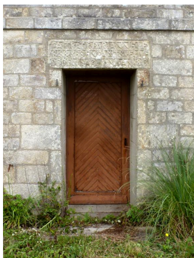
Logis, détail de la porte d'entrée et inscription : FAIT BATIR PAR ANNE LE BIS ET SES ENFANTS VEUVE DE DENIS ARHAN LAN 1813 Phot. Fabien Serre IVR53_20192905668NUCA
