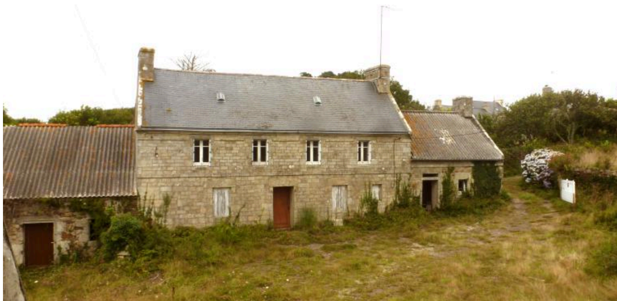
Alignement principal côté est : logis daté 1813 et écurie. Elévation antérieure sud. (2021)
