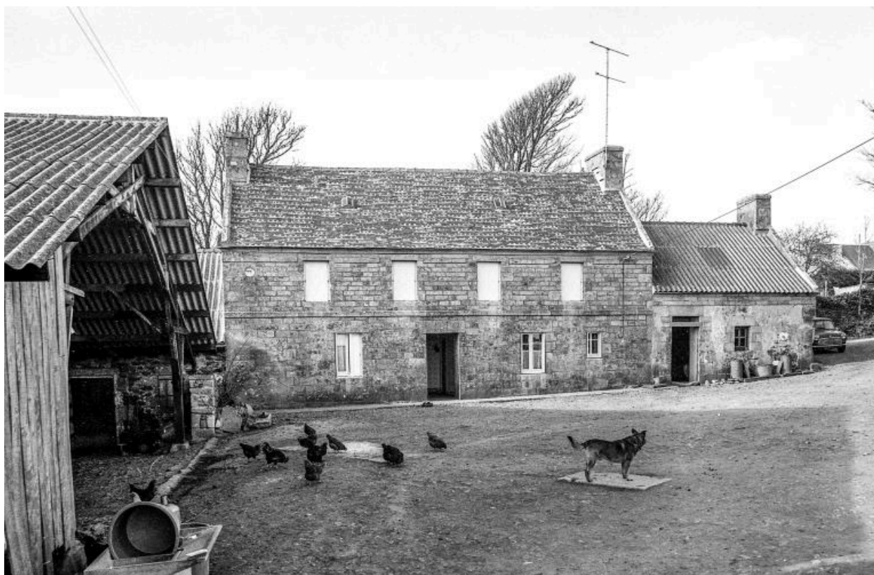
Alignement principal côté est : logis daté 1813 et écurie. Elévation antérieure sud. (1977)
