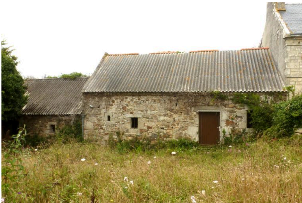
Alignement principal côté ouest : ancien logis daté 1831 devenu étable et crèche. Elévation antérieure sud. (2021)
