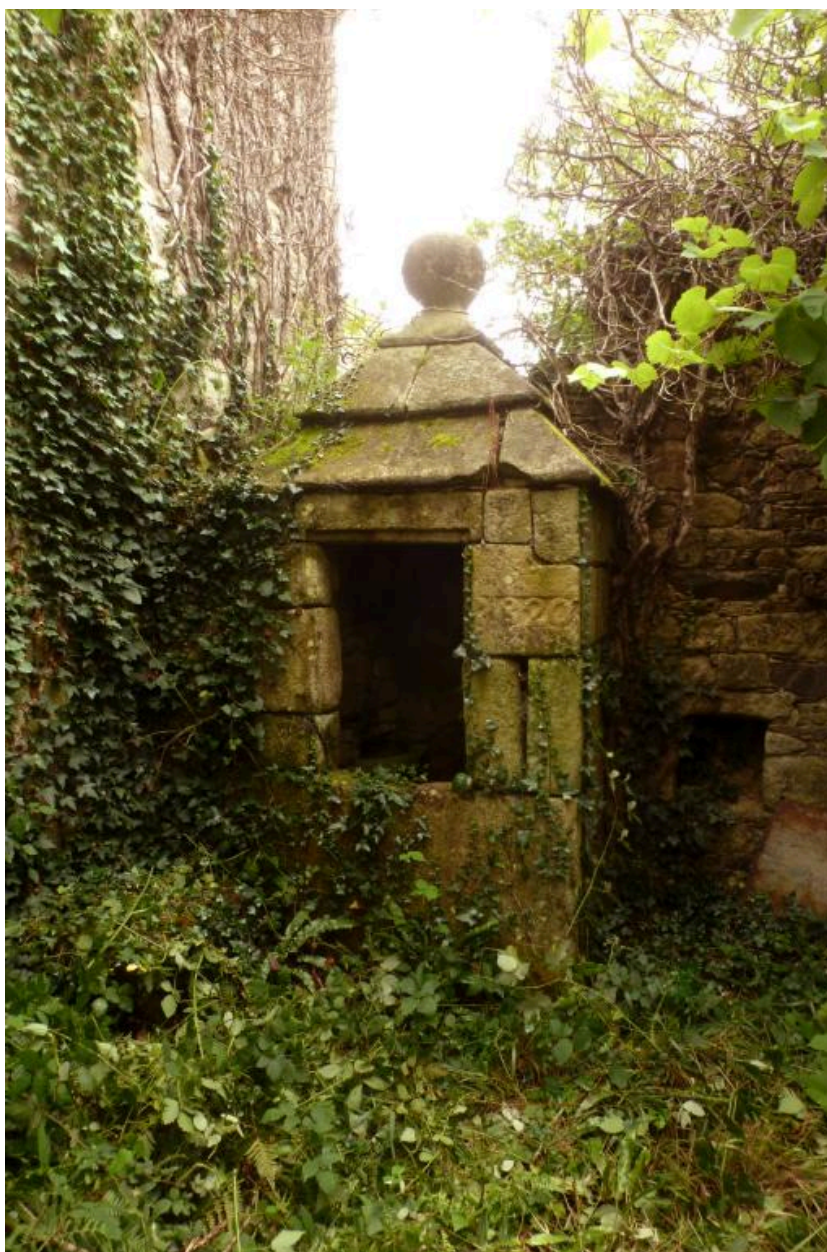
Puits daté 1820 accolé au nord du logis. (2021)
