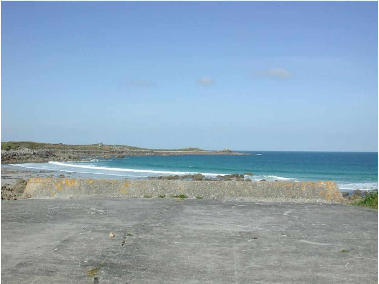
Vue de la plage de Beg Tanguy et la pointe de Tévenn Braz depuis la dalle de couverture du bunker (état en 2002)
