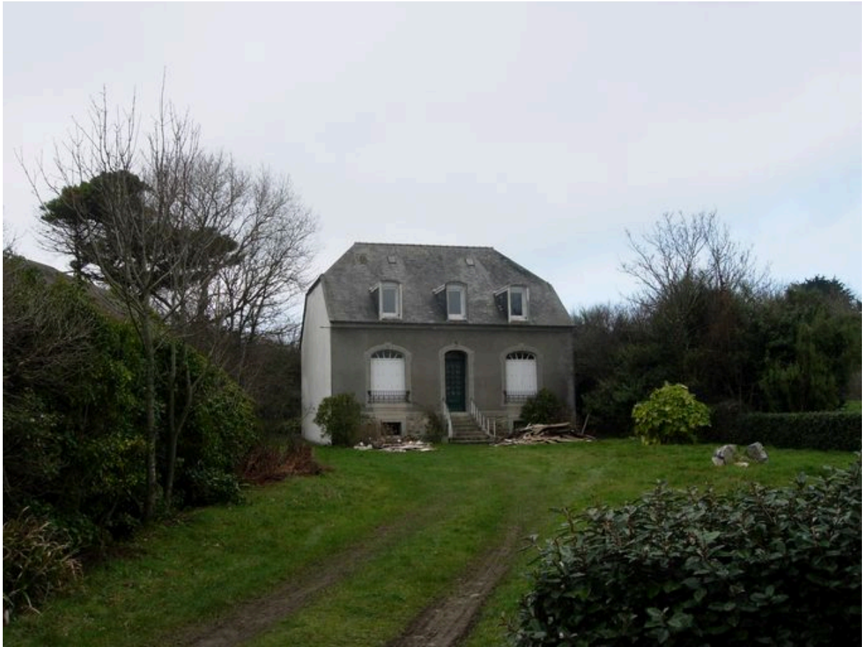
Elévation antérieure de la maison du charpentier Alexandre Morvan
