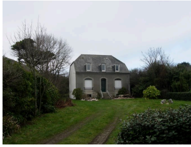
Elévation antérieure de la maison du charpentier Alexandre Morvan Phot. Françoise Péron IVR53_20062908425NUCA
