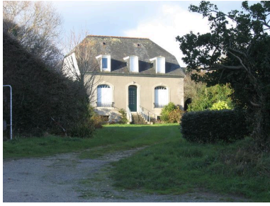
Vue générale de la maison du charpentier Alexandre Morvan Phot. Françoise Péron IVR53_20062908426NUCA
