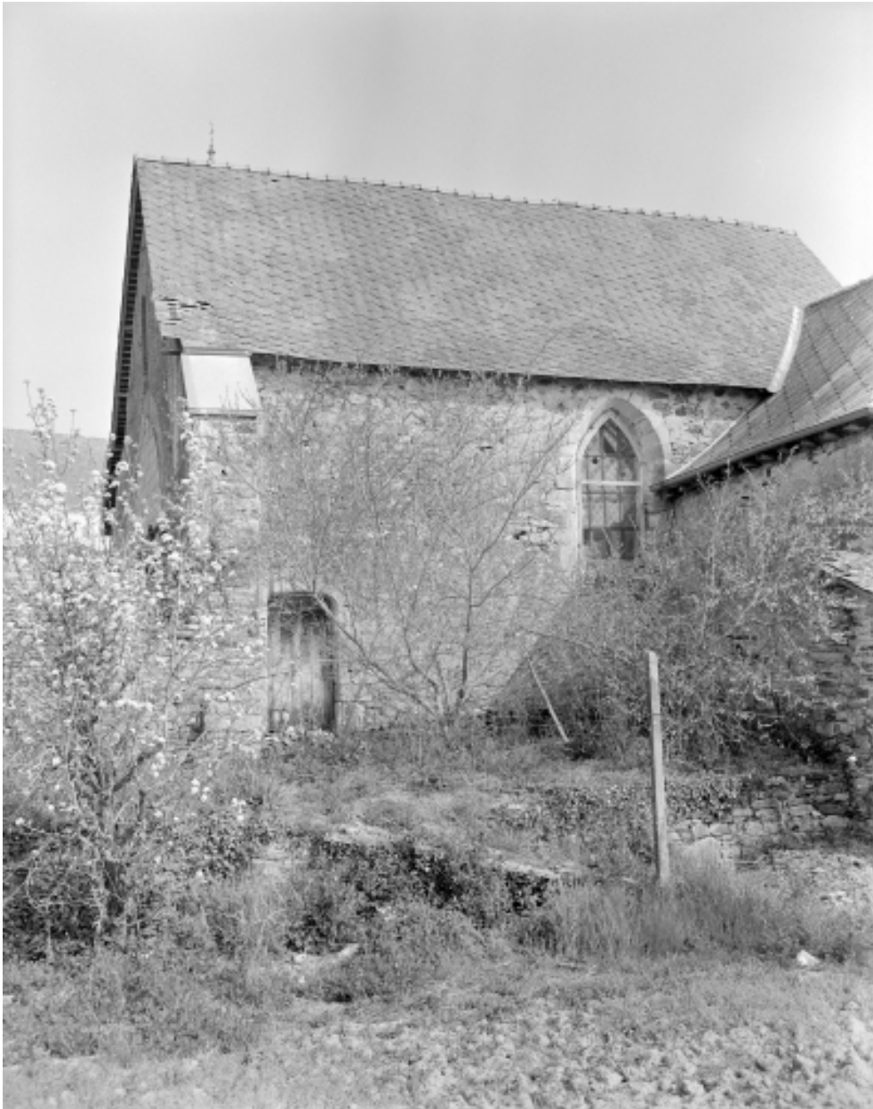
Elévation latérale, vue générale.
