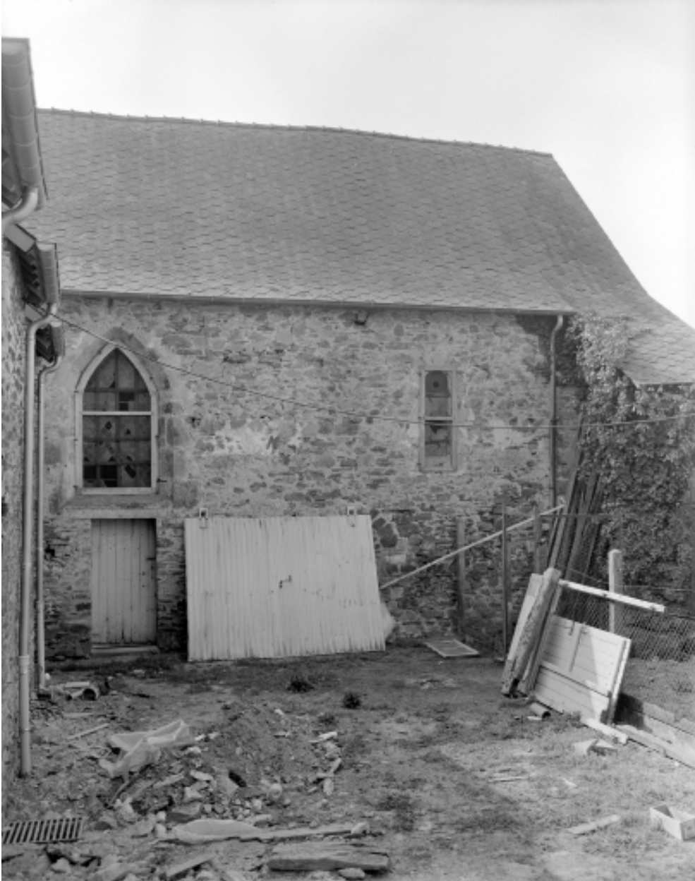
Elévation latérale, vue générale.
