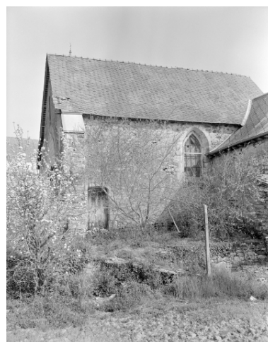
Elévation latérale, vue générale. Phot. Guy Artur, Phot. Norbert Lambart IVR53_19953500243X
