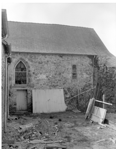
Elévation latérale, vue générale. Phot. Guy Artur, Phot. Norbert Lambart IVR53_19953500241X
