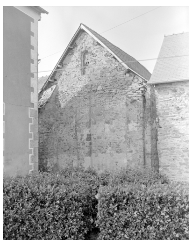
Chevet, vue générale. Phot. Guy Artur, Phot. Norbert Lambart IVR53_19953500242X
