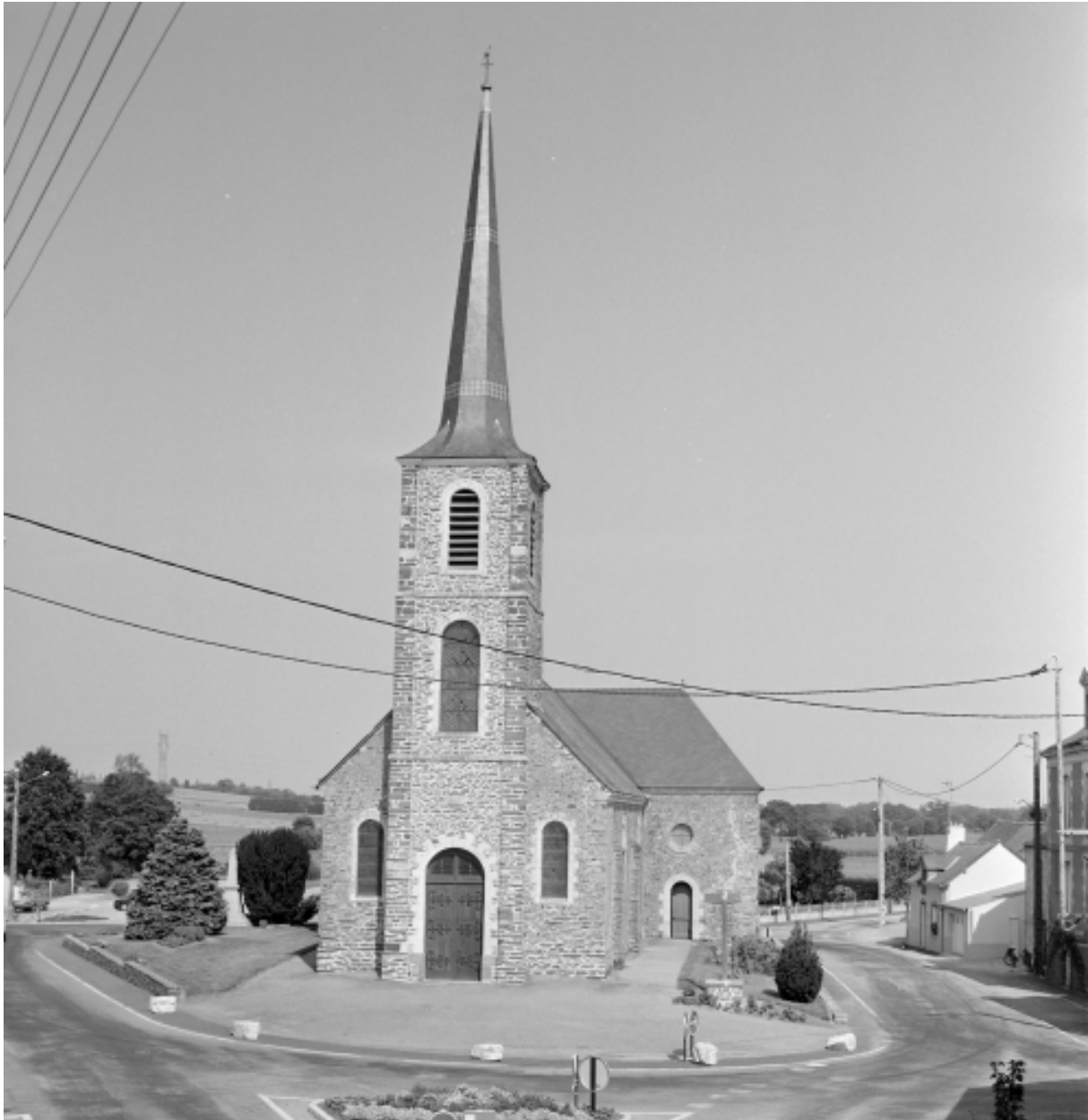
Elévation Ouest : vue générale
