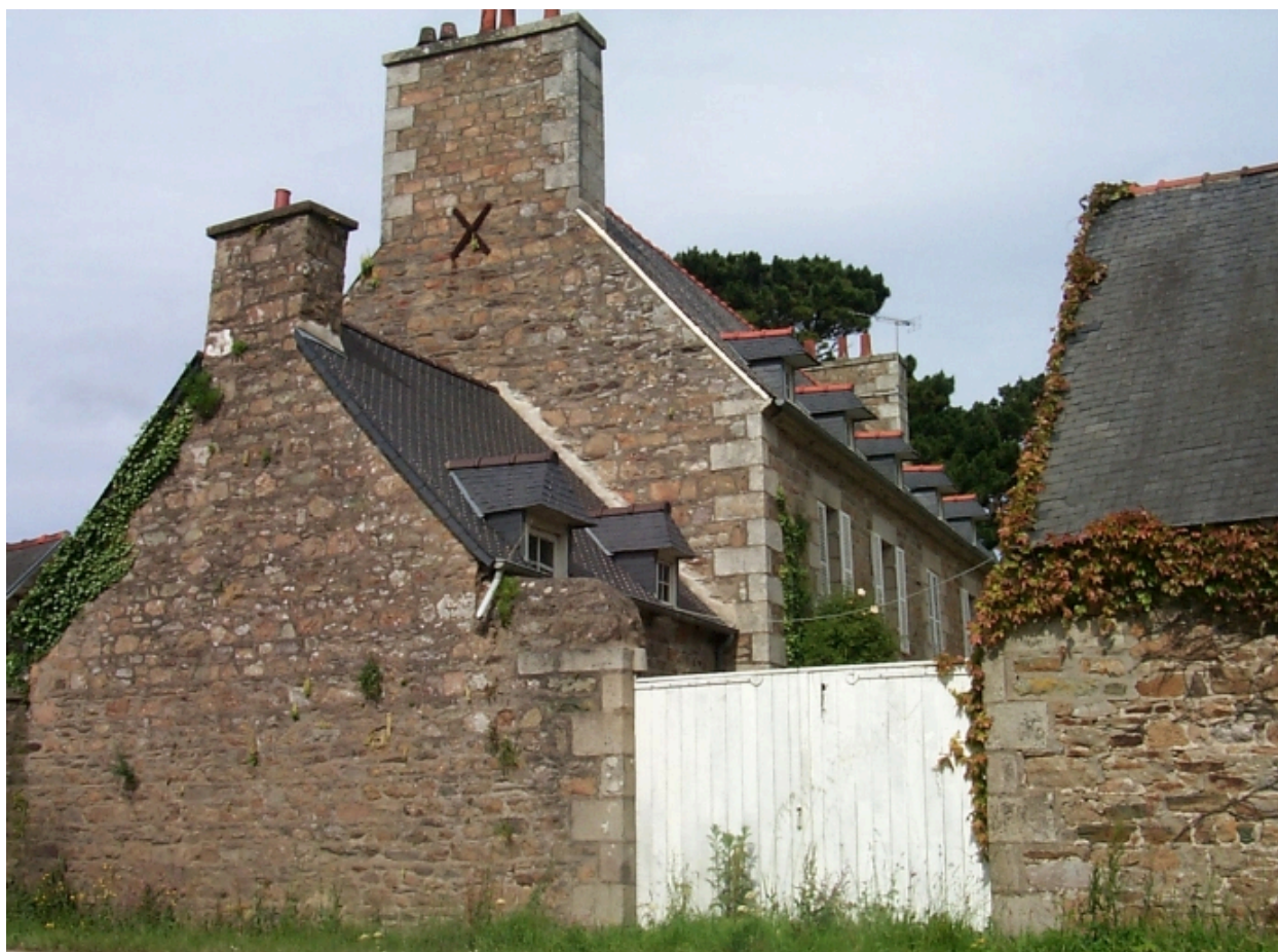
Vue générale (élévation antérieure)
