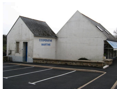
Coopérative maritime vue du parking Phot. Guillaume Marie IVR53_20072909035NUCA
