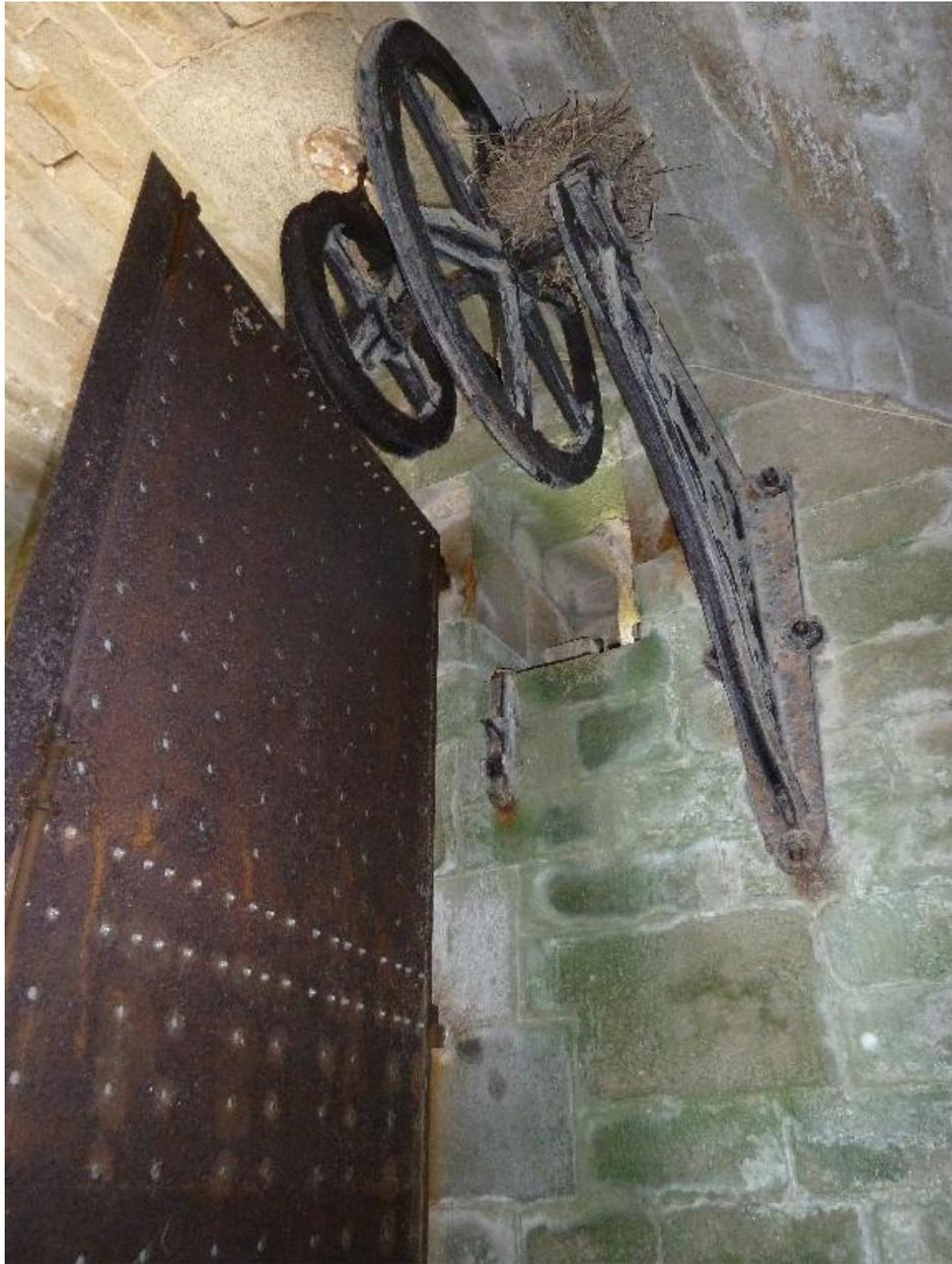
Hœdic, fort central, caserne à l'épreuve, détail de la porte et d'une partie du mécanisme du pont-levis.
