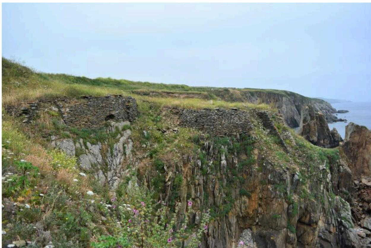
Vue depuis l'ouest de murs de soutènement permettant l'installation de daviers à goémon sur le sites des Rospects, à proximité de la pointe Saint-Mathieu à Plougonvelin. Le mur à gauche présente un ravinement important par le bas
