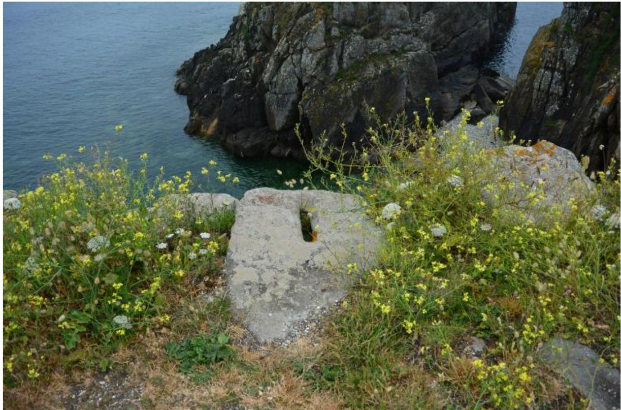
Vue du dessus d'une pierre percée permettant l'installation de la pièce en bois du davied
