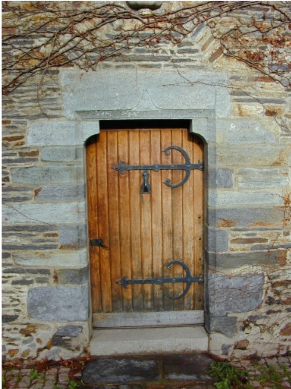
Détail : façade sud, porte à coussinets
