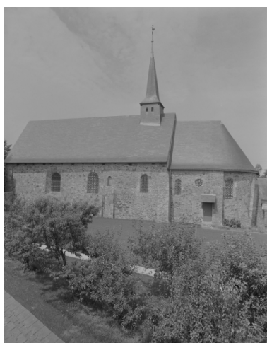
Élévation sud : vue générale Phot. Guy Artur, Phot. Norbert Lambart IVR53_19943501423X
