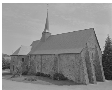
Élévation nord-ouest : vue générale Phot. Guy Artur, Phot. Norbert Lambart IVR53_19943501421X
