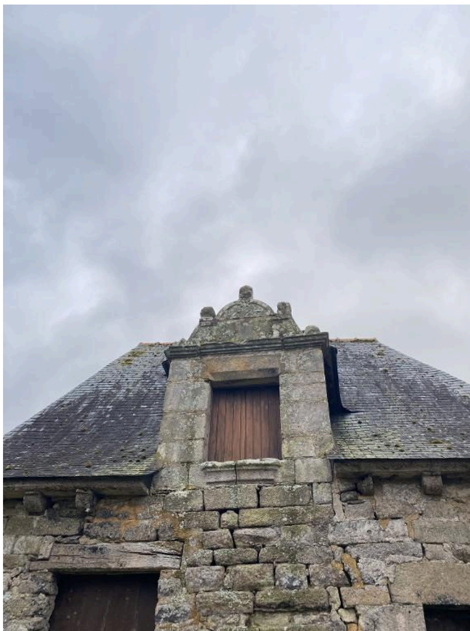
Lucarne à fronton, façade nord
