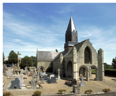
Vue générale Phot. Norbert Lambart IVR53_20023500625XA
