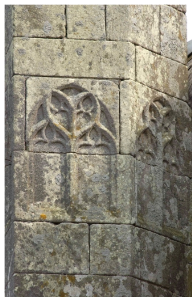
Porche, détail, décor d'un pinacle Phot. Norbert Lambart IVR53_20033501056NUCA
