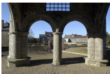
Porche, vue intérieure Phot. Bernard Bègne IVR53_20043500062NUCA
