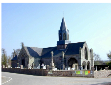
Vue de situation nord-ouest Phot. Xavier Gilbert IVR53_20033512126NUCA
