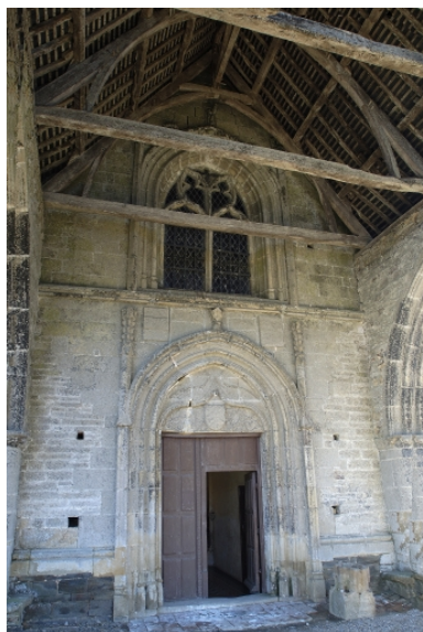
Façade ouest prise de l'intérieur du porche Phot. Bernard Bègne IVR53_20043500063NUCA
