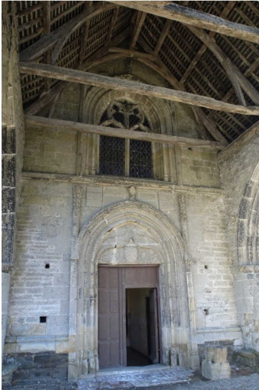
Façade ouest prise de l'intérieur du porche
