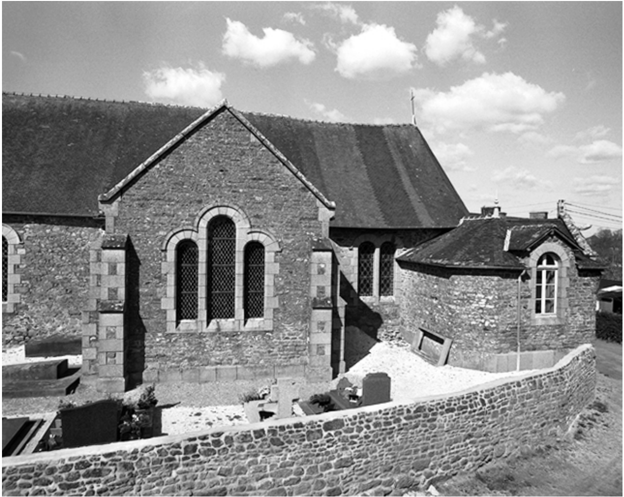
Vue partielle sud-est
