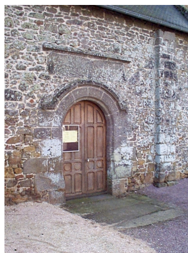
Mur nord, vestiges de périodes anciennes : murs et contreforts 12e siècle, porte limite 15e siècle 16e siècle Phot. Claude Quillivic IVR53_19973502361NUCA
