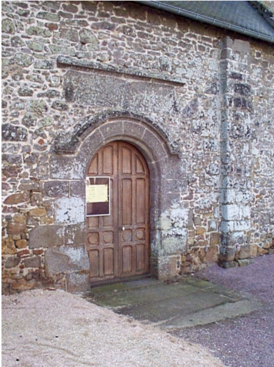
Mur nord, vestiges de périodes anciennes : murs et contreforts 12e siècle, porte limite 15e siècle 16e siècle
