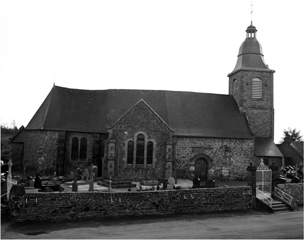
Vue générale nord
