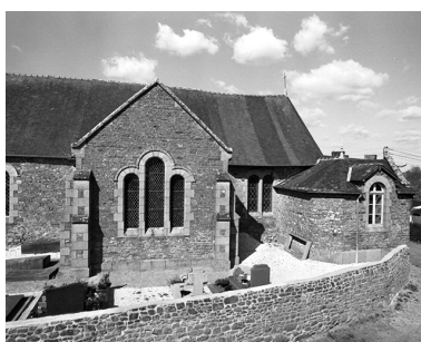
Vue partielle sud-est Phot. Guy Artur, Phot. Norbert Lambart IVR53_19953500230X
