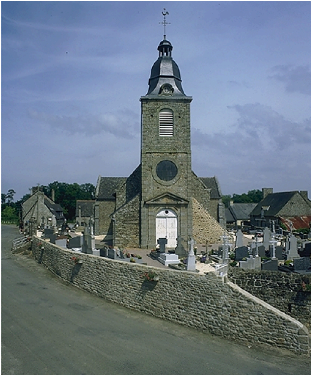
Vue générale ouest
