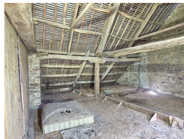
Logis début 17e siècle. Grenier avec appentis postérieur dans le prolongement. Charpente avec ferme centrale reposant sur une sablière, elle-même soutenue par un poteau Phot. Bernard Bègne IVR53_20232201263NUCA
