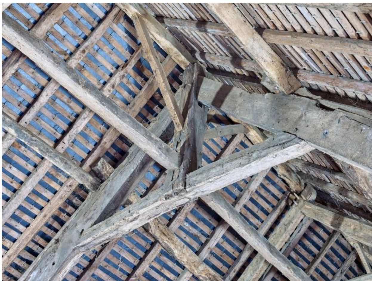
Logis début 17e siècle. Charpente. Détail du poinçon, de la sous panne faîtière et des liens de contreventement
