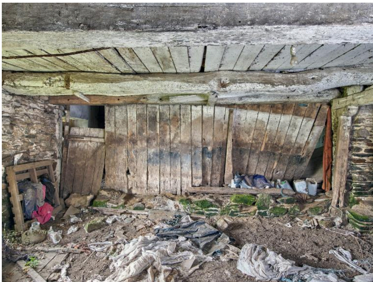
Logis début 17e siècle. Rez-de-chaussée. Cloison placée entre la salle et la dépendance dévolue au conditionnement des toiles
