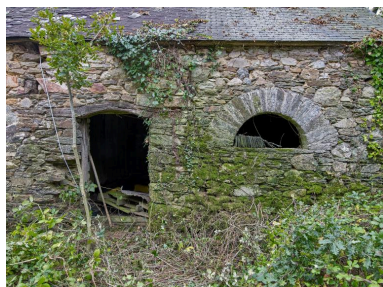
Etable située en face du logis. Elévation nord. Détail de la porte à linteau de bois cintré et de la baie en plein cintre à claveaux de schiste Phot. Bernard Bègne IVR53_20232201267NUCA
