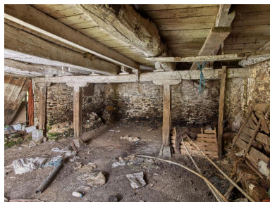
Logis début 17e siècle. Partie dévolue au conditionnement des toiles avec appentis postérieur. Système de poutraison faisant office de mur porteur Phot. Bernard Bègne IVR53_20232201252NUCA
