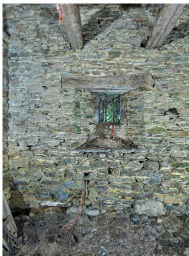
Ferme-blanchisserie voisine de la maison de marchand. Remise. Détail d'une baie à barreaux et d'une pierre d'attache sous la baie Phot. Bernard Bègne IVR53_20232201271NUCA
