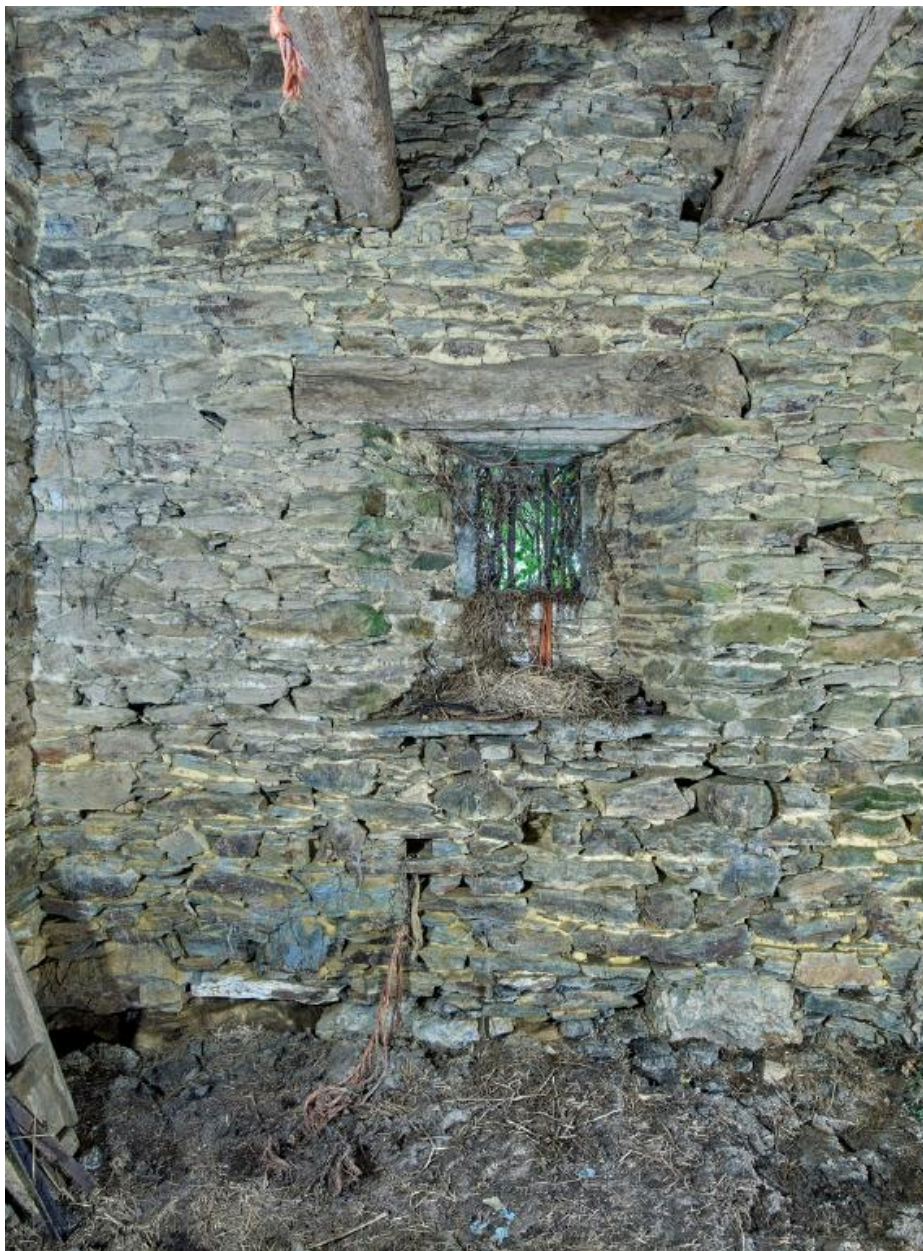
Ferme-blanchisserie voisine de la maison de marchand. Remise. Détail d'une baie à barreaux et d'une pierre d'attache sous la baie
