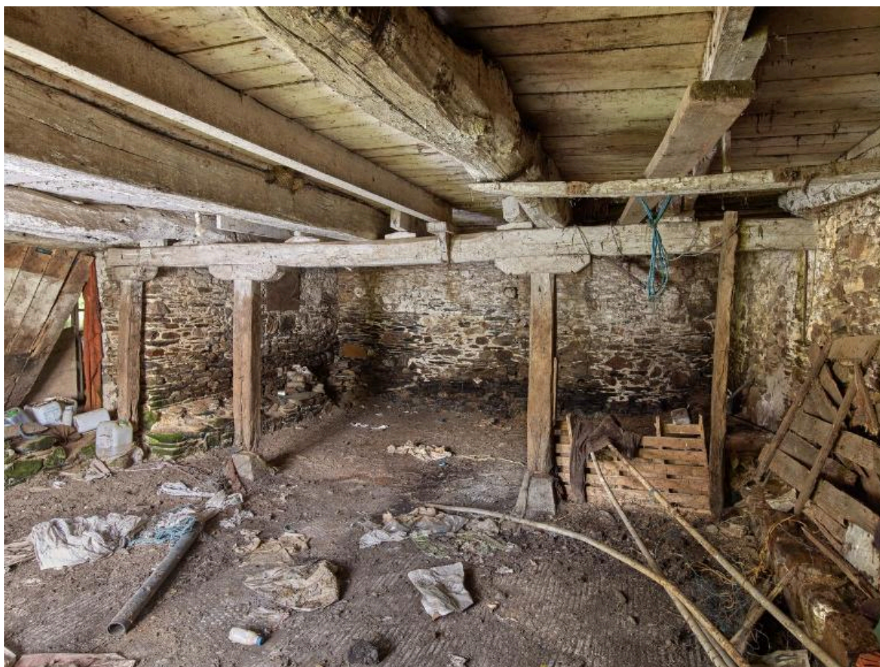
Logis début 17e siècle. Partie dévolue au conditionnement des toiles avec appentis postérieur. Système de poutraison faisant office de mur porteur
