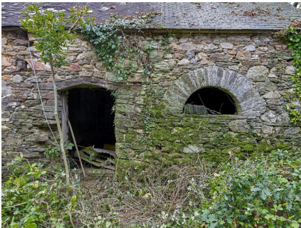
Etable située en face du logis. Elévation nord. Détail de la porte à linteau de bois cintré et de la baie en plein cintre à claveaux de schiste
