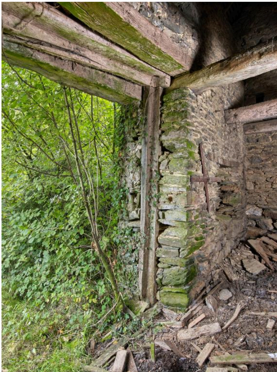
Logis début 17e siècle. Partie dévolue au conditionnement des toiles. Porte charretière. Détail du cadre d'huissierie intégré dans le mur
