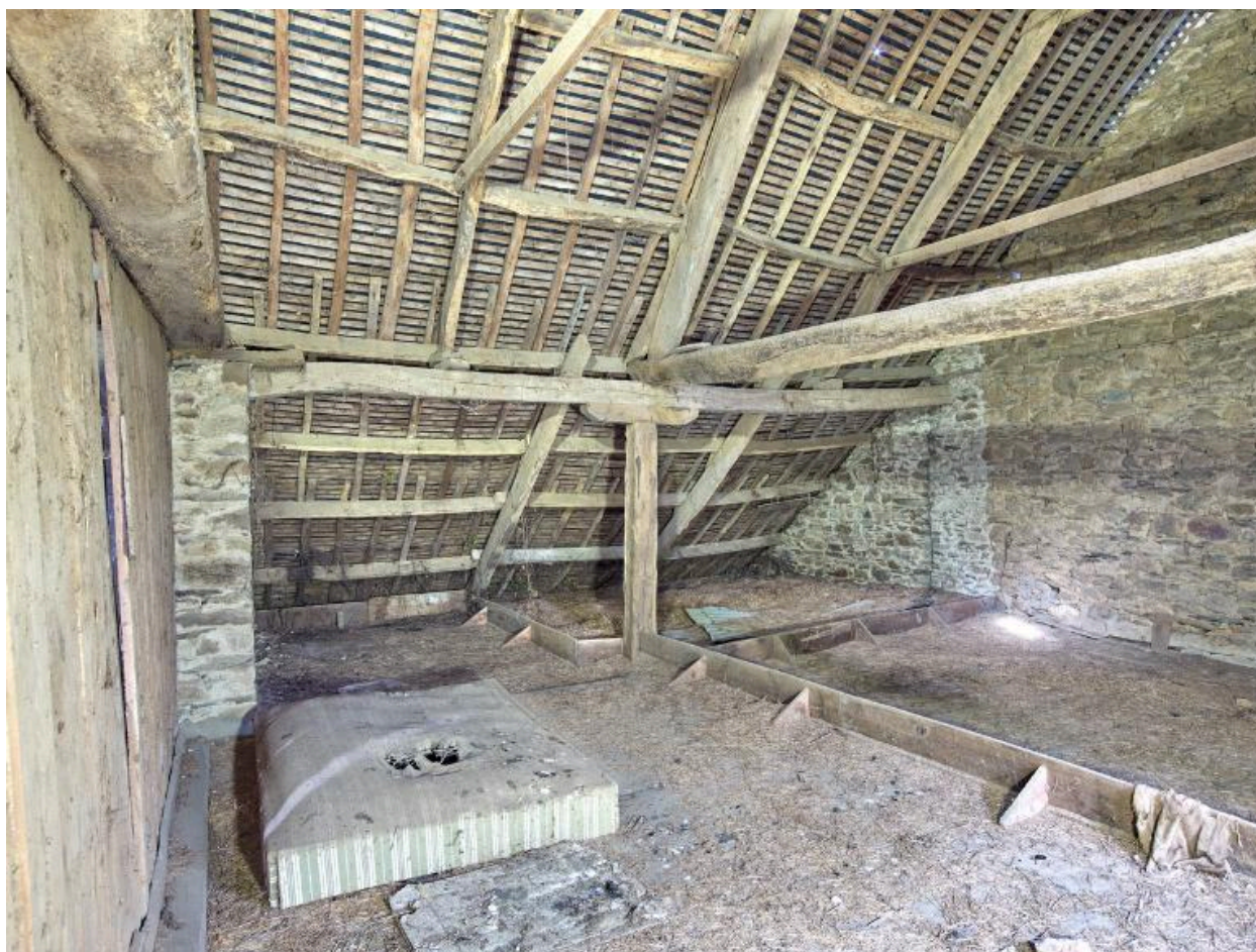
Logis début 17 e siècle. Grenier avec appentis postérieur dans le prolongement. Charpente avec ferme centrale reposant sur une sablière, elle-même soutenue par un poteau
