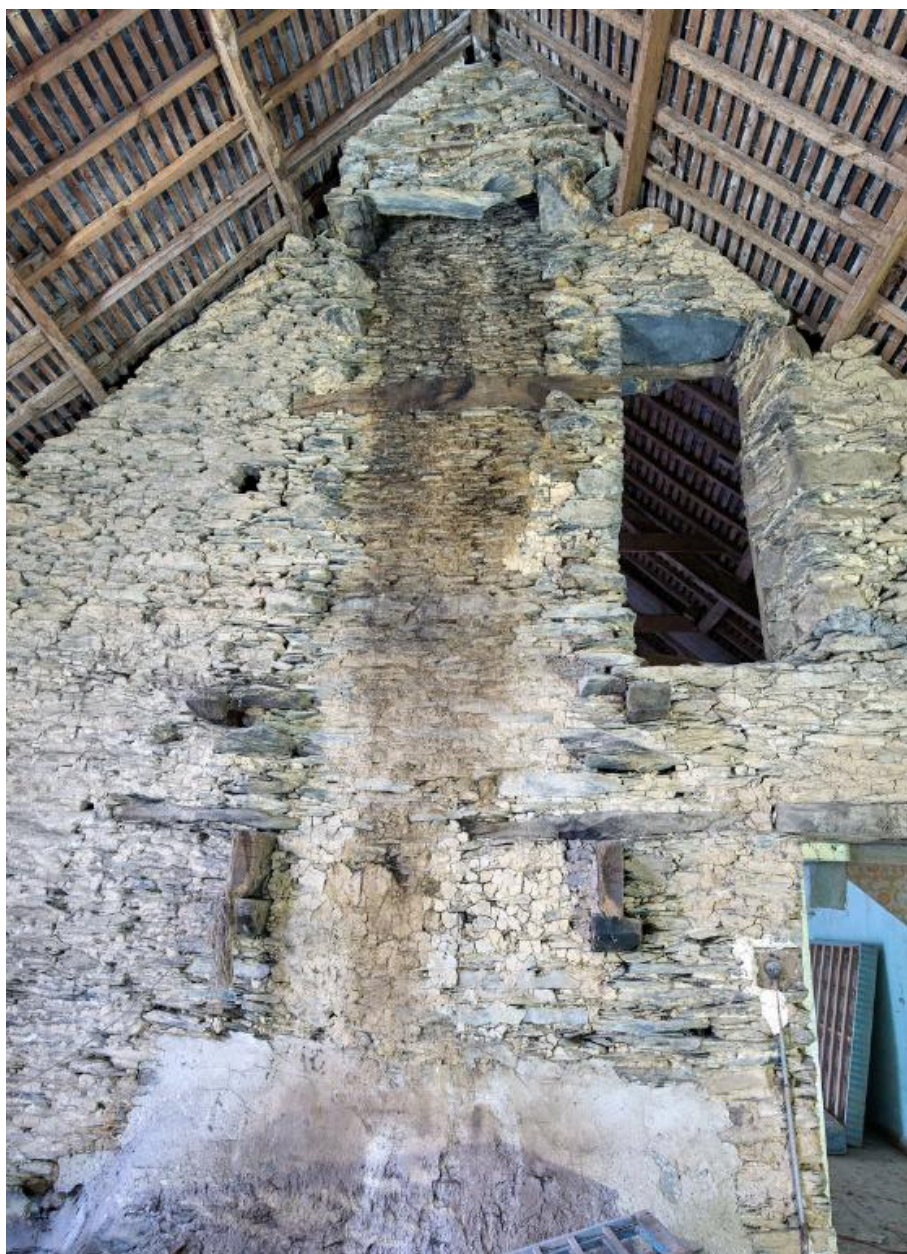
Logis début 17e siècle. Etage et combles. Mur de refend avec vestiges de cheminée et portes de communication avec le logis voisin
