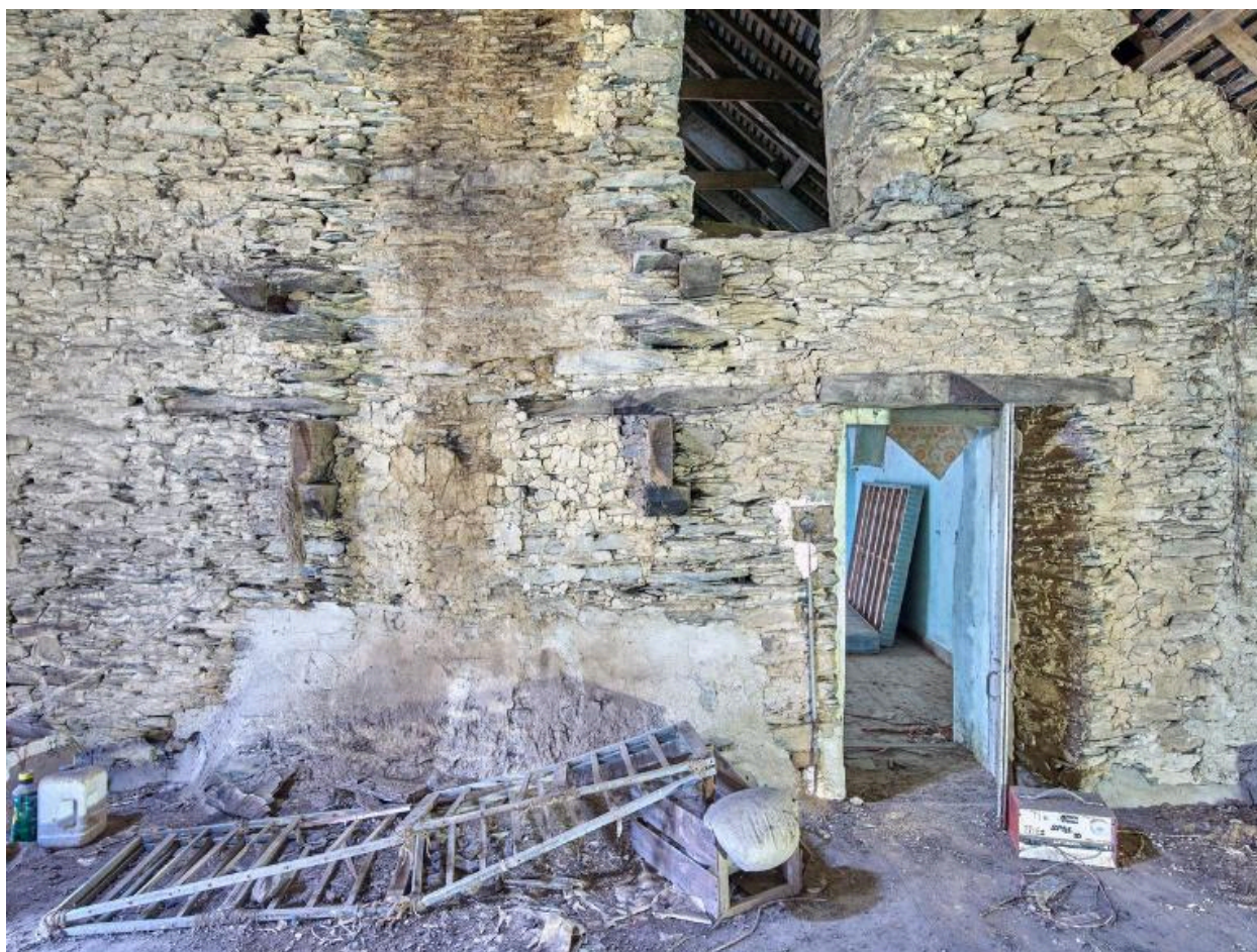
Logis début 17 e siècle. Etage et comble. Mur de refend avec vestiges de cheminée et portes de communication avec le logis voisin
