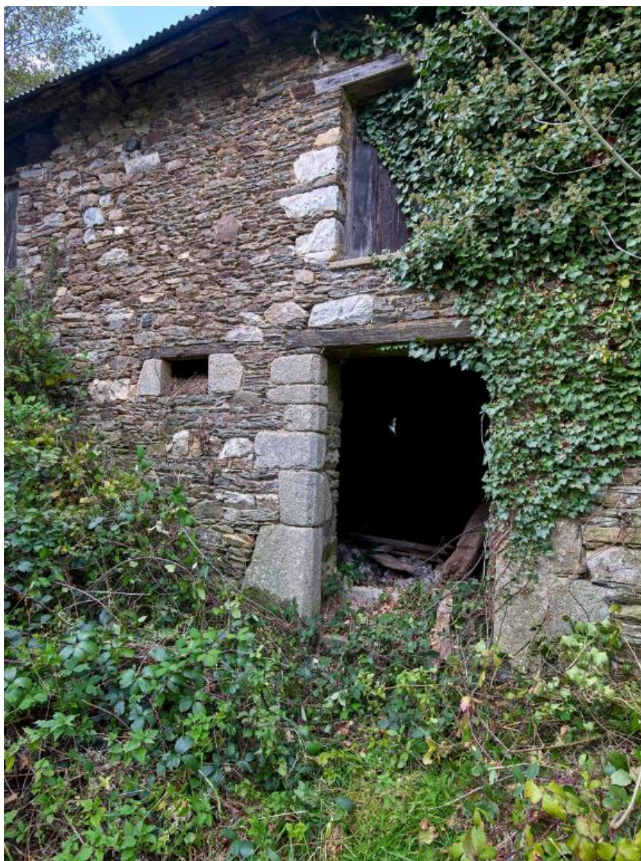
Ferme-blanchisserie voisine de la maison de marchand. Dépendance intégrée dans l'alignement. Détail de la porte surmontée d'une gerbière
