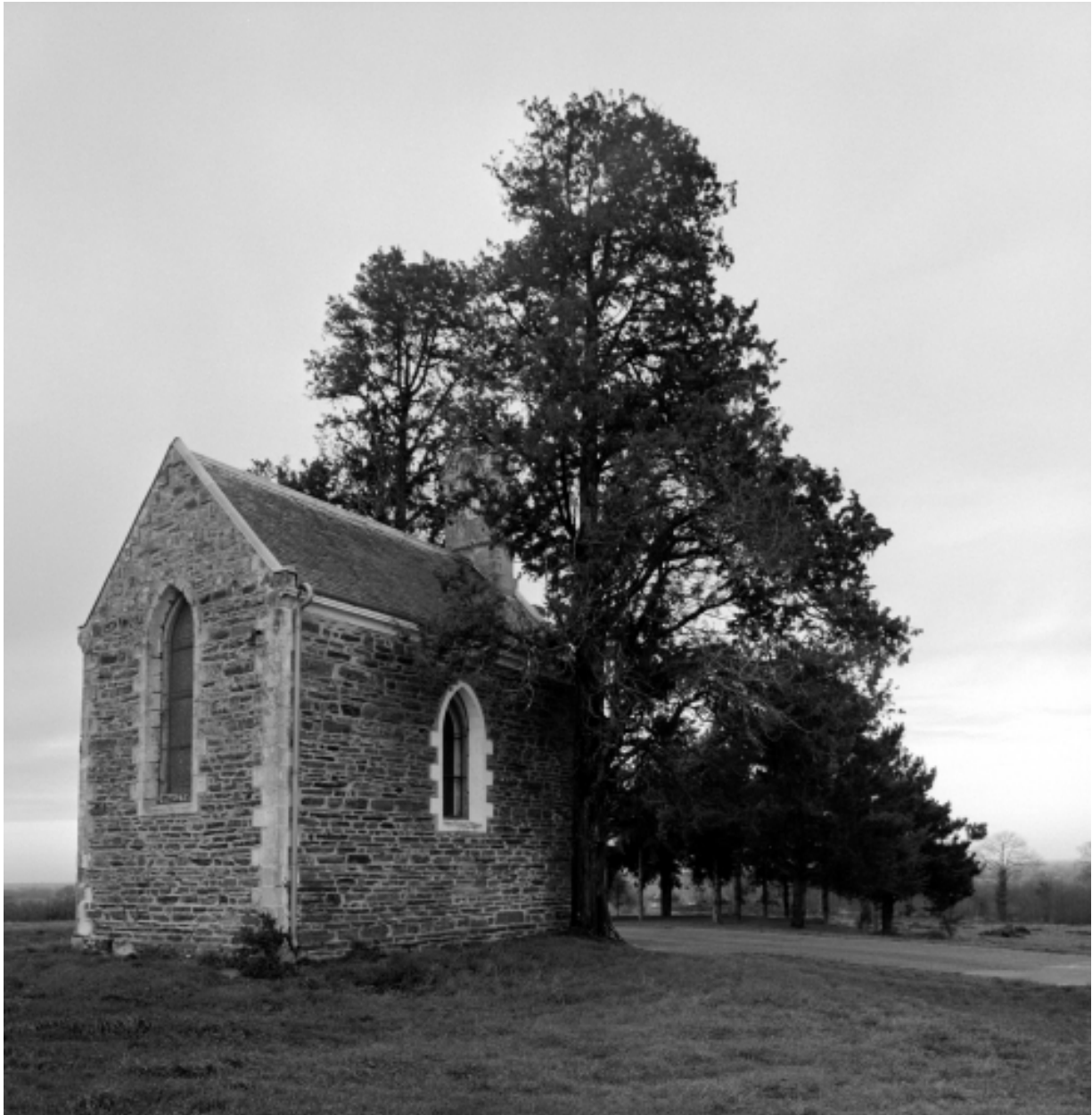
Elévation Est : vue générale
