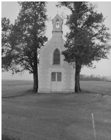
Elévation nord : vue générale Phot. Bernard Bègne, Phot. M. Loyon IVR53_19923500932X
