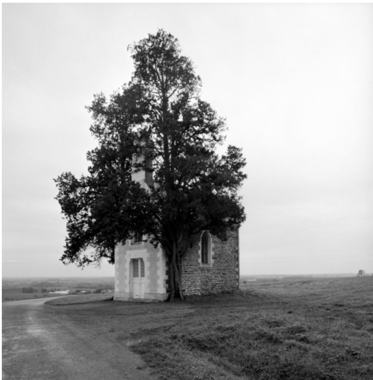
Elévation Ouest : vue de situation
