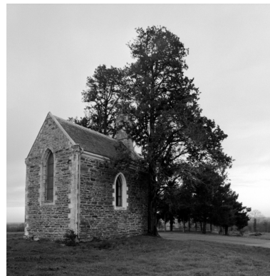
Elévation Est : vue générale Phot. Bernard Bègne, Phot. M. Loyon IVR53_19923500933X
