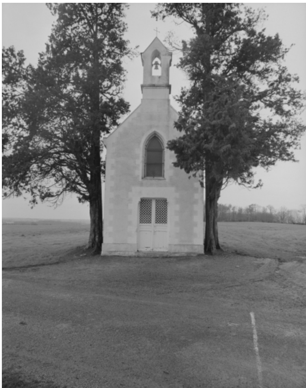
Elévation nord : vue générale
