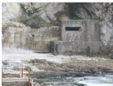
Vue générale de la casemate de Rulianec Phot. Guillaume Marie IVR53_20072908873NUCA
