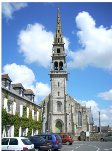
Ploudaniel, église Saint-Yves : élévation ouest Phot. Gwénaél Fauchille IVR53_20082905986NUCA
