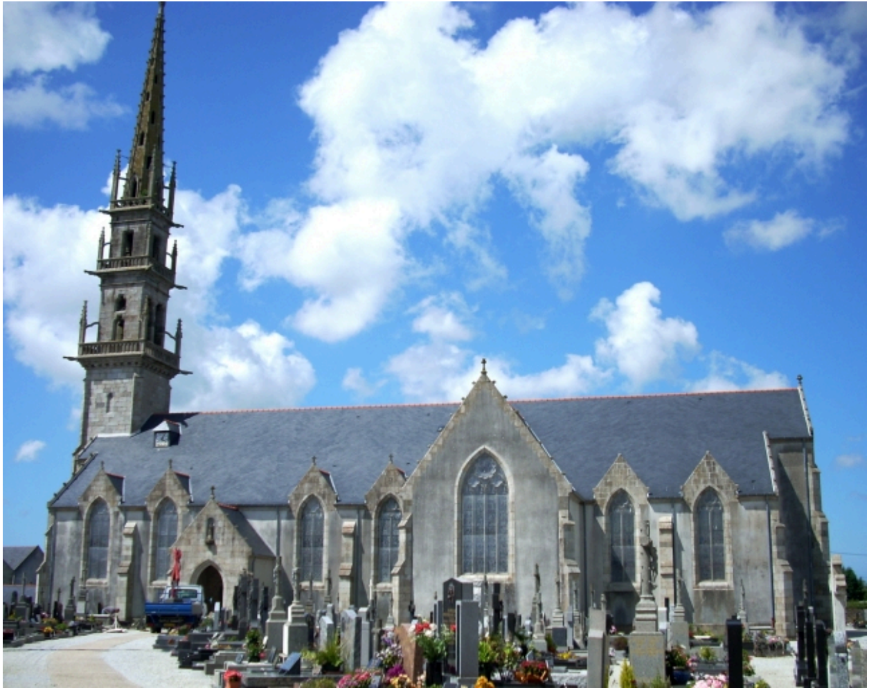
Ploudaniel, église Saint-Yves : vue générale sud
