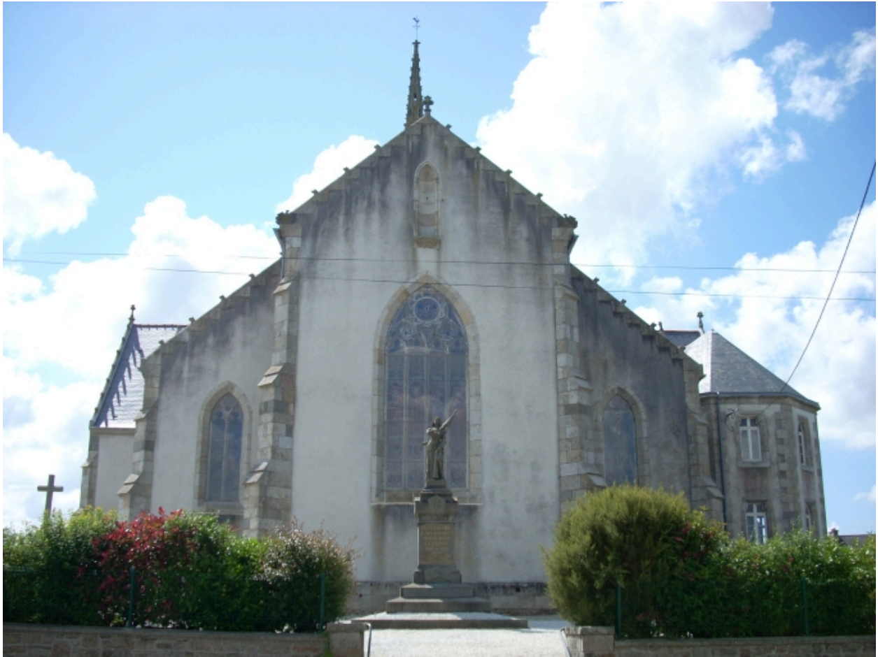
Ploudaniel, église paroissiale Saint-Yves : élévation est
