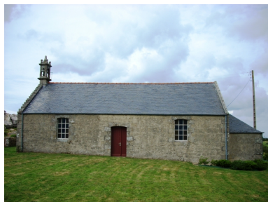
Landéda, chapelle Sainte-Marguerite : élévation sud Phot. Gwénaél Fauchille IVR53_20082906074NUCA
