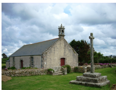
Landéda, chapelle Sainte-Marguerite : vue générale nord-ouest Phot. Gwénaél Fauchille IVR53_20082906072NUCA
