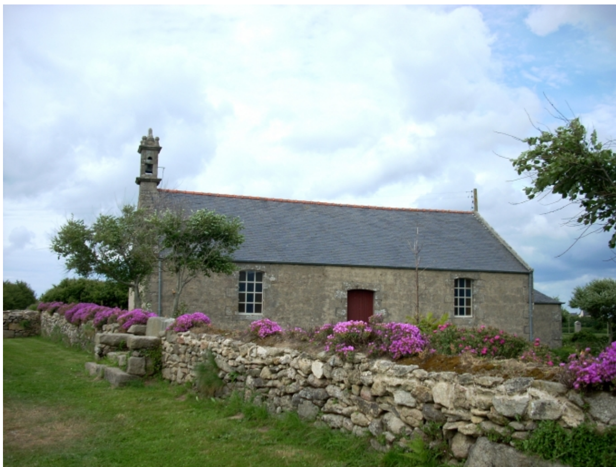
Landeda, chapelle Sainte-Marguerite : vue générale sud-ouest
