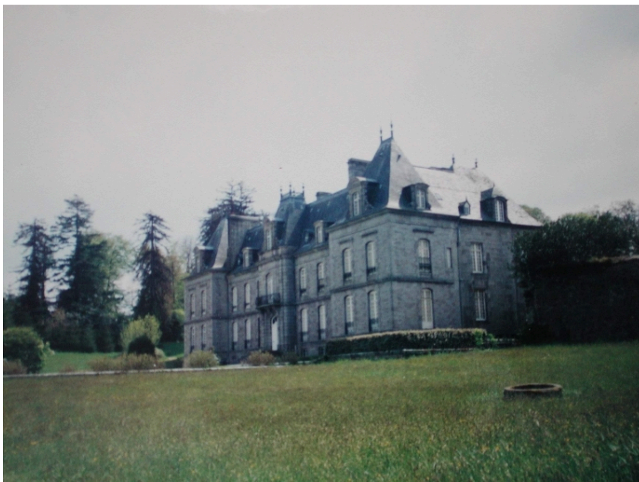
Vue générale de la façade du 19e siècle
