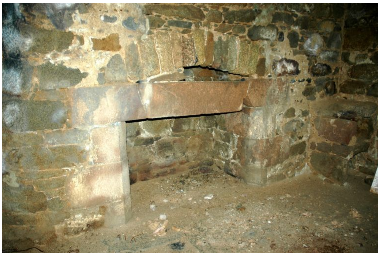
Vue de l'intérieur de la redoute, réduit de l'île aux Moines : cheminée du rez-de-chaussée
