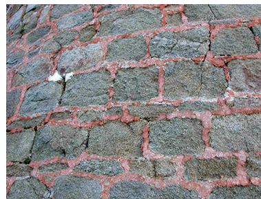
Vue de l'appareillage des pierres de la redoute de l'île aux Moines. La couleur rosée du joint vient de l'adjonction dans le mortier de poudre de brique
