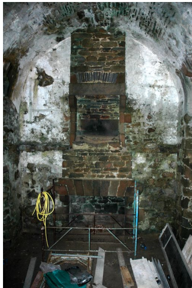
Vue de l'intérieur de la redoute, réduit de l'île aux Moines : corps de garde et casernement dotée de deux cheminées. Pièces voutées à l'épreuve de la bombe coupées sur la hauteur par un plancher sur solives de bois. Phot. Guillaume Lécueillier IVR53_20062210086NUCA
