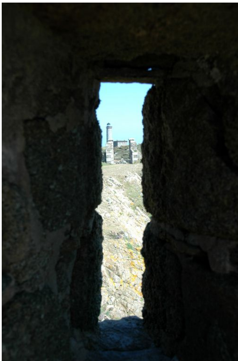
Vue de la redoute, réduit de l'île aux Moines : créneau de fusillade de la terrasse
