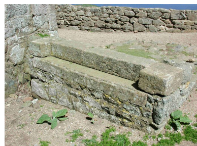
Vue de la pile du pont-levis de la redoute, réduit de l'île aux Moines Phot. Guillaume Lécueillier IVR53_20022202629NUCA
