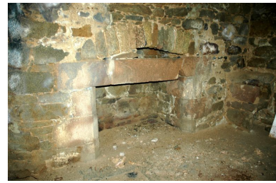
Vue de l'intérieur de la redoute, réduit de l'île aux Moines : cheminée du rez-de-chaussée Phot. Guillaume Lécueillier IVR53_20062210088NUCA
