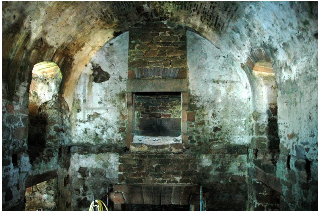
Vue de l'intérieur de la redoute, réduit de l'île aux Moines : corps de garde et casernement dotée de deux cheminées. Pièces voutées à l'épreuve de la bombe coupées sur la hauteur par un plancher sur solives de bois.
