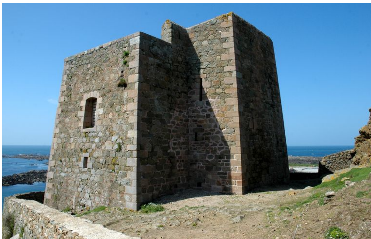
Vue de la redoute, réduit de l'île aux Moines depuis le Sud-ouest (état mai 2006 après restauration)
