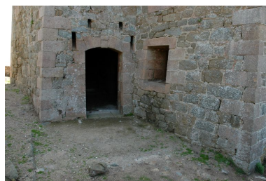
Vue de l'entrée fortifiée de la redoute, réduit de l'île aux Moines : deux baies flanquent l'entrée ainsi qu'un assommoir au dessus de la porte (état 2006 après restauration) Phot. Guillaume Lécueillier IVR53_20062210084NUCA
