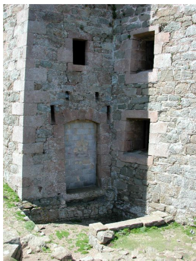
Vue de l'entrée fortifiée de la redoute, réduit de l'île aux Moines : deux baies flanquent l'entrée ainsi qu'un assommoir au dessus de la porte Phot. Guillaume Lécueillier IVR53_20022202627NUCA
