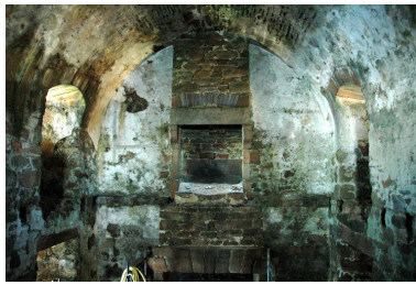
Vue de l'intérieur de la redoute, réduit de l'île aux Moines : corps de garde et casernement dotée de deux cheminées. Pièces voutées à l'épreuve de la bombe coupées sur la hauteur par un plancher sur solives de bois. Phot. Guillaume Lécueillier IVR53_20062210087NUCA
