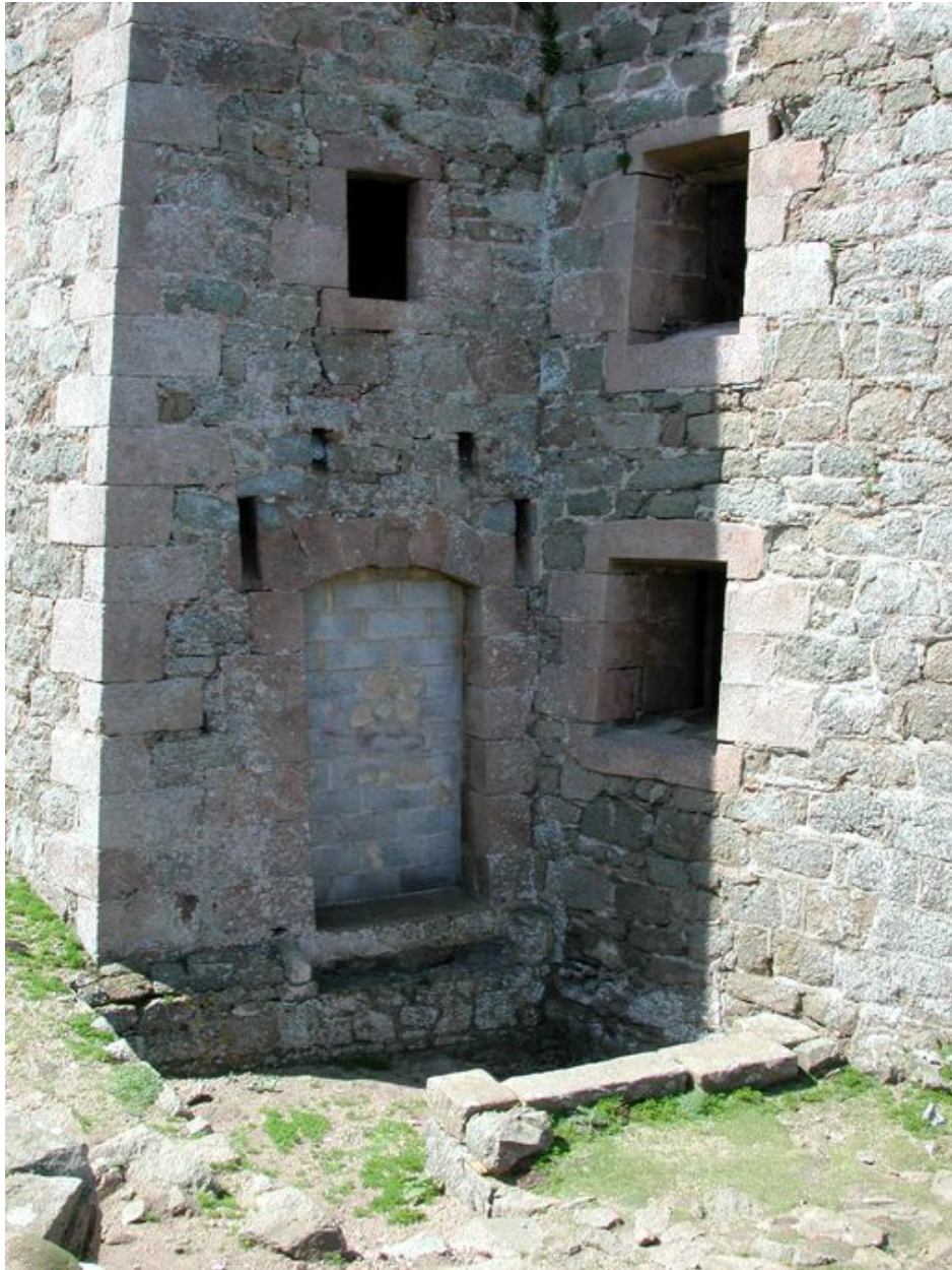
Vue de l'entrée fortifiée de la redoute, réduit de l'île aux Moines : deux baies flanquent l'entrée ainsi qu'un assommoir au dessus de la porte
