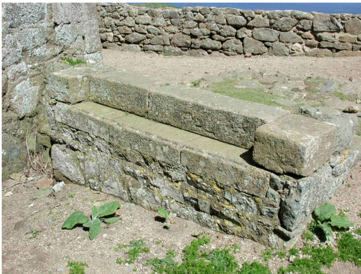
Vue de la pile du pont-levis de la redoute, réduit de l'île aux Moines
