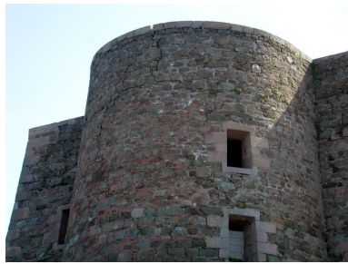
Vue de la redoute, réduit de l'île aux Moines depuis l'ouest Phot. Guillaume Lécueillier IVR53_20022202625NUCA
