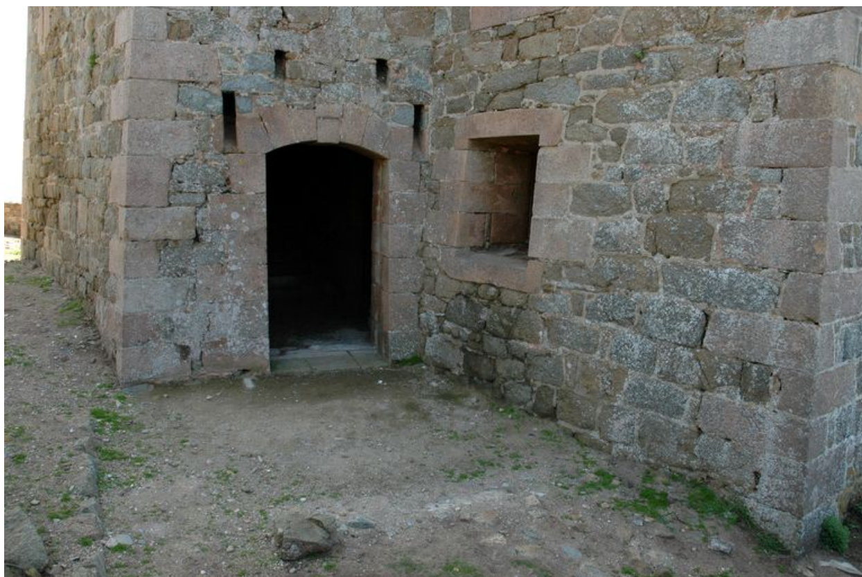
Vue de l'entrée fortifiée de la redoute, réduit de l'île aux Moines : deux baies flanquent l'entrée ainsi qu'un assommoir au dessus de la porte (état 2006 après restauration)
