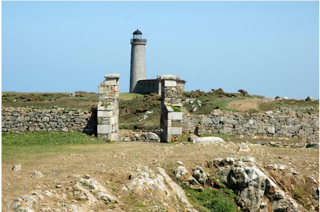
Vue de la porte du fort de l'île aux Moines depuis la terrasse de la redoute. En arrière plan : le phare
