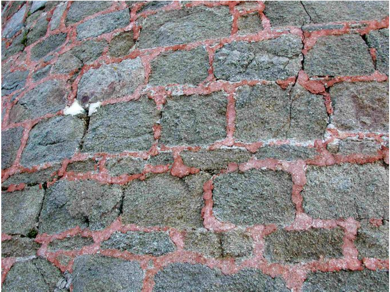
Vue de l'appareillage des pierres de la redoute de l'île aux Moines. La couleur rosée du joint vient de l'adjonction dans le mortier de poudre de brique
