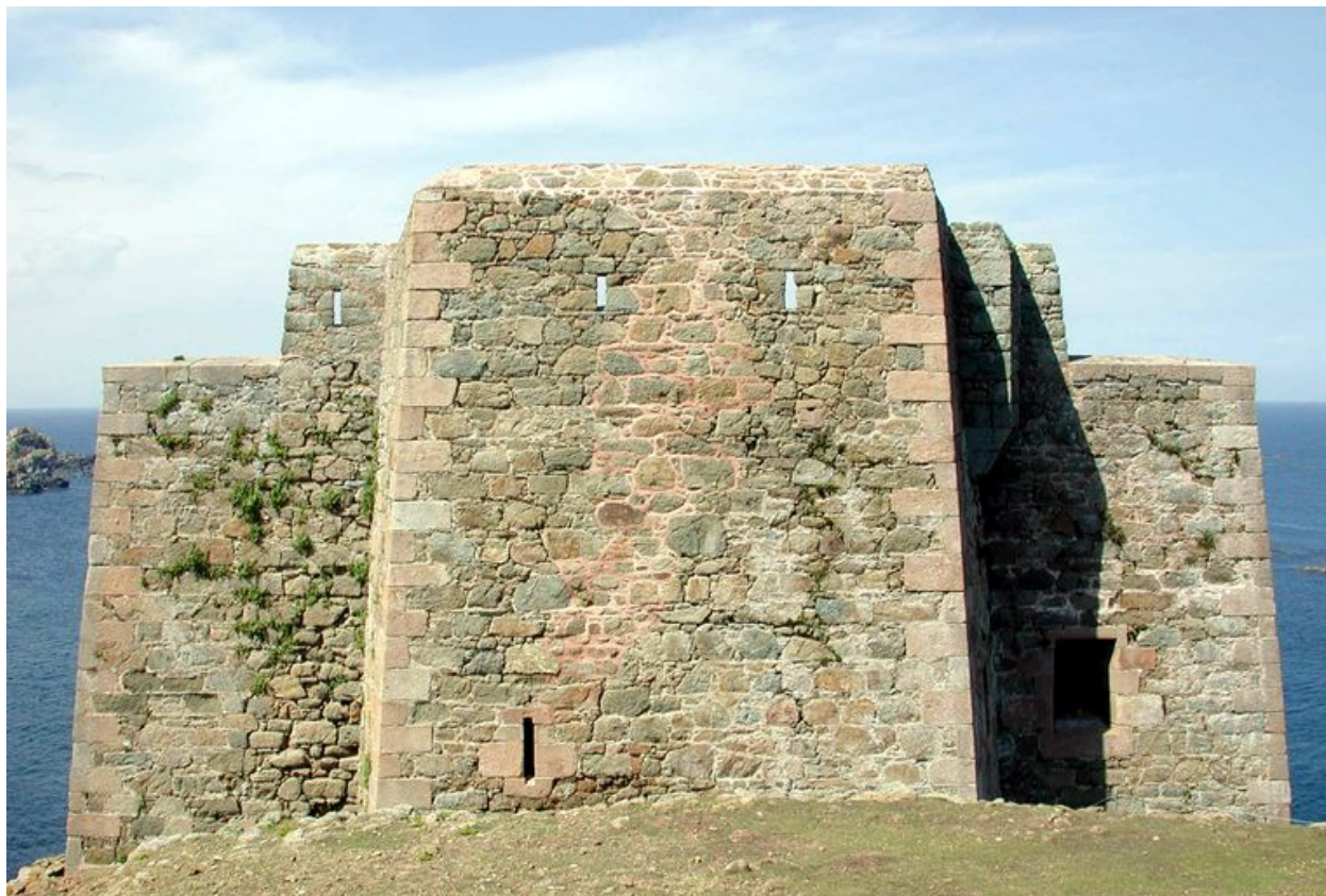
Vue de la redoute, réduit de l'île aux Moines depuis l'est
