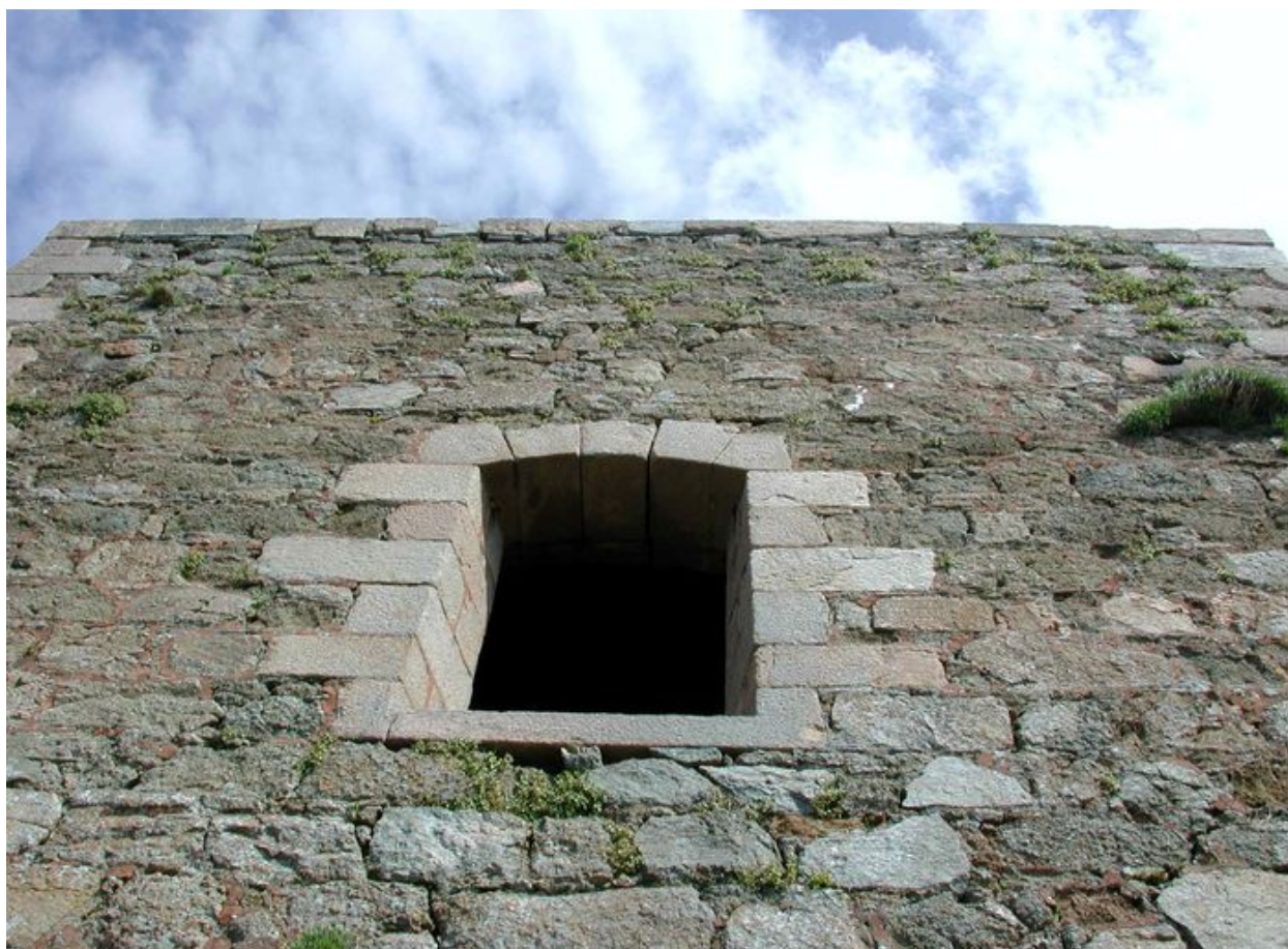
Vue de la baie sud de la redoute, réduit de l'île aux Moines
