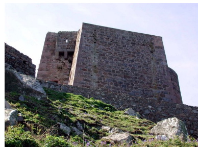
Vue de la redoute, réduit de l'île aux Moines depuis le nord Phot. Guillaume Lécueillier IVR53_20022202624NUCA
