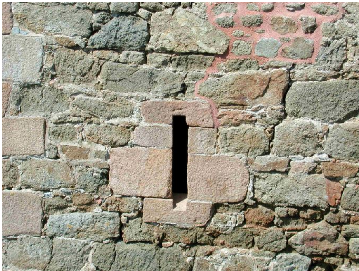
Vue de la meurtrière de la façade est de la redoute, réduit de l'île aux Moines. Cette meurtrière flanque le rocher en cas d'attaque par la gorge
