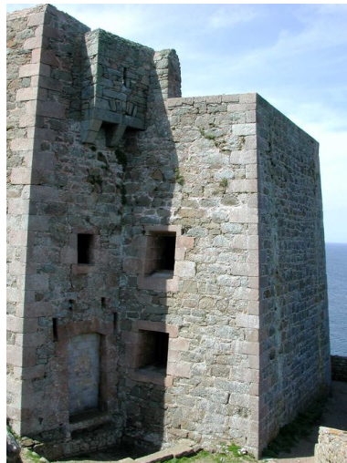
Vue de l'entrée fortifiée de la redoute, réduit de l'île aux Moines : deux baies flanquent la porte ainsi qu'un assommoir et une bretèche au dessus de la porte Phot. Guillaume Lécueillier IVR53_20022202626NUCA
