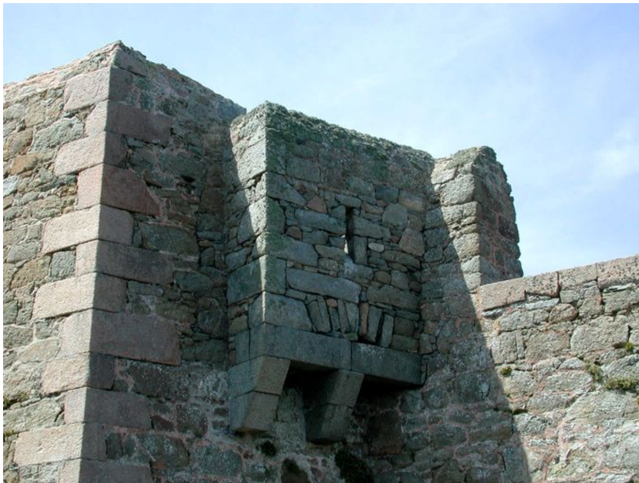
Vue de la bretèche flanquant le pont-levis de la redoute, réduit de l'île aux Moines
