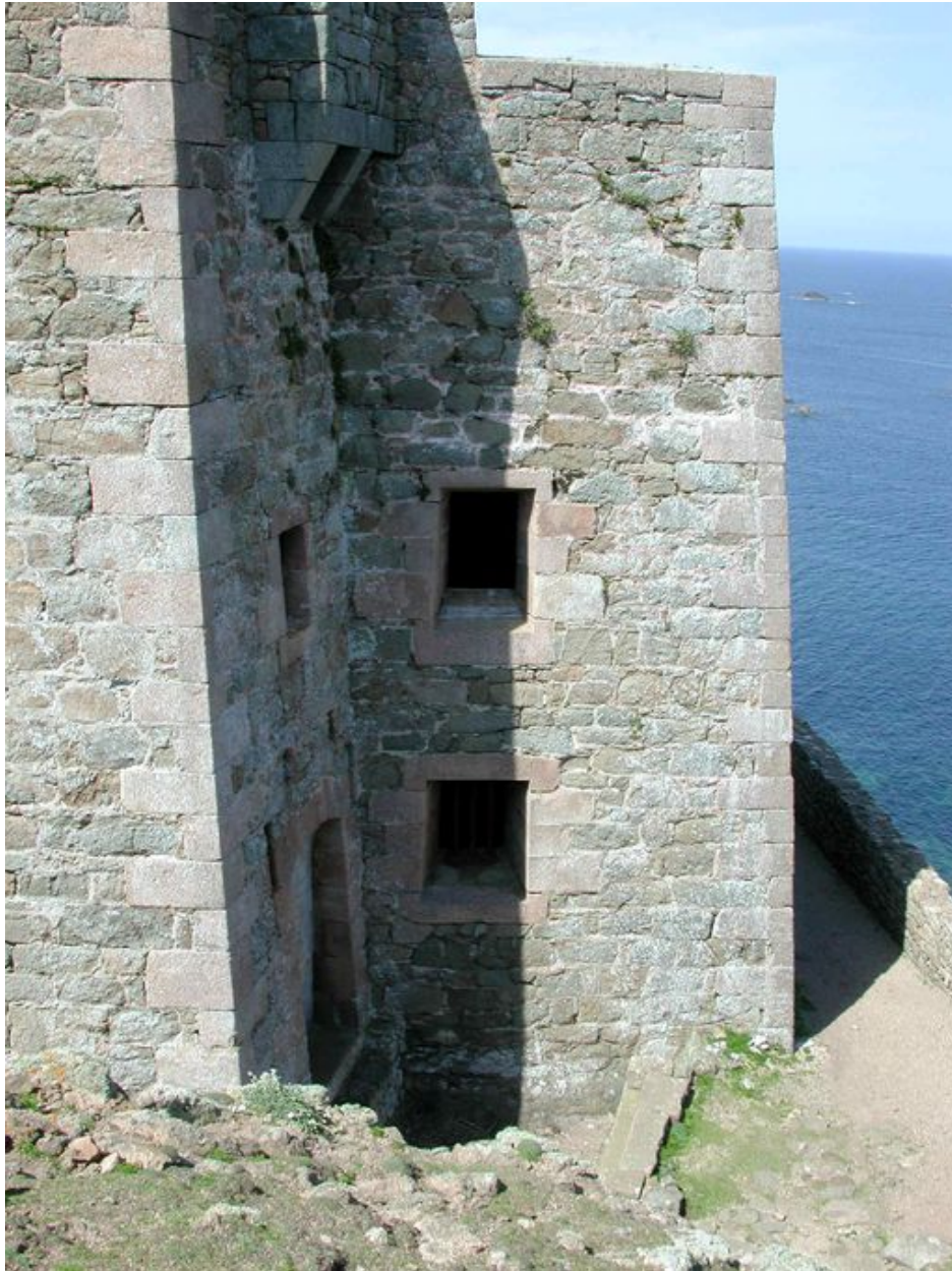
Vue de l'entrée fortifiée de la redoute, réduit de l'île aux Moines : deux baies flanquent la porte ainsi qu'un assommoir et une bretèche au dessus de la porte
