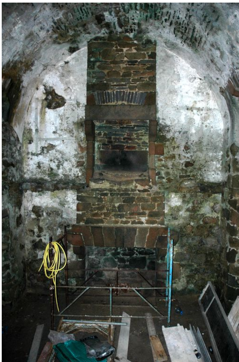
Vue de l'intérieur de la redoute, réduit de l'île aux Moines : corps de garde et casernement dotée de deux cheminées. Pièces voutées à l'épreuve de la bombe coupées sur la hauteur par un plancher sur solives de bois.
