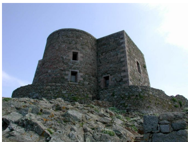
Vue de la redoute, réduit de l'île aux Moines depuis l'Ouest Phot. Guillaume Lécueillier IVR53_20022202621NUCA
