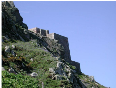
Vue de la redoute, réduit depuis la caserne de l'île aux Moines Phot. Guillaume Lécueillier IVR53_20022202617NUCA
