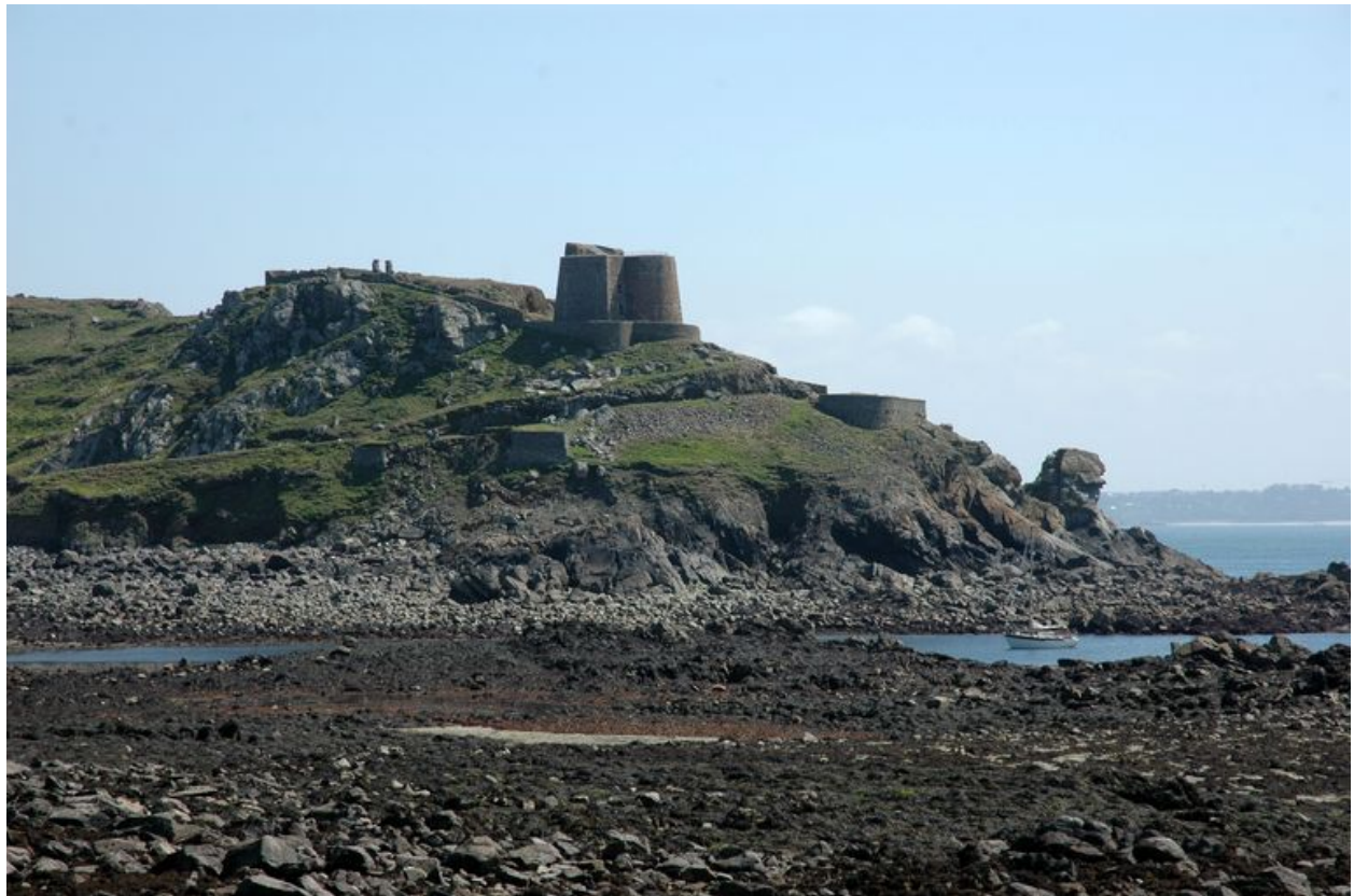
Vue de situation du fort et de la redoute, réduit de l'île aux Moines
