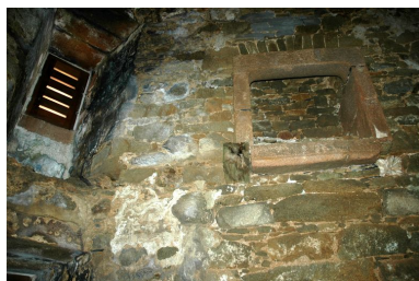
Vue de l'intérieur de la redoute, réduit de l'île aux Moines : cheminée et baie du premier étage Phot. Guillaume Lécueillier IVR53_20062210089NUCA
