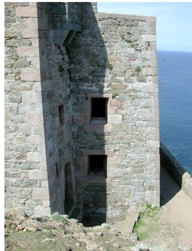
Vue de l'entrée fortifiée de la redoute, réduit de l'île aux Moines : deux baies flanquent la porte ainsi qu'un assommoir et une bretèche au dessus de la porte Phot. Guillaume Lécueillier IVR53_20022202628NUCA
