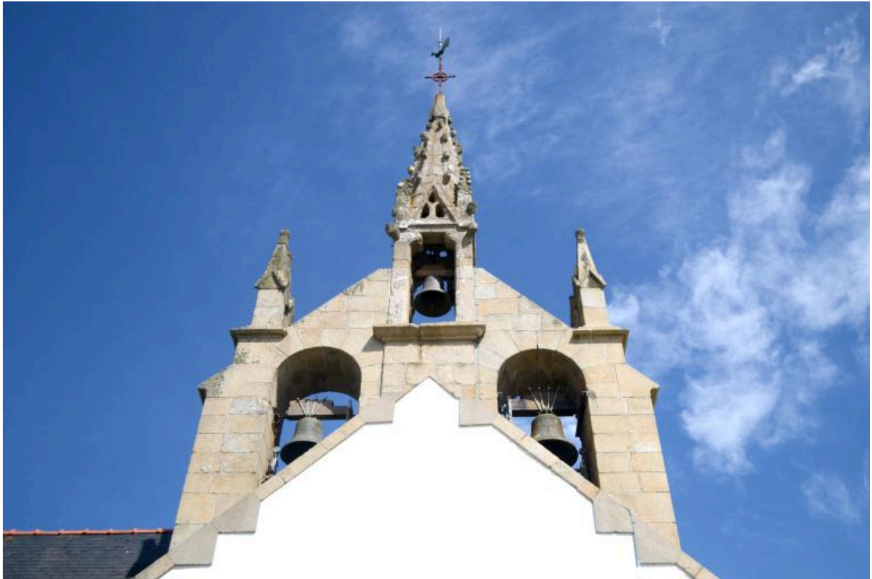
Détail du clocher, côté ouest. (2020)
