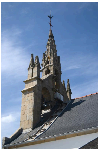
Détail du clocher, vue prise du sud-est. (2020) Phot. Laura Perthue IVR53_20202905802NUCA
