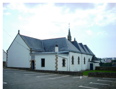
Vue générale prise du nord-est. (2008) Phot. Gwénaél Fauchille IVR53_20082906496NUCA
