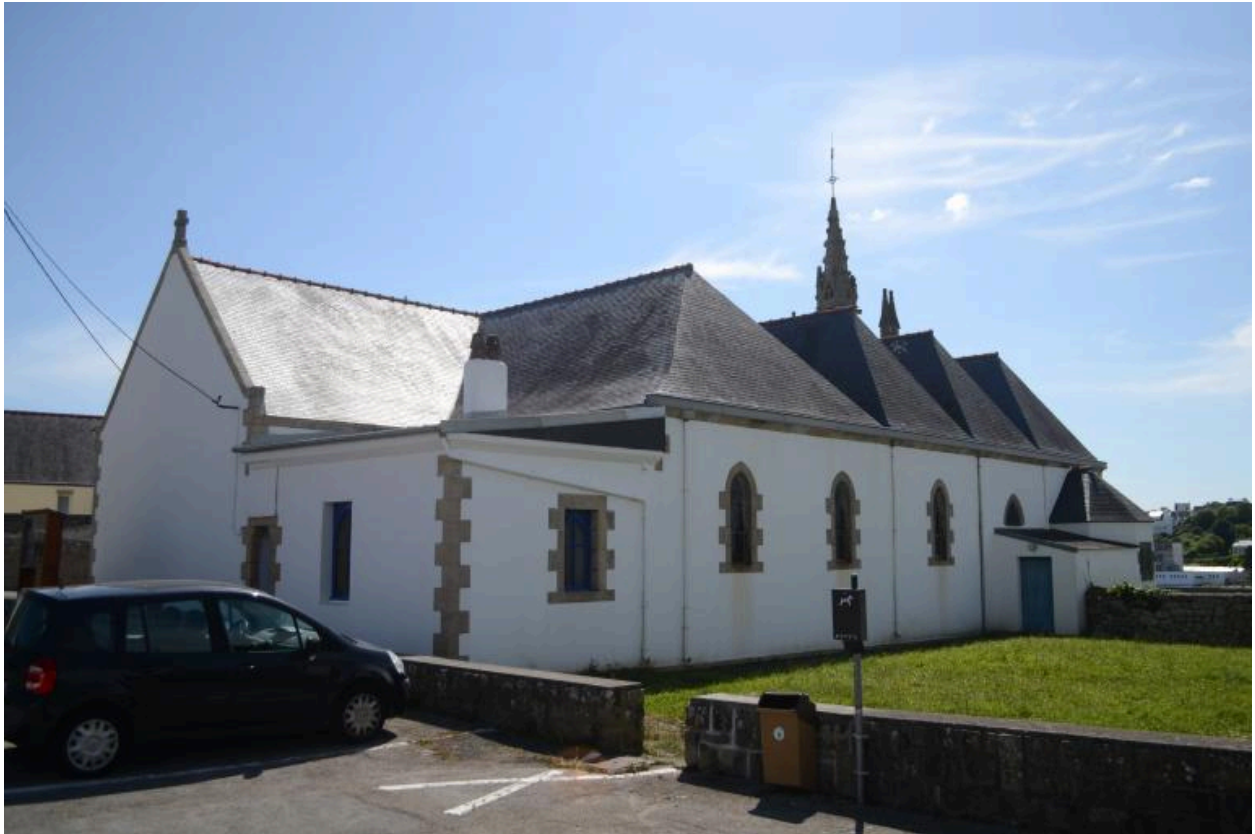
Vue générale prise du nord-est. (2020)
