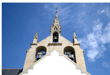
Détail du clocher, côté ouest. (2020) Phot. Laura Perthue IVR53_20202905791NUCA
