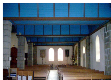
Bas-côté nord vue axiale ouest. (2008) Phot. Gwénaél Fauchille IVR53_20082905764NUCA
