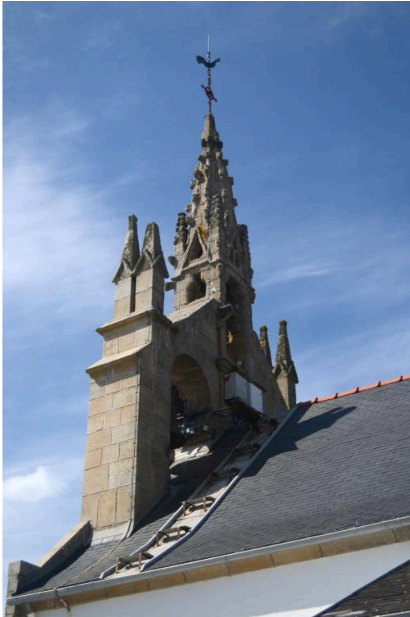
Détail du clocher, vue prise du sud-est. (2020)
