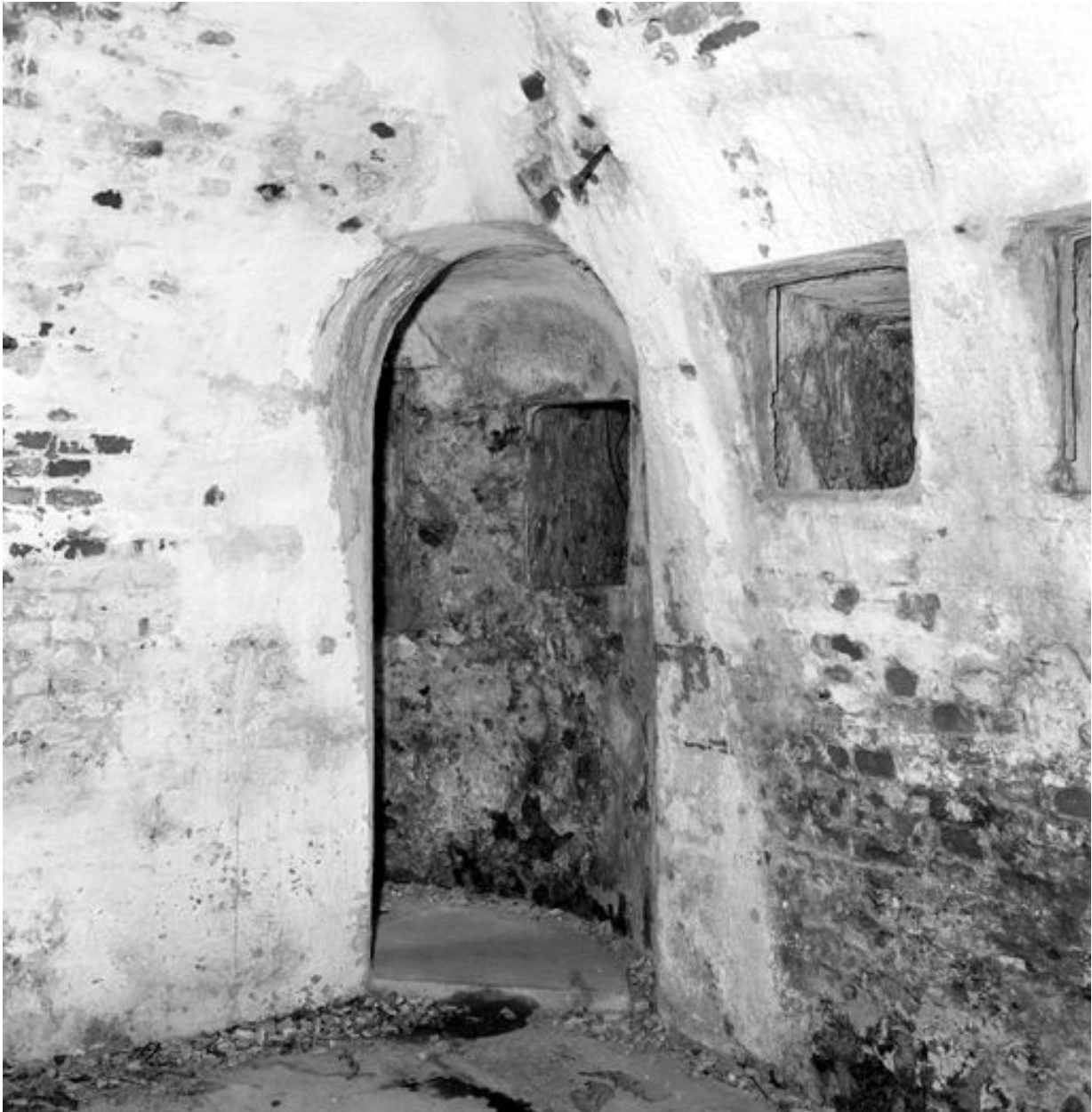
Vue de la tour-modèle n° 1 type 1811 de la pointe des Espagnols en 1969 : escalier intérieur
