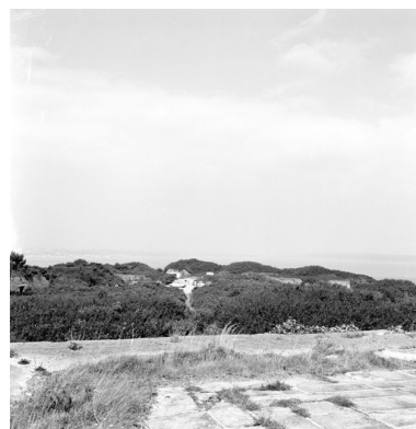
Vue de la tour-modèle n° 1 type 1811 de la pointe des Espagnols en 1969 : terrasse. Le parapet crénelé a été arasé pendant la Seconde Guerre Mondiale
