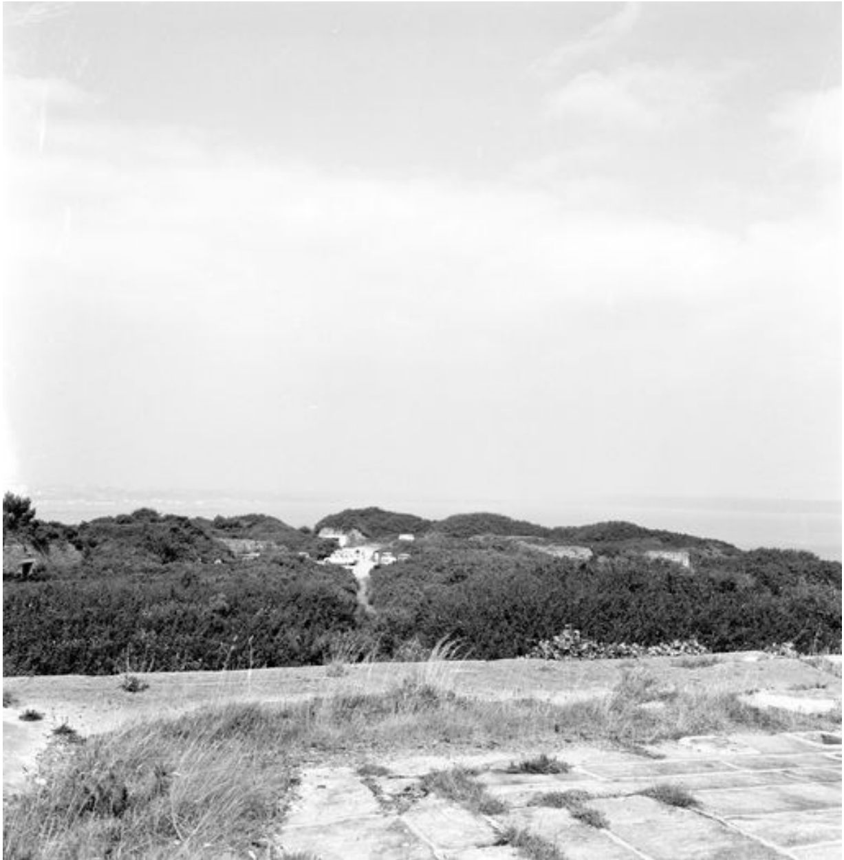
Vue de la tour-modèle n° 1 type 1811 de la pointe des Espagnols en 1969 : terrasse. Le parapet crénelé a été arasé pendant la Seconde Guerre Mondiale
