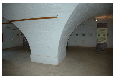
Vue de la tour-modèle n° 1 type 1811 de la pointe des Espagnols : intérieur Phot. Guillaume Lécueillier IVR53_20072906420NUCA
