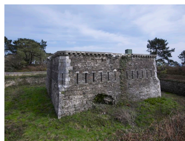
Roscanvel : vue de la tour-modèle n° 1 type 1811 de la pointe des Espagnols Phot. Bernard Bègne IVR53_20122900194NUCA
