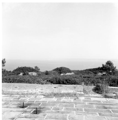
Vue de la tour-modèle n° 1 type 1811 de la pointe des Espagnols en 1969 : terrasse. Le parapet crénelé a été arasé pendant la Seconde Guerre Mondiale
