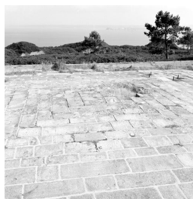
Vue de la tour-modèle n° 1 type 1811 de la pointe des Espagnols en 1969 : terrasse. Le parapet crénelé a été arasé pendant la Seconde Guerre Mondiale Phot. Guy Artur IVR53_19692900218X
