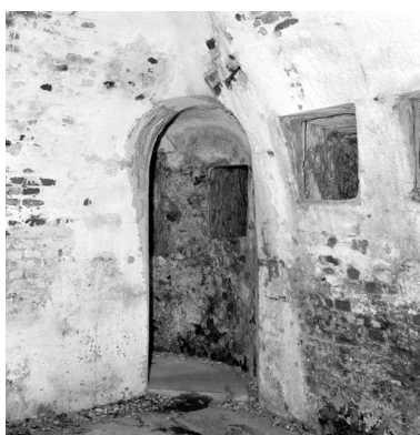
Vue de la tour-modèle n° 1 type 1811 de la pointe des Espagnols en 1969 : escalier intérieur Phot. Guy Artur IVR53_19692900212X
