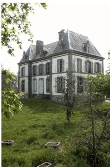
Vue nord-ouest Phot. Norbert Lambart IVR53_20073500594NUCA
