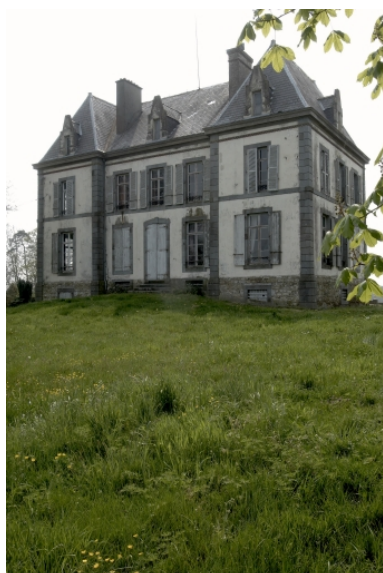
Vue nord-ouest Phot. Norbert Lambart IVR53_20073500593NUCA
