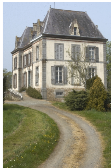
Vue sud-est Phot. Norbert Lambart IVR53_20073500592NUCA
