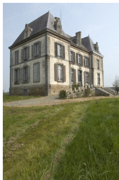
Vue sud-ouest Phot. Norbert Lambart IVR53_20073500597NUCA
