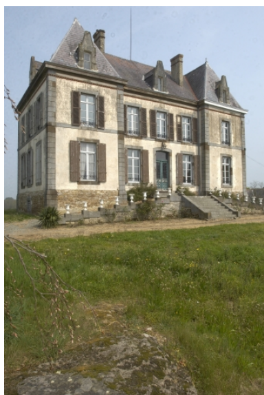
Vue sud-ouest Phot. Norbert Lambart IVR53_20073500598NUCA
