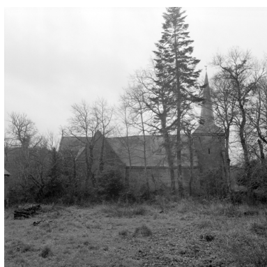
Vue de situation prise du nord Phot. Brachet IVR53_19675602695X
