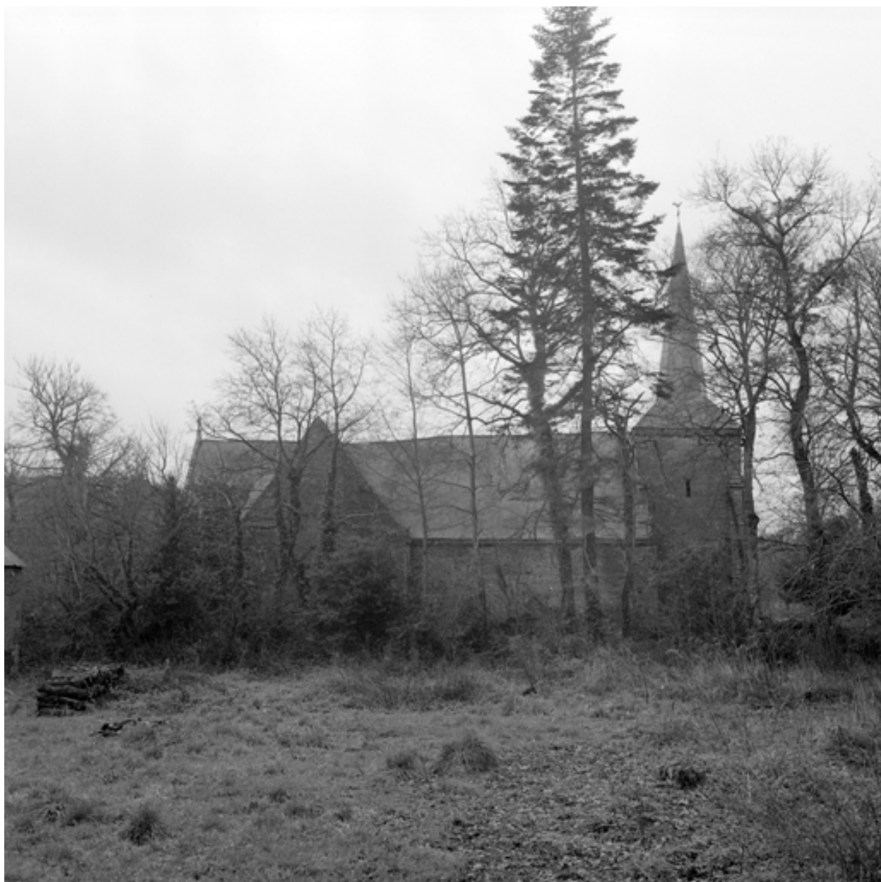
Vue de situation prise du nord
