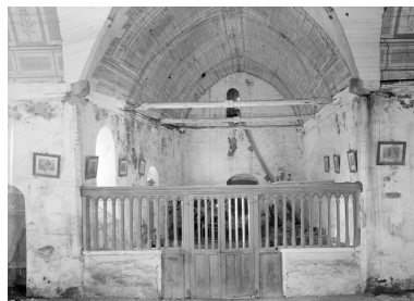
Nef et clôture du chœur : vue axiale est-ouest Phot. Brachet IVR53_19675602687V
