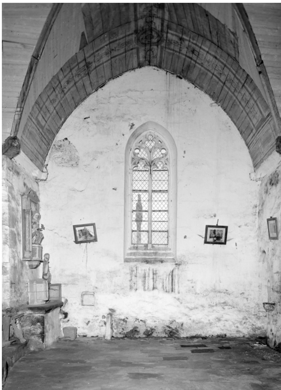
Bras sud du transept : vue axiale nord-sud
