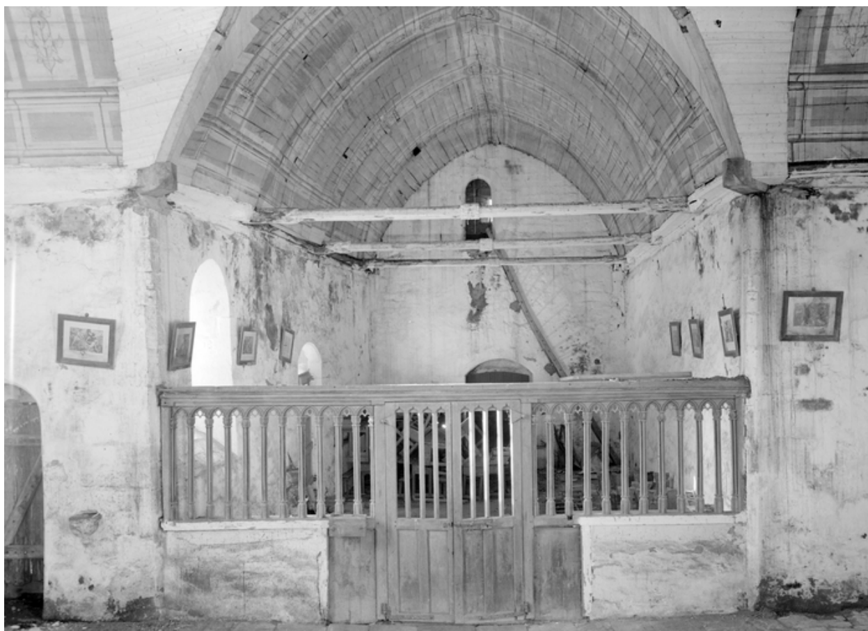
Nef et clôture du choeur : vue axiale est-ouest
