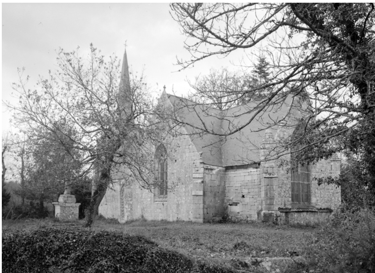
Vue de situation prise du sud-est
