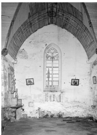
Bras sud du transept : vue axiale nord-sud Phot. Brachet IVR53_19675602690V
