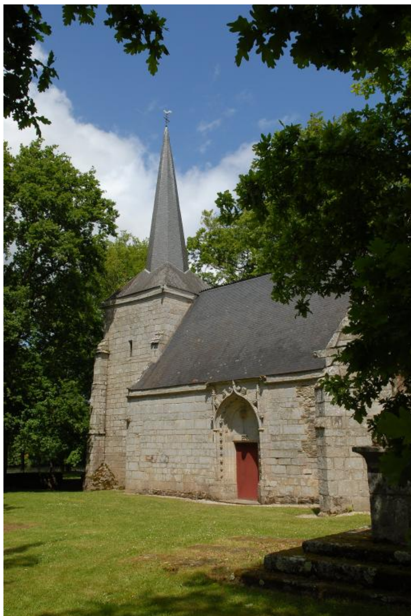
Vue de situation prise du sud-est
