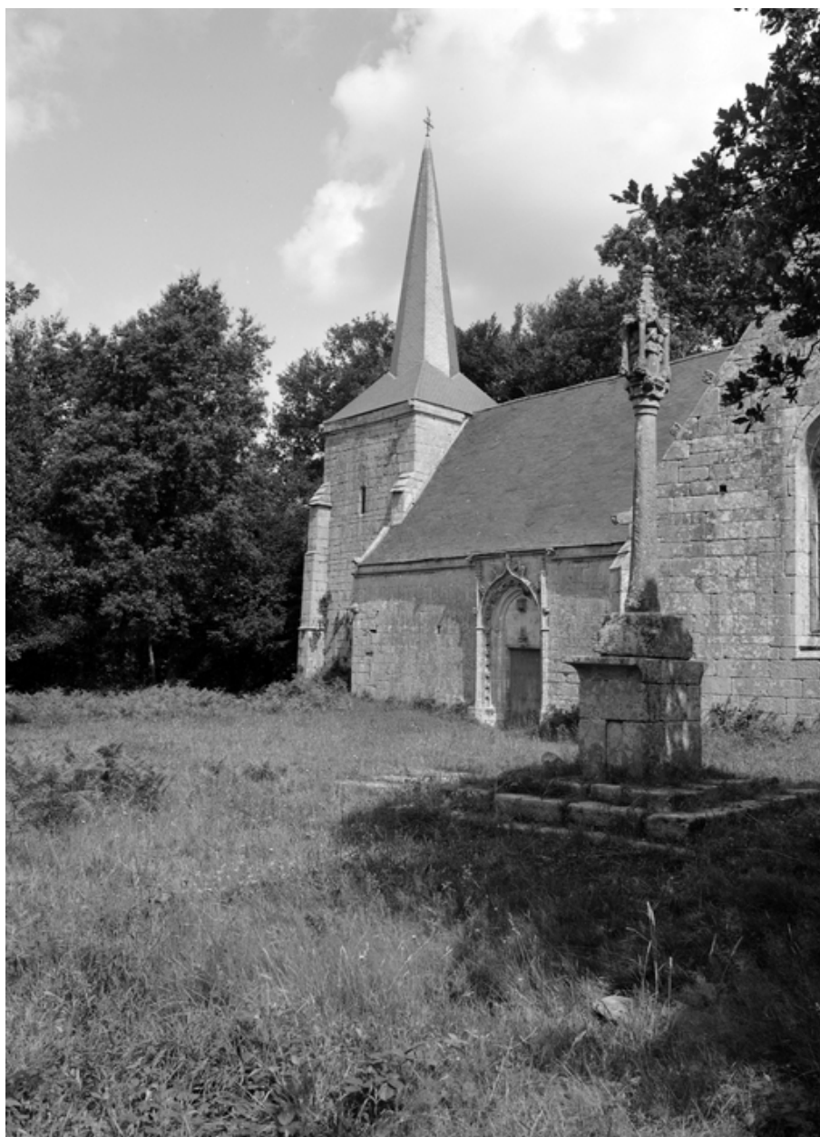
Vue de situation prise du sud-est
