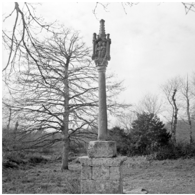
Croix au sud de la chapelle : vue d'ensemble de la face est Phot. Brachet IVR53_19675602681X
