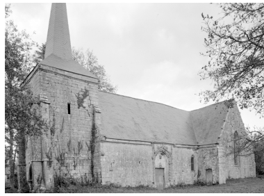
Vue d'ensemble de la façade sud Phot. Brachet IVR53_19675602834V
