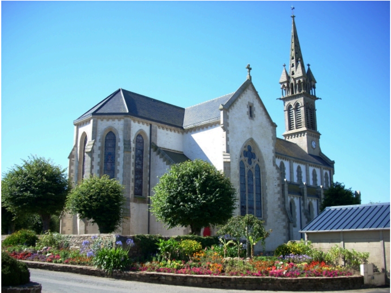
Henvic, église paroissiale Saint-Maudez et Sainte-Juvette : vue générale nord-est
