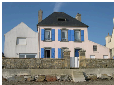
Vue générale de la Maison Tertu Phot. Clotilde Buhot IVR53_20062908580NUCA
