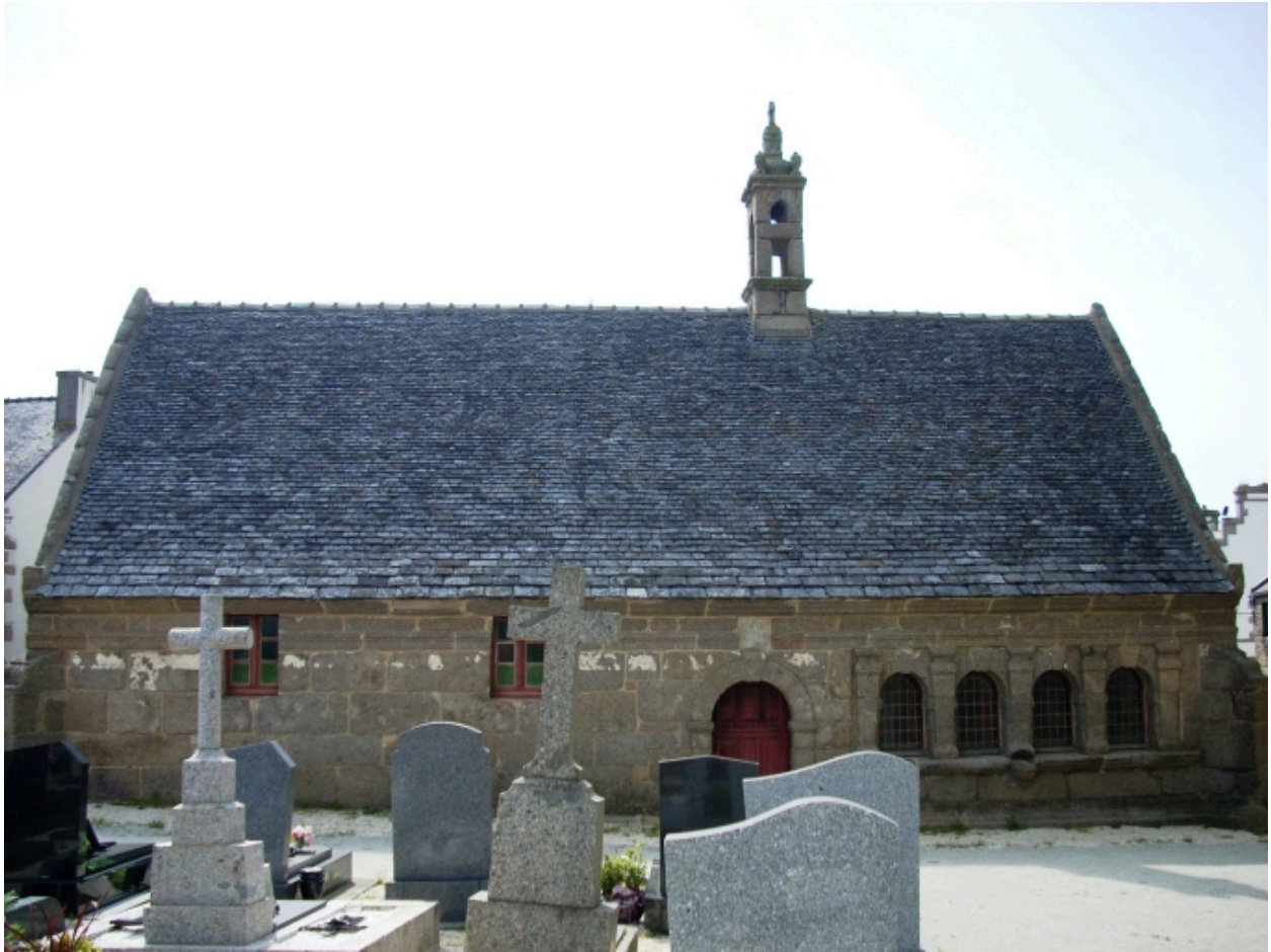
Plouarzel, église paroissiale : élévation est de l'ossuaire
