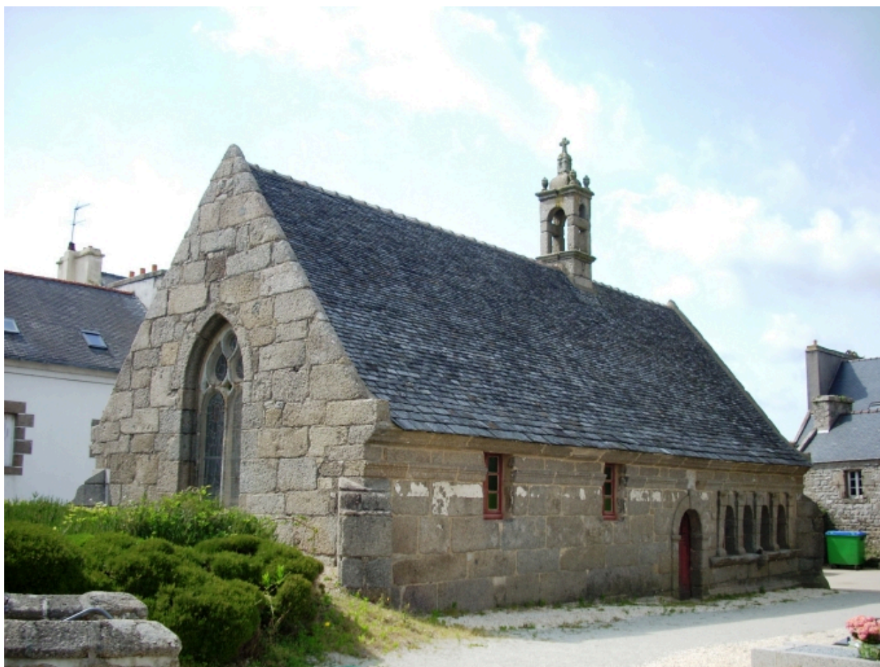
Plouarzel, église paroissiale : vue générale sud-est de l'ossuaire
