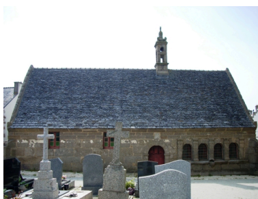
Plouarzel, église paroissiale : élévation est de l'ossuaire Phot. Gwénaél Fauchille IVR53_20082906229NUCA
