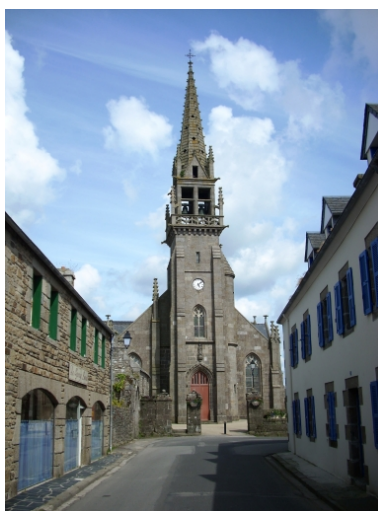
Plouarzel, église paroissiale : élévation ouest Phot. Gwénaél Fauchille IVR53_20082906226NUCA
