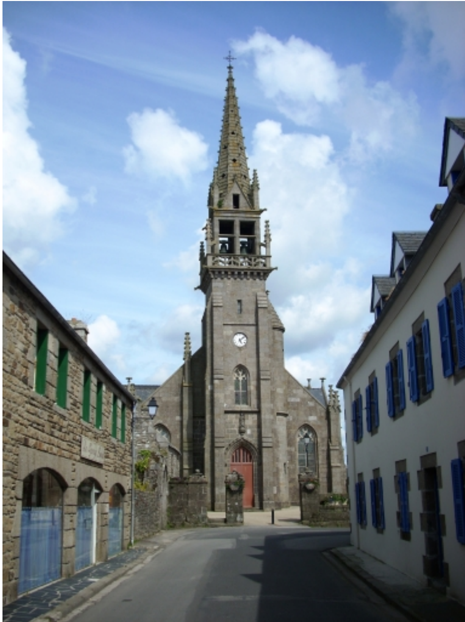
Plouarzel, église paroissiale : élévation ouest
