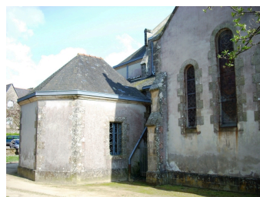
Douarnenez, église paroissiale Saint-Joseph de Tréboul : sacristie vue du nord-ouest Phot. Gwénaél Fauchille IVR53_20082905968NUCA
