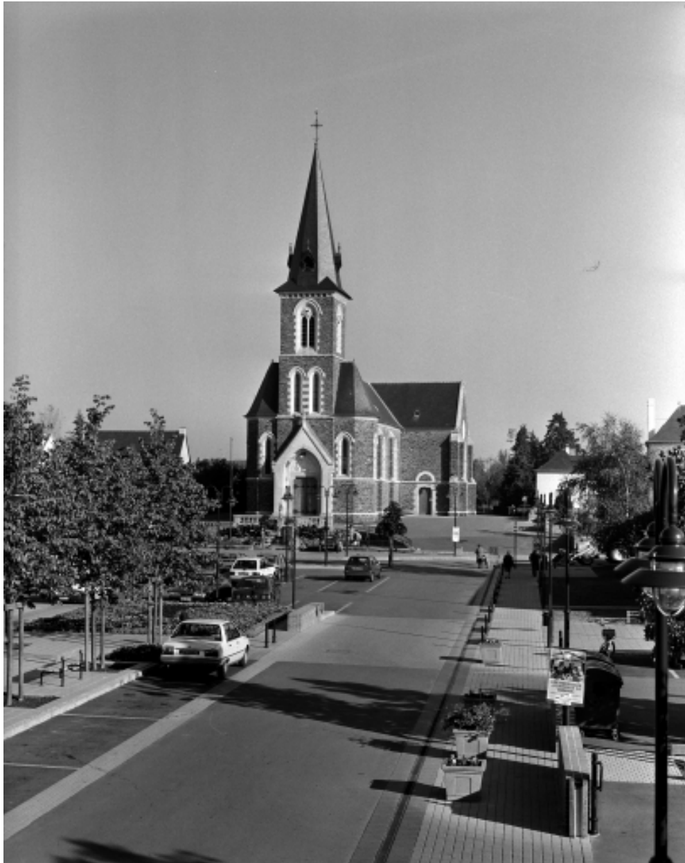
Elévation Sud : vue générale
