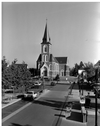
Elévation Sud : vue générale Phot. Norbert Lambart IVR53_19943501893X
