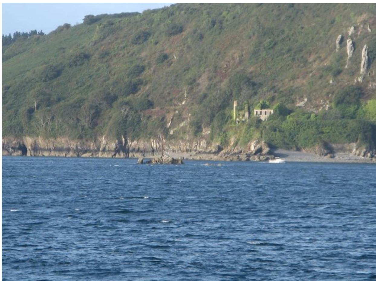
Batterie basse de la pointe des Espagnols
