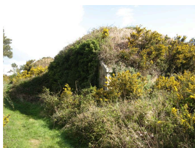
Batterie extérieure de droite de la pointe des Espagnols (côté rade) Phot. Guillaume Marie IVR53_20082908423NUCA
