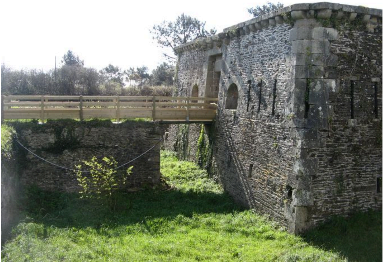
Tour-réduit de la pointe des Espagnols
