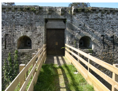
Tour-réduit de la pointe des Espagnols Phot. Guillaume Marie IVR53_20082908421NUCA
