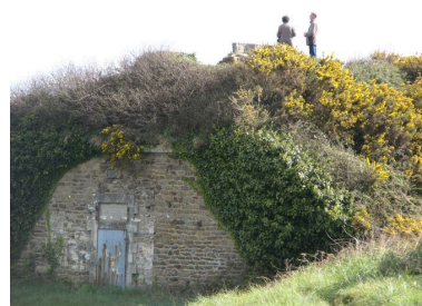
Batterie intérieure de la pointe des Espagnols Phot. Guillaume Marie IVR53_20082908422NUCA
