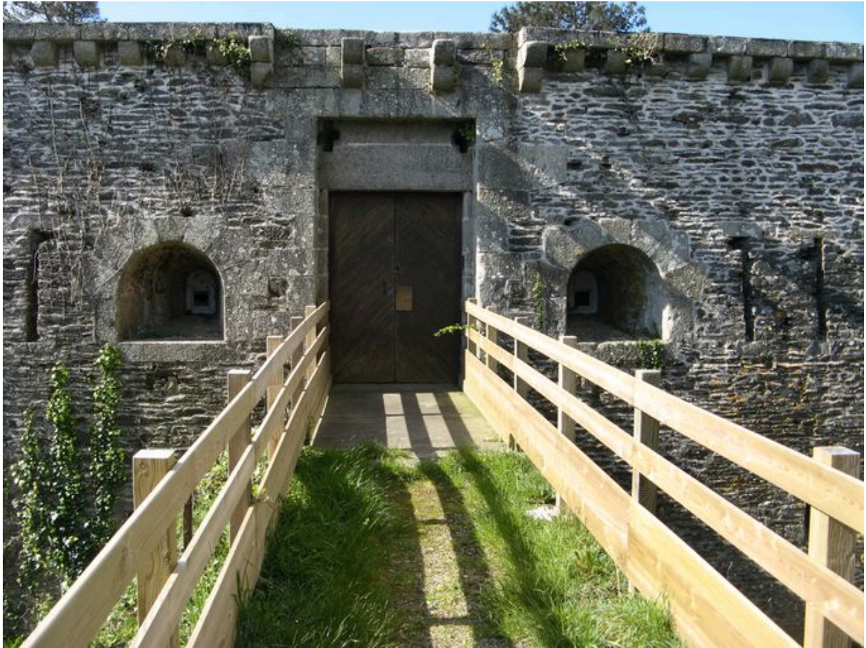
Tour-réduit de la pointe des Espagnols
