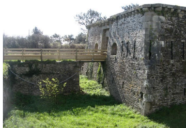
Tour-réduit de la pointe des Espagnols Phot. Guillaume Marie IVR53_20082908420NUCA
