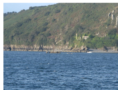
Batterie basse de la pointe des Espagnols
