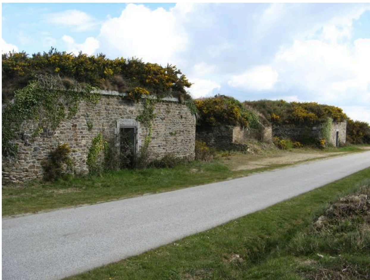
Batterie extérieure de gauche du goulet (pointe des Espagnols)
