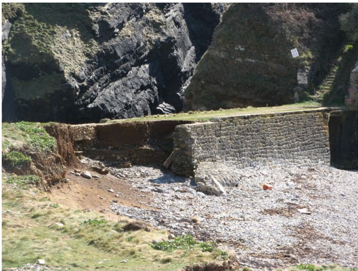
Digue permettant l'accès à l'îlot du Diable
