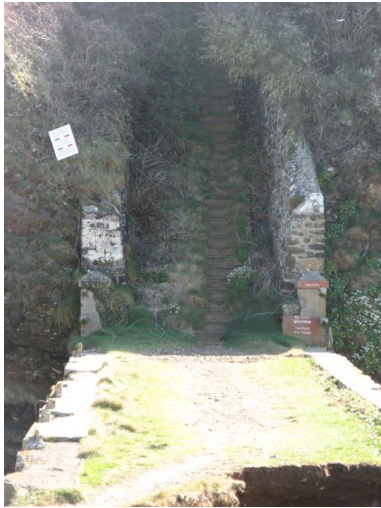
Escalier d'accès à l'îlot du Diable Phot. Guillaume Marie IVR53_20082908472NUCA
