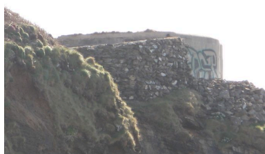
Abri du projecteur de l'îlot du Diable Phot. Guillaume Marie IVR53_20082908469NUCA
