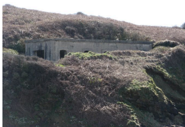
Usine électrique de l'îlot du Diable servant à l'alimentation du projecteur Phot. Guillaume Marie IVR53_20082908471NUCA
