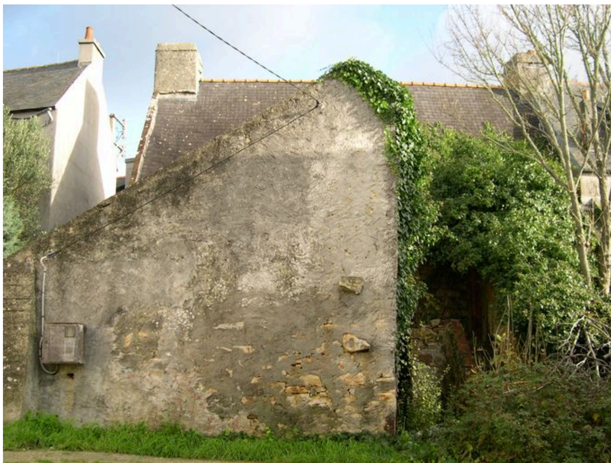
Vue arrière du n° 1 rue Saint-Pol-Roux
