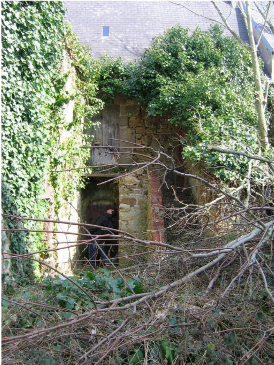
Escaliers à l'arrière du n° 1 rue Saint-Pol-Roux
