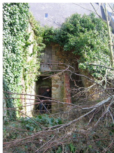
Escaliers à l'arrière du n° 1 rue Saint-Pol-Roux
