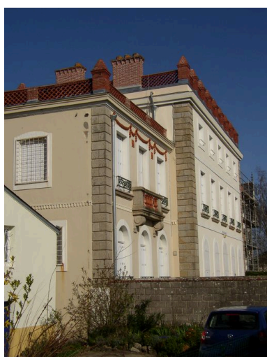
Vue latérale de la Villa Kerozen Phot. Johan Vincent IVR53_20065606557NUCA
