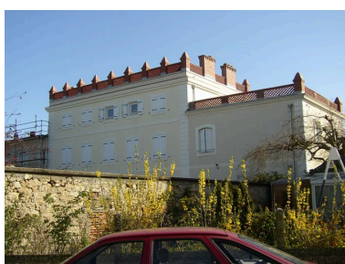
Vue arrière de la Villa Kerozen Phot. Johan Vincent IVR53_20065606558NUCA
