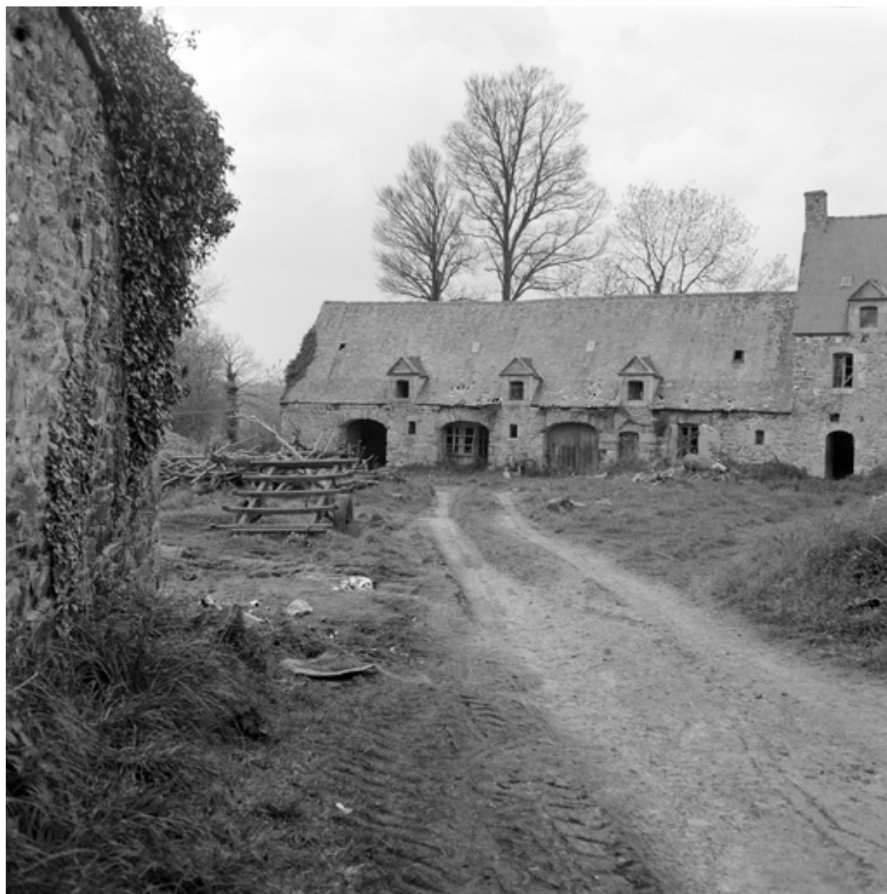
Dépendances : vue générale (état en 1974).
