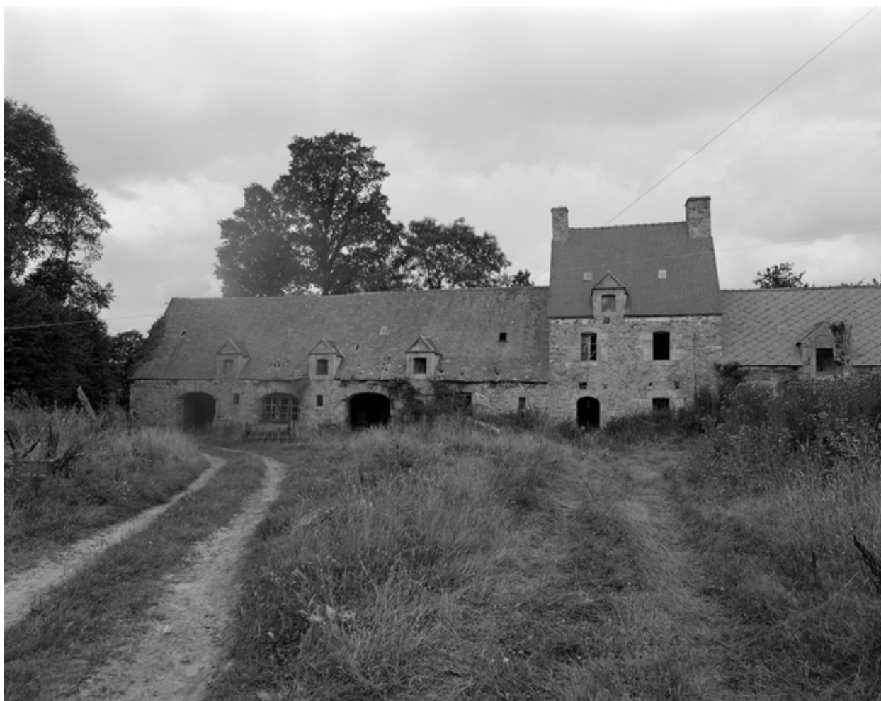
Communs : vue générale
