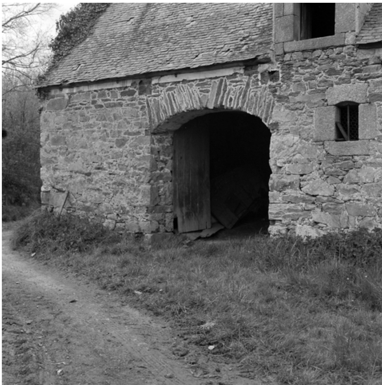
Dépendances, détail : porte charrettière (état en 1974).
