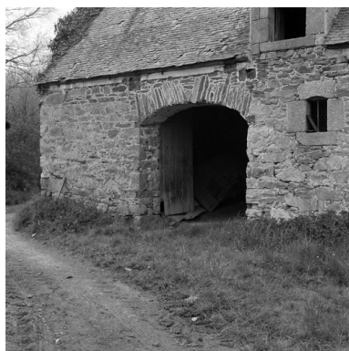
Dépendances, détail : porte charrettière (état en 1974). Phot. Norbert Lambart, Autr. Marie Berthou IVR53_19902200429X
