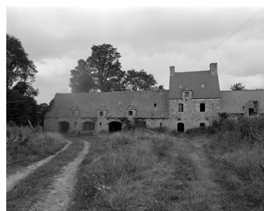
Communs : vue générale Phot. Guy Artur IVR53_19742200535X
