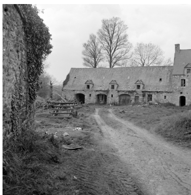
Dépendances : vue générale (état en 1974). Phot. Norbert Lambart, Autr. Marie Berthou IVR53_19902200428X
