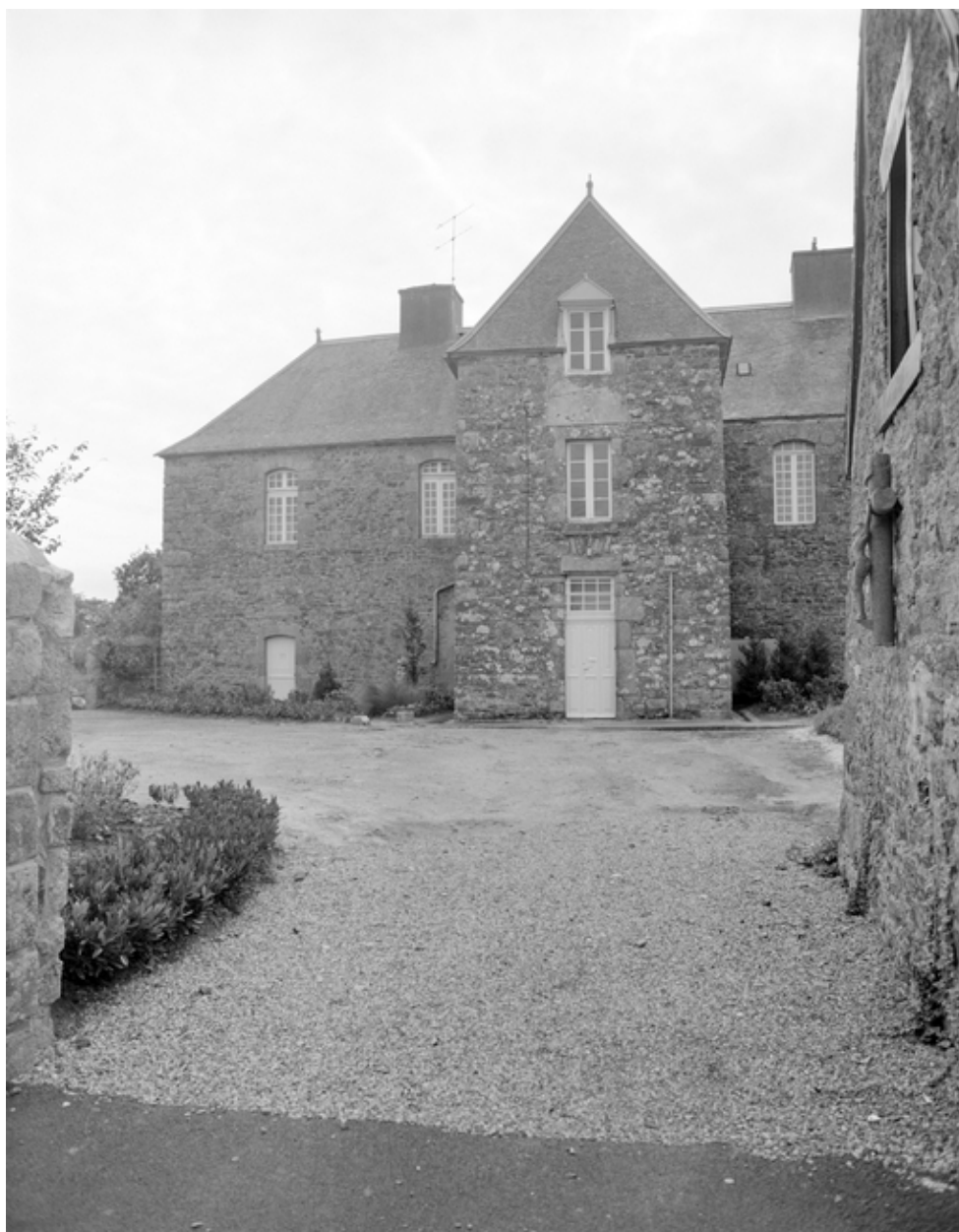
Façade ouest : vue générale
