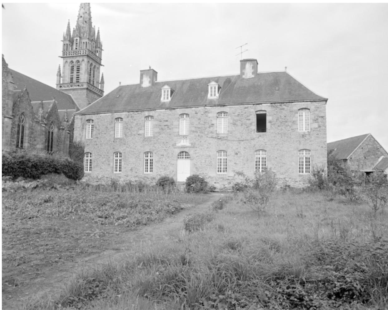
Façade est : vue générale
