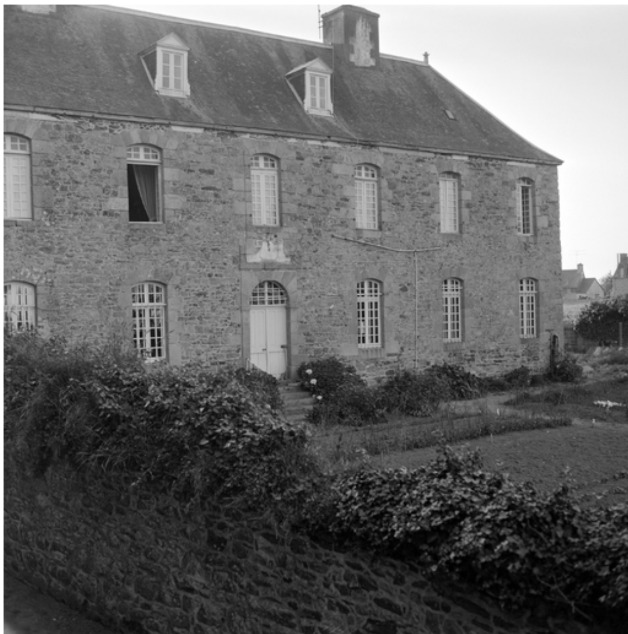
Façade est : vue générale (état en 1974).
