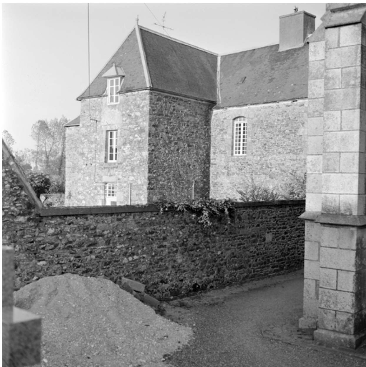
Façade ouest : vue générale (état en 1974).
