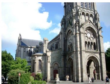
Brest, église Saint-Martin : vue générale nord-ouest Phot. Gwénaél Fauchille IVR53_20082906018NUCA
