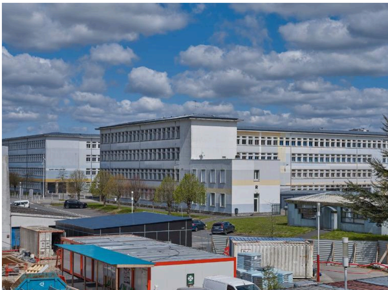
Vue générale partielle prise du sud-est : les bâtiments de l'ancien collège et une aile du lycée Jules Lesven (Jean-Baptiste Mathon, architecte).
