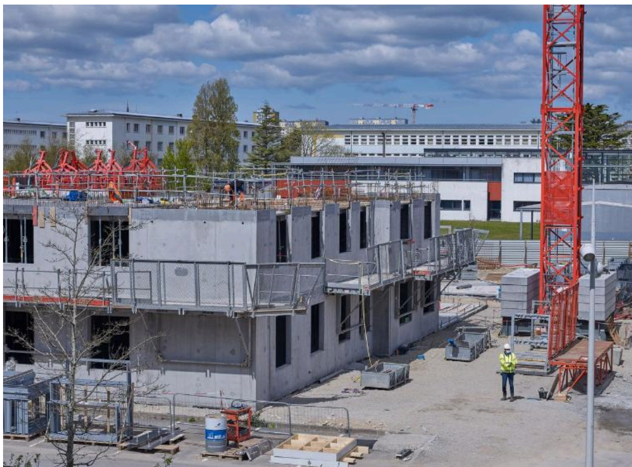
Vue générale partielle prise du sud. Nouvel internat en cours de construction (Agences ATAUB et ENO, architectes).
