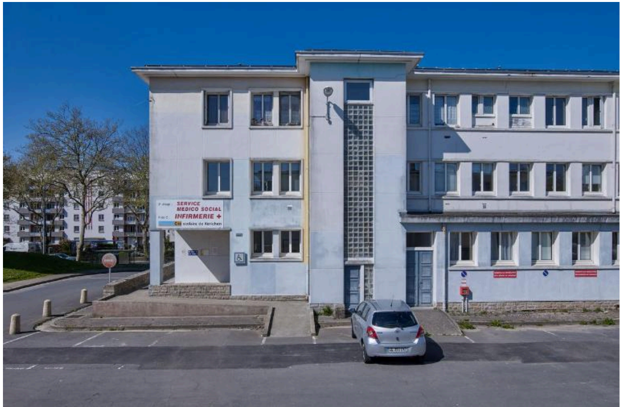
Façade est de l'infirmerie : détail sur une cage d'escalier hors oeuvre et ses pavés de verre (J-B. Mathon, architecte).
