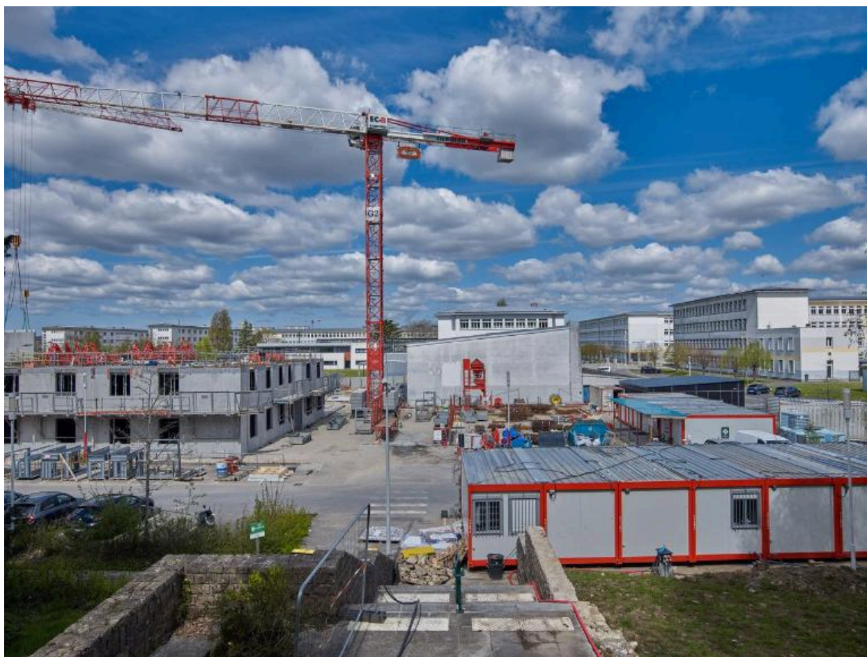
Vue générale partielle prise du sud. Nouvel internat en cours de construction (agences ATaub et ENO, architectes) et, à droite de la grue, pignon d'un des deux gymnases "industrialisés" de type B (construits par l'entreprise Tible, livrés 1959).
