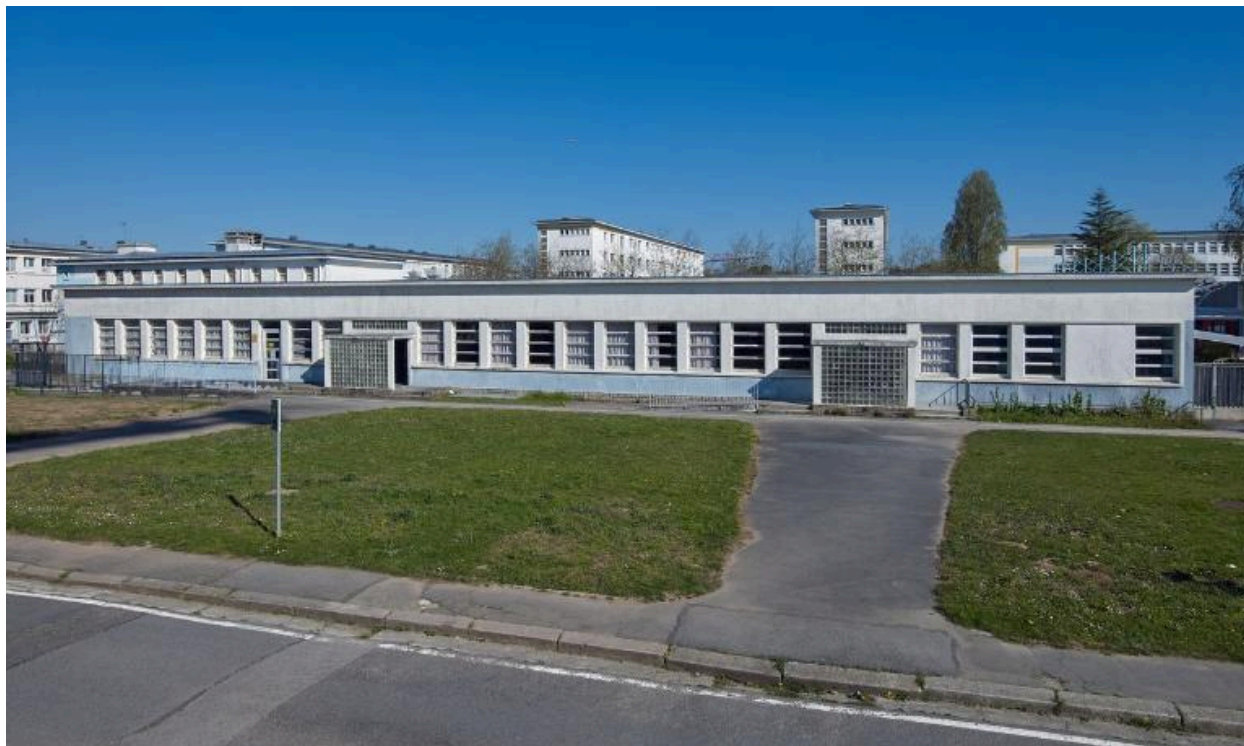
Réfectoire, façade sud. J-B. Mathon, architecte.
