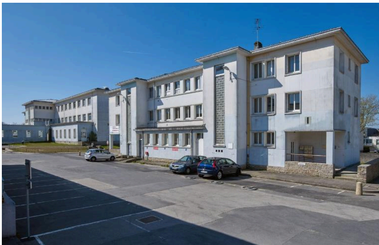
Façade arrière (est) de l'infirmerie. A gauche, Bâtiment B, internat du lycée La Pérouse-Kerichen. J-B. Mathon, architecte.
