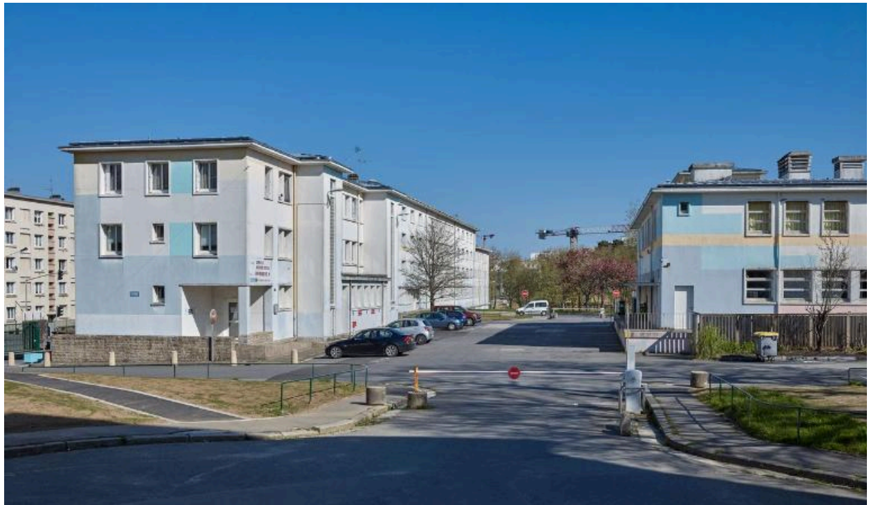
Vue d'ensemble partielle prise du sud vers le nord, dans l'un des axes secondaires de la composition. A gauche, l'entrée ouest de la cité scolaire et l'infirmerie. A droite, les cuisines. J-B. Mathon, architecte.
