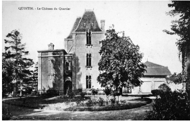
Vue générale Phot. Elise Lauranceau IVR53_20042208972NUCB
