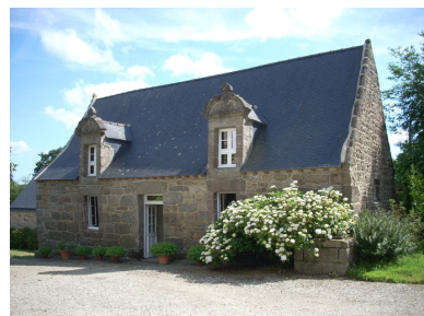
Vue générale d'un des bâtiments Phot. Gwénaél Fauchille IVR53_20112205945NUCA
