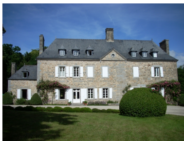
Vue générale de l'élévation principale de la demeure dit "château du Gollot" orientée vers l'ouest Phot. Gwénaél Fauchille IVR53_20112205944NUCA
