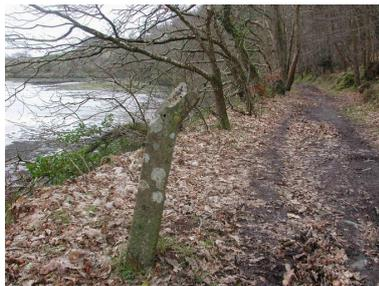
Vue d'un poteau en béton implanté en contrebas du bois de Ploujean face au Dourduff (état en 2003). Il s'agit d'un élément de tétraèdre (type d'obstacle en préfabriqué)
