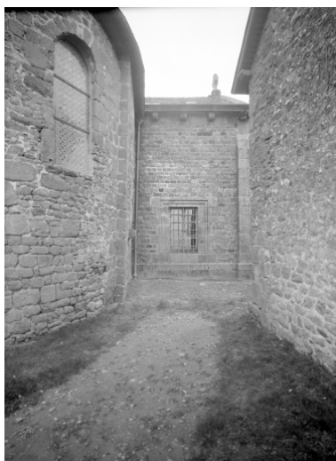
Elévation Est, chevet, partie tournante : vue générale Phot. Yvon Monnerais IVR53_19733500018V
