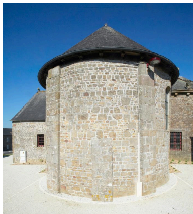
Elévation Est, le choeur : vue générale Phot. Norbert Lambart IVR53_20143500740NUCA
