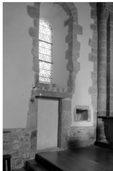
Intérieur, chœur, mur nord : vue générale. Phot. François Dagorn IVR53_19723500695V
