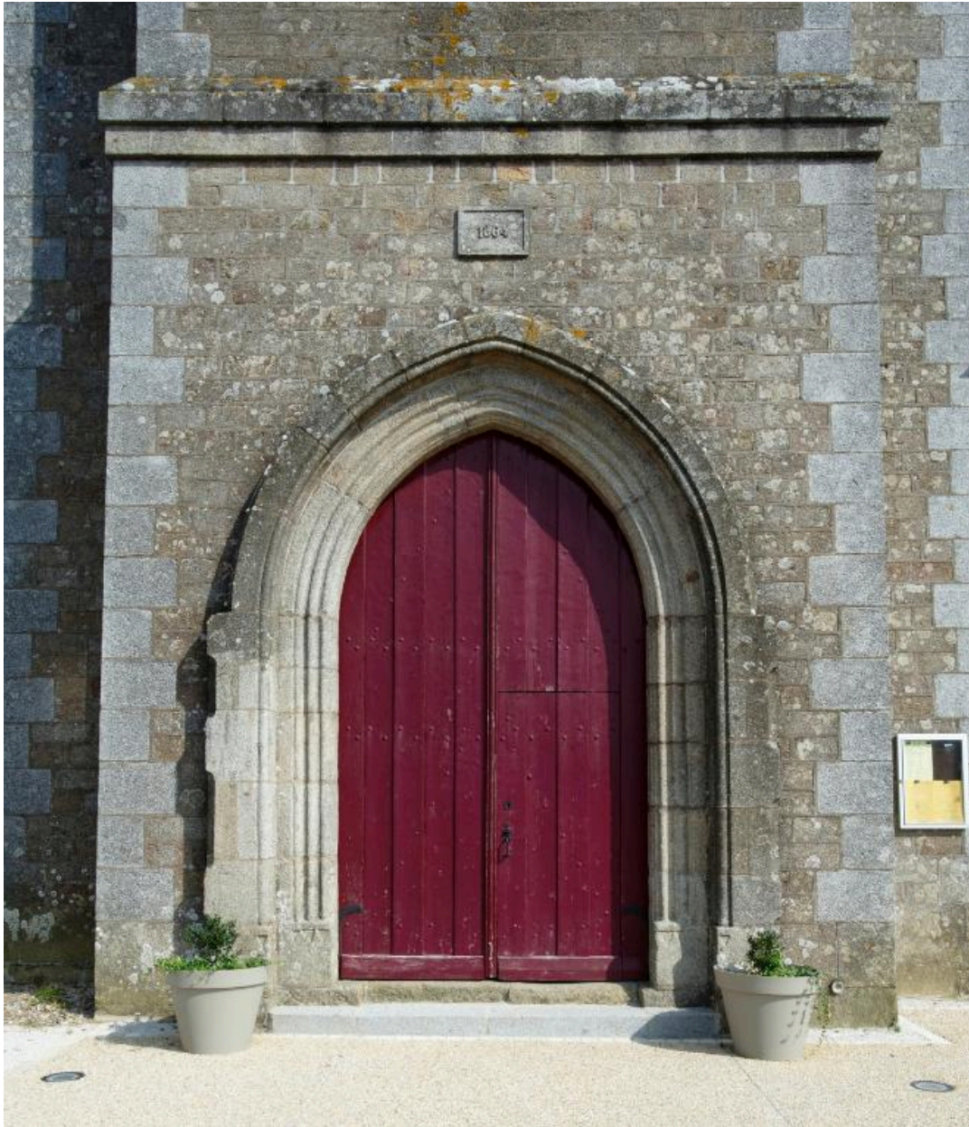
Elévation Ouest : détail du portail et date de 1864
