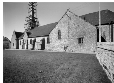
Elévation Sud : vue générale Phot. François Dagorn IVR53_19723500652V
