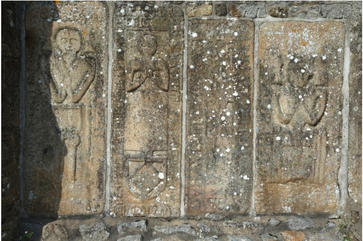
Elévation Sud : détail des pierres tombales dressées
