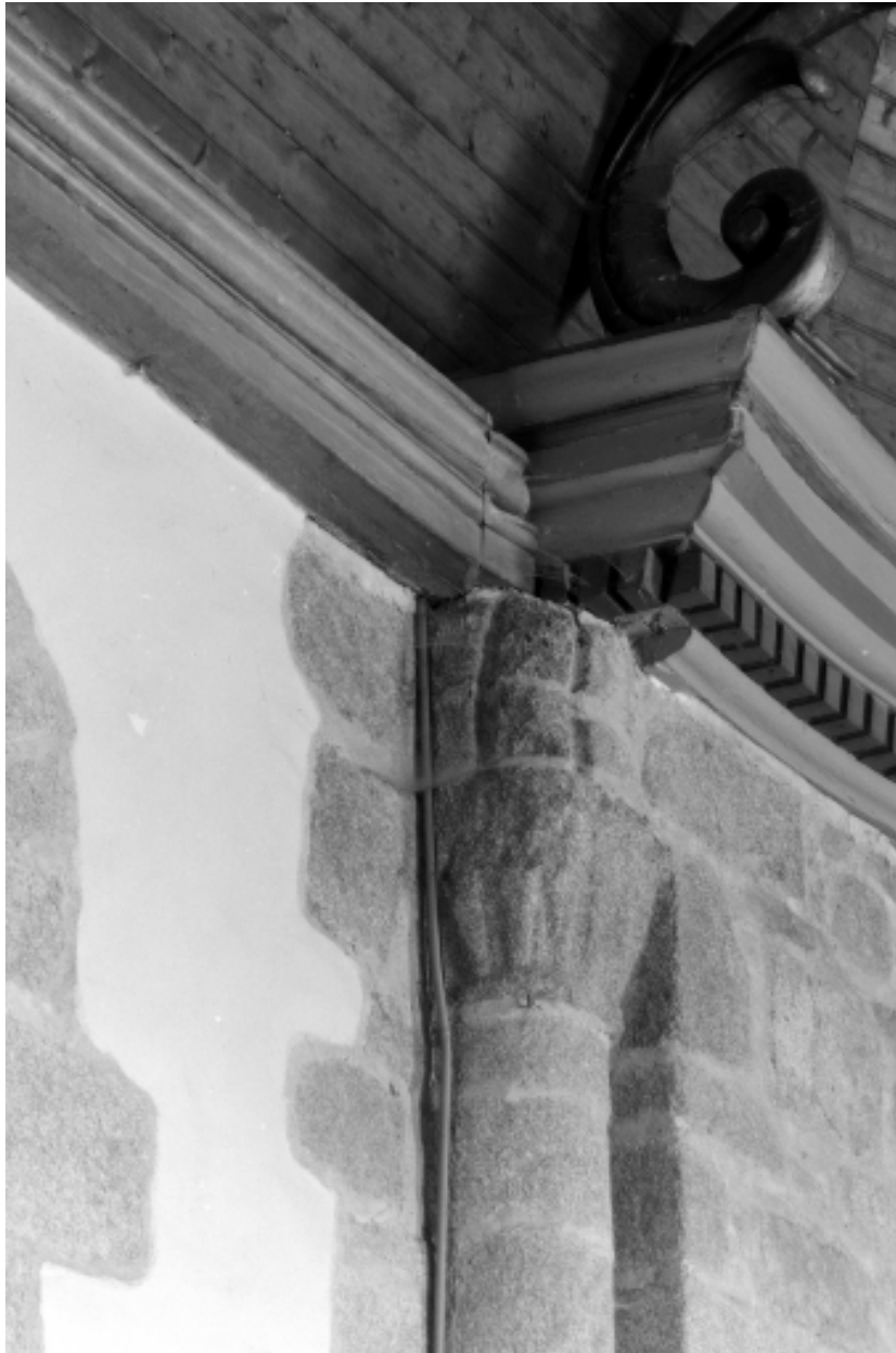
Intérieur, chœur, mur nord : détail d'un chapiteau.
