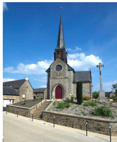
Elévation Ouest, le portail : vue générale Phot. Norbert Lambart IVR53_20143501127NUCA
