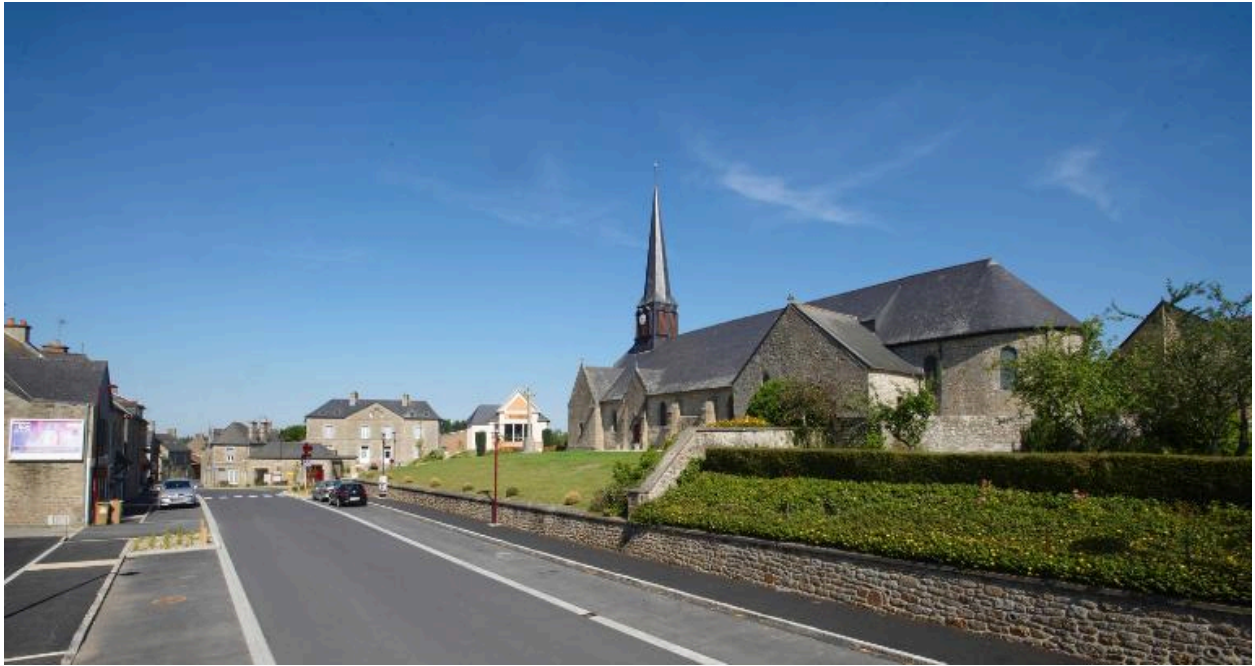
Presbytère et église : vue de situation
