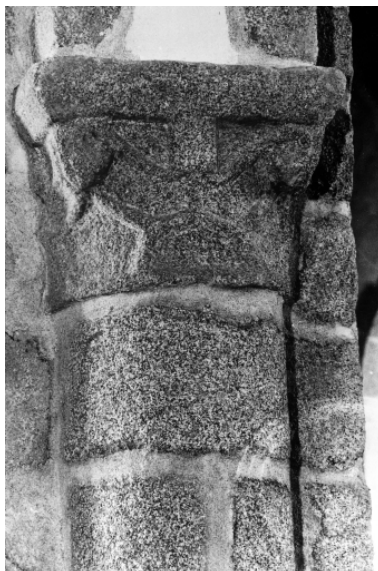
Intérieur : détail de la pile n°3, face est. Phot. Huart IVR53_19693500191V
