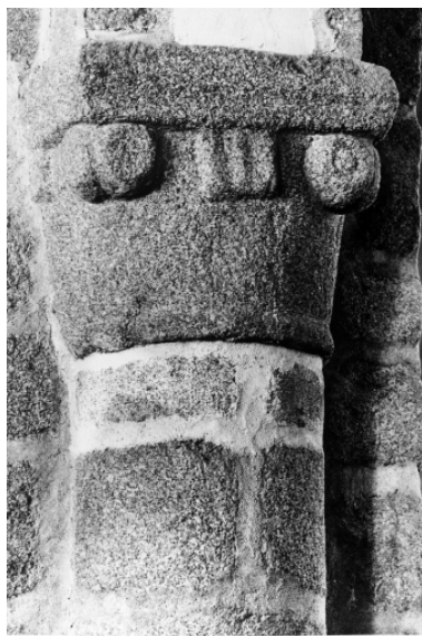
Intérieur : détail de la pile n°4, face est. Phot. Huart IVR53_19693500193V
