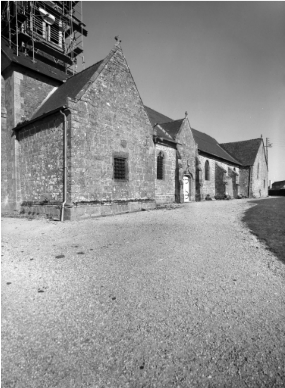
Elévation Sud : vue générale
