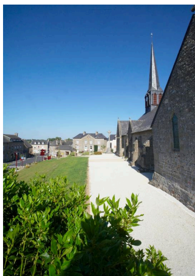
Elévation Sud : vue de l'est Phot. Norbert Lambart
