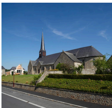
Elévation Sud : vue du sud-est Phot. Norbert Lambart IVR53_20143500768NUCA
