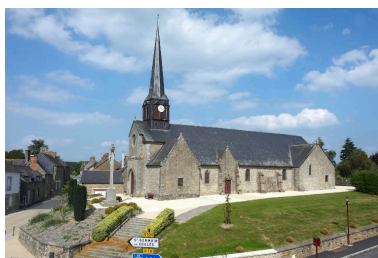
Elévation Sud : vue du sud-ouest Phot. Norbert Lambart IVR53_20143501121NUCA
