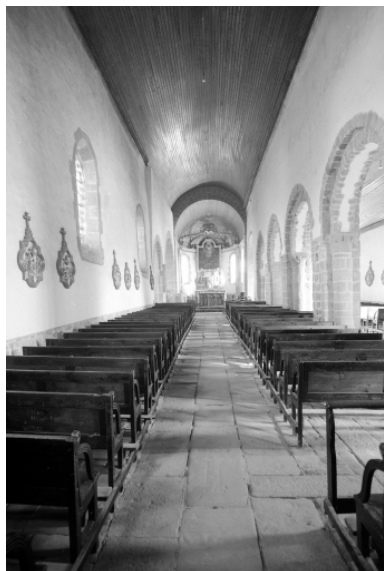
Intérieur : vue générale vers le chœur. Phot. François Dagorn IVR53_19723500665V
