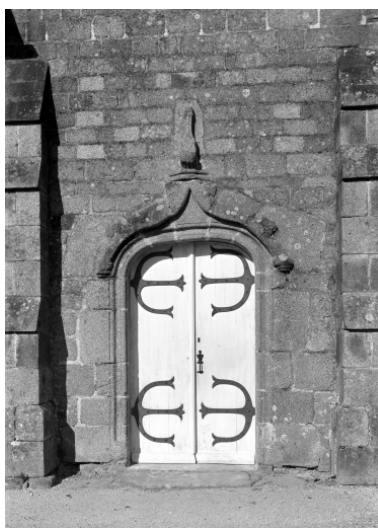
Elévation Sud, nef, porte : vue générale Phot. François Dagorn IVR53_19723500658V
