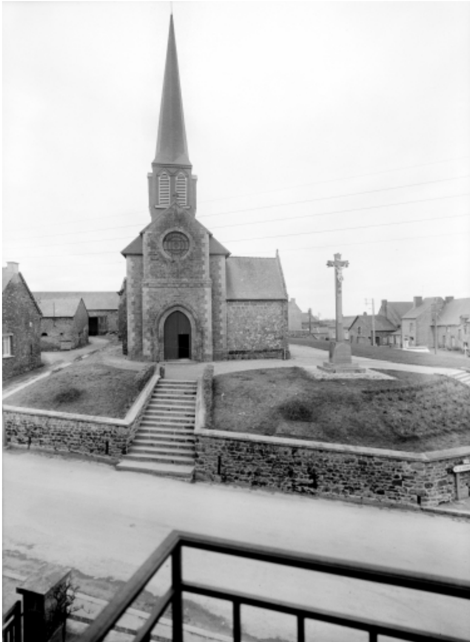
Elévation Ouest : vue générale
