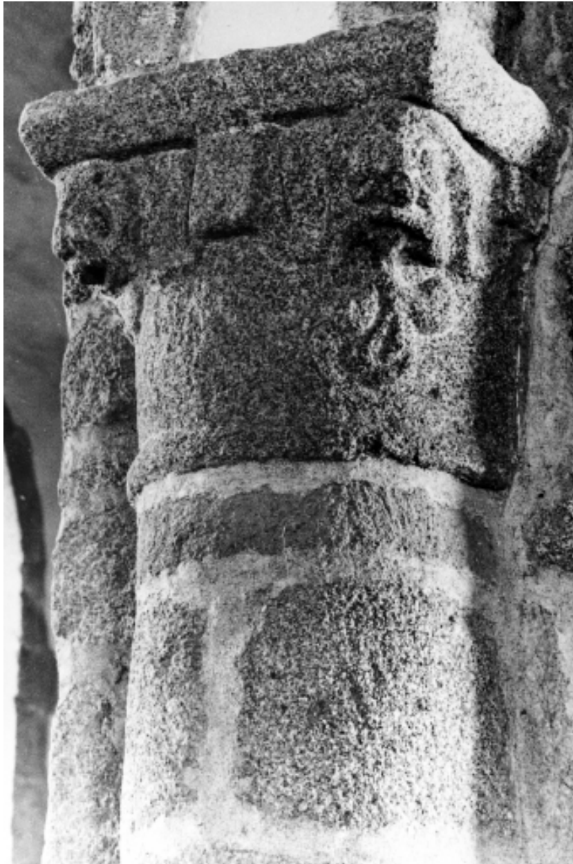
Intérieur : détail de la pile n°2, face ouest.
