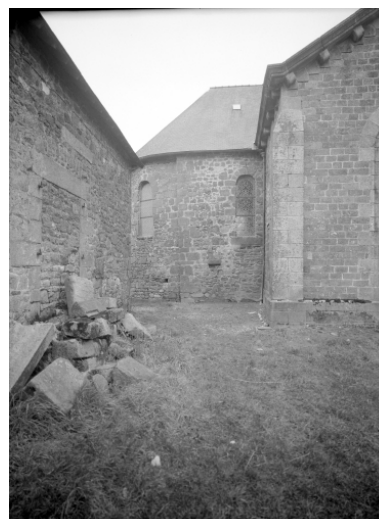
Elévation Nord, chevet : vue générale Phot. Yvon Monnerais IVR53_19733500017V
