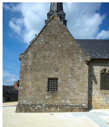
Elévation Sud : chapelle des Fonts Phot. Norbert Lambart IVR53_20143501133NUCA
