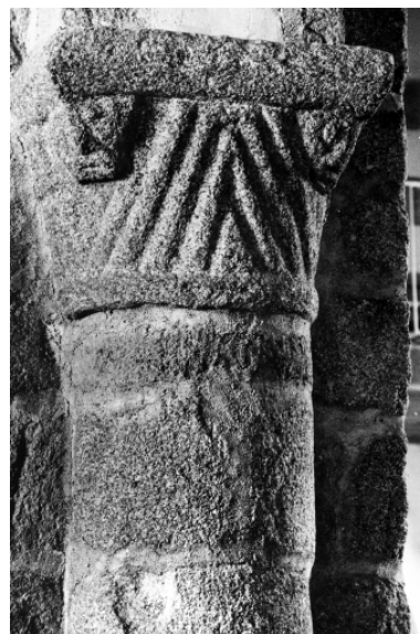
Intérieur : détail de la pile n°2, face est. Phot. Huart IVR53_19693500189V
