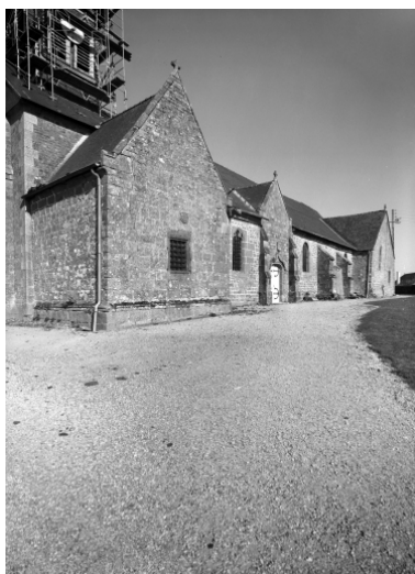
Elévation Sud : vue générale
