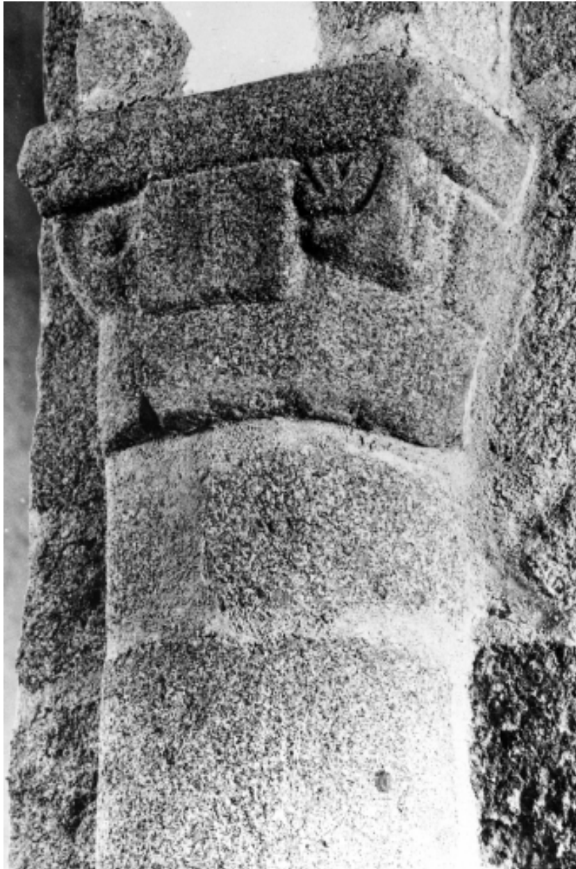
Intérieur : détail de la pile n°1, face ouest.
