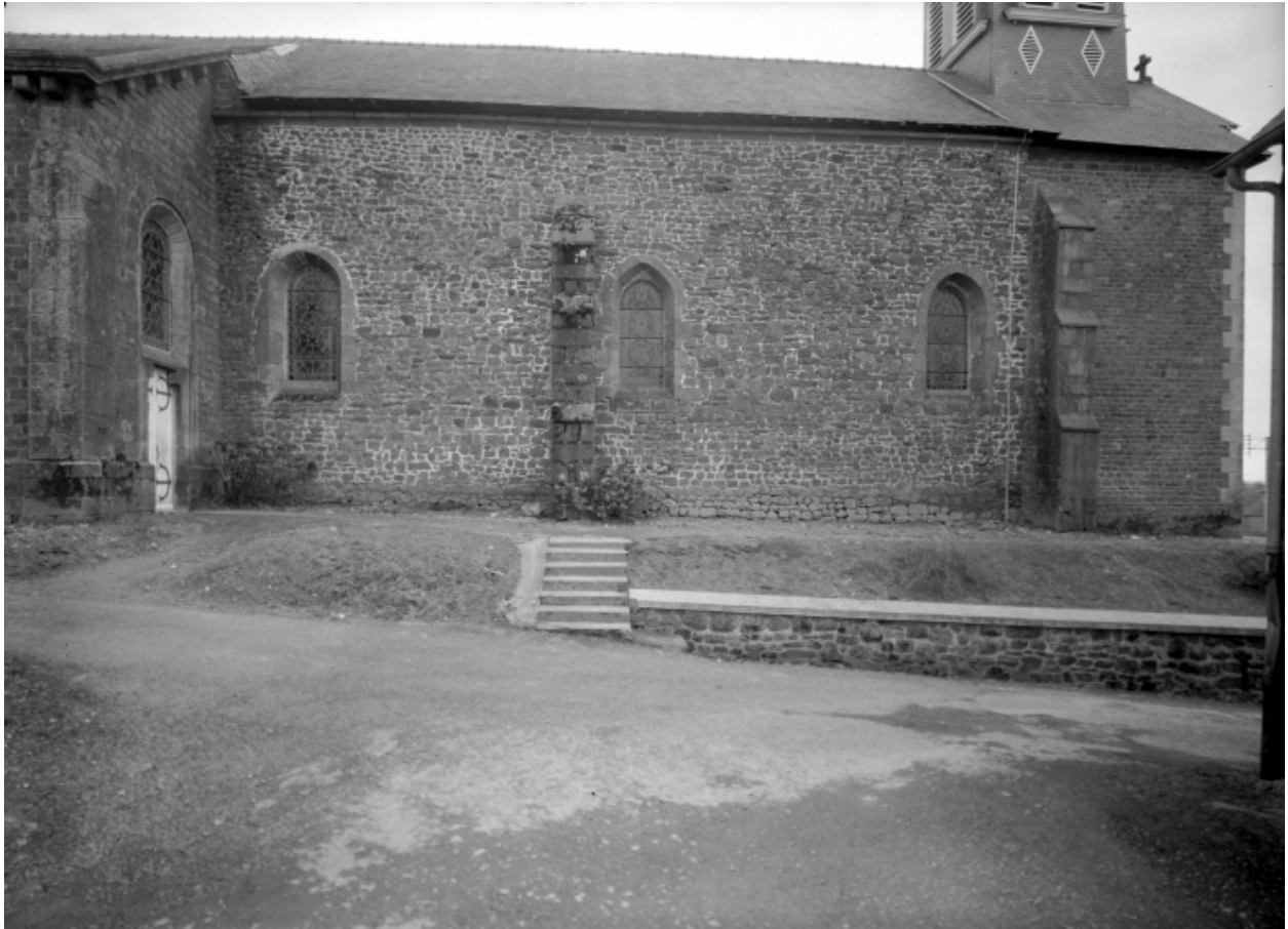
Elévation Nord, nef : vue générale
