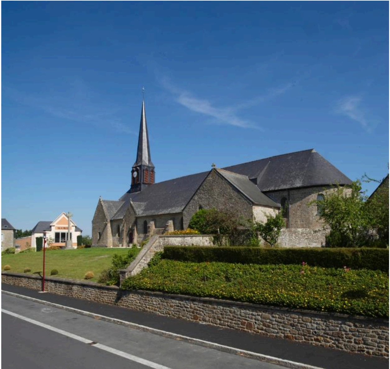
Elévation Sud : vue du sud-est
