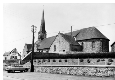
Elévation Sud-Est : vue générale Phot. Yvon Monnerais IVR53_19693500184V
