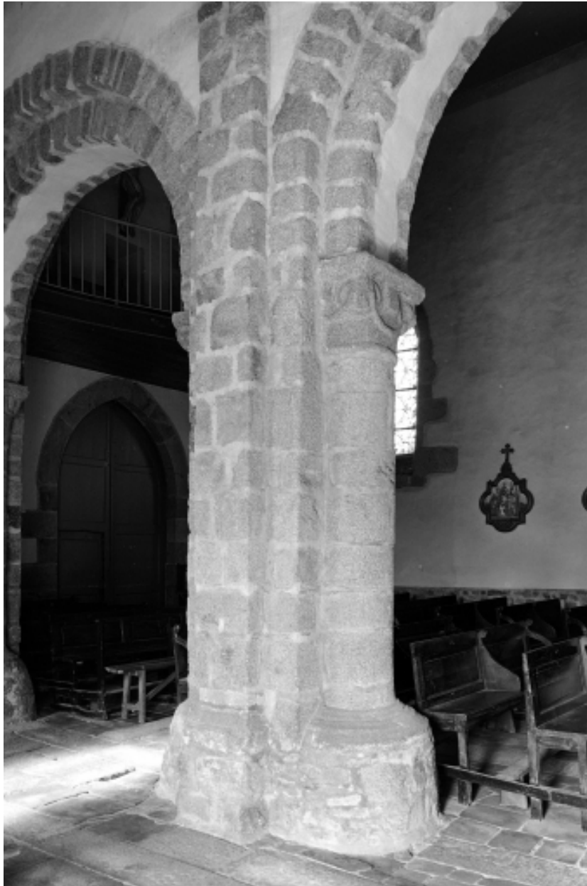
Intérieur, pile n°1 : vue générale.
