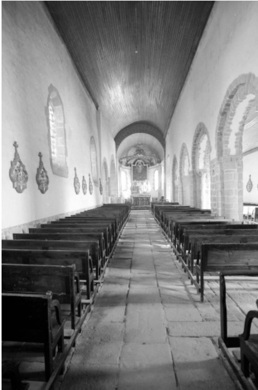
Intérieur : vue générale vers le chœur.
