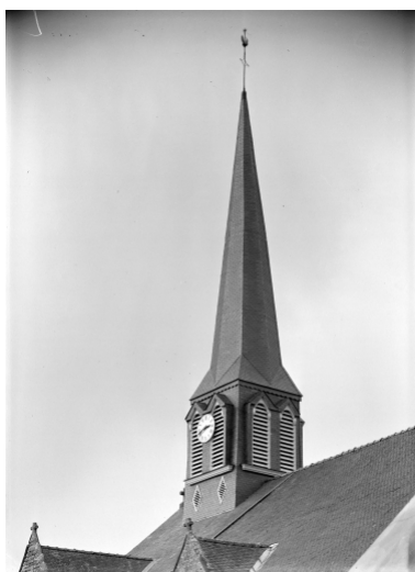
Elévation Ouest, clocher : vue générale Phot. Yvon Monnerais IVR53_19733500006V
