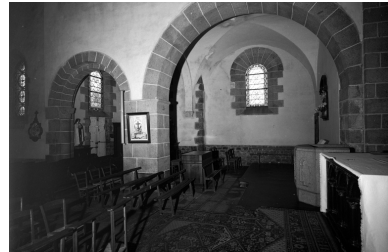
Intérieur, bras Nord du transept : vue générale. Phot. François Dagorn IVR53_19723500668V
