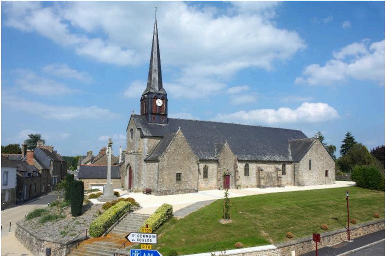
Elévation Sud : vue du sud-ouest
