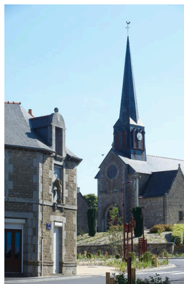
Elévation Ouest : vue générale du sud-ouest Phot. Norbert Lambart IVR53_20143500761NUCA
