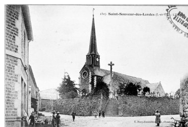
Elévation Sud-Ouest : vue générale (Carte postale ancienne) Phot. Guy Artur, Phot. Norbert Lambart IVR53_19933500916XB
