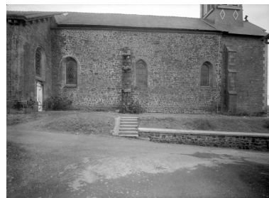
Elévation Nord, nef : vue générale Phot. Yvon Monnerais IVR53_19733500014V
