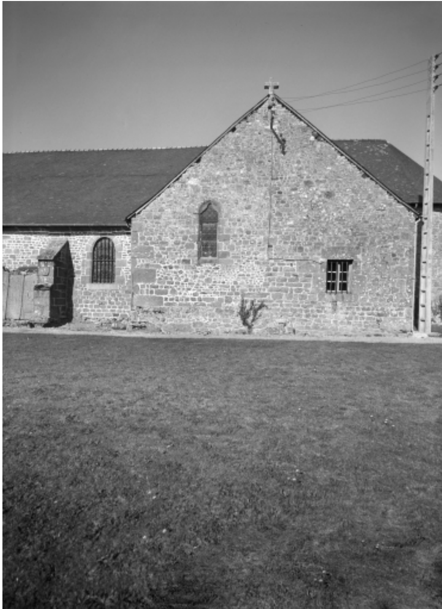
Elévation Sud, bras du transept et sacristie : vue générale
