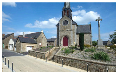
Elévation Ouest, le portail : vue générale Phot. Norbert Lambart IVR53_20143501128NUCA
