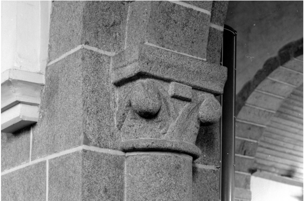
Intérieur, arcade Nord : détail du chapiteau Ouest.
