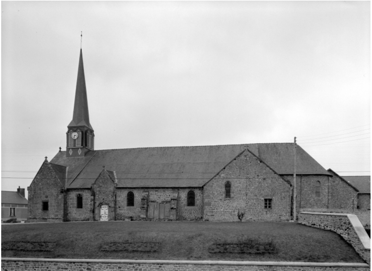
Elévation Sud : vue générale
