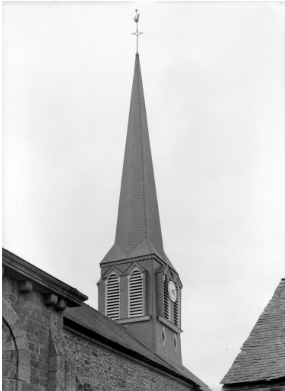
Elévation Nord, clocher : vue générale
