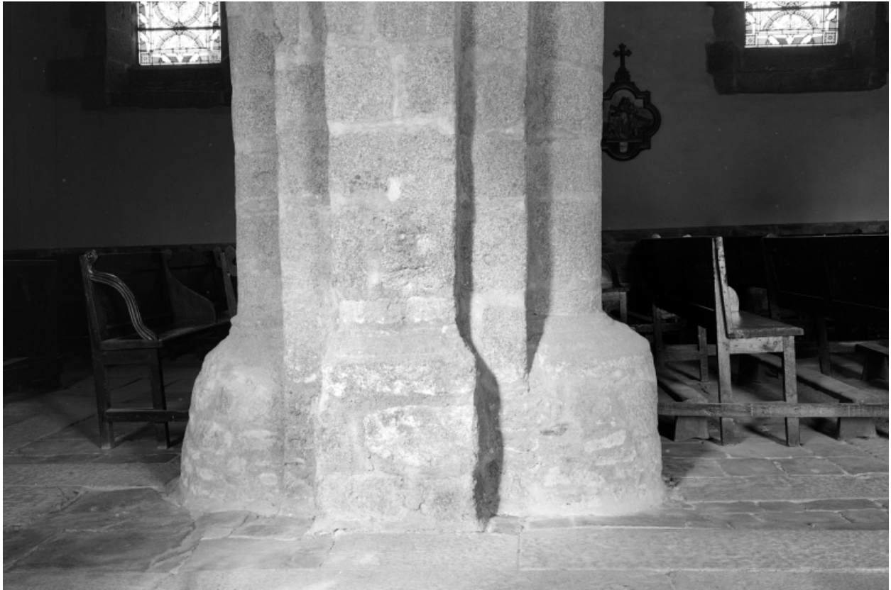
Intérieur, arcade Nord : détail de la base des piliers Sud.
