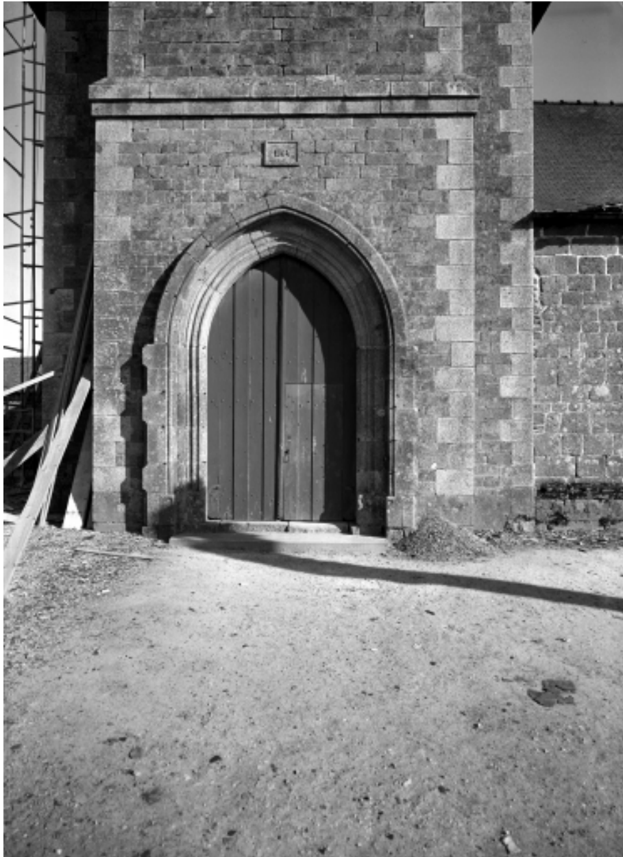
Elévation Ouest : détail du portail
