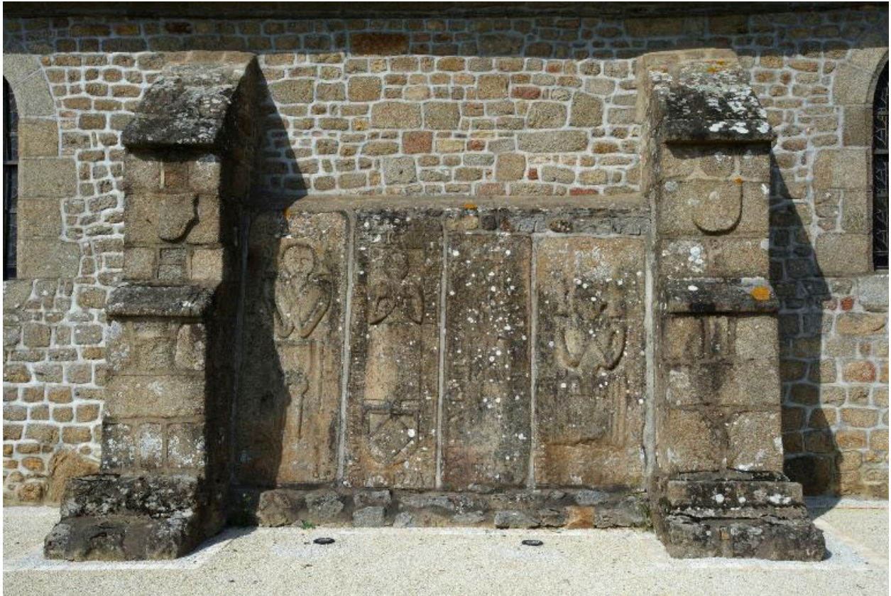
Elévation Sud : détail des pierres tombales dressées
