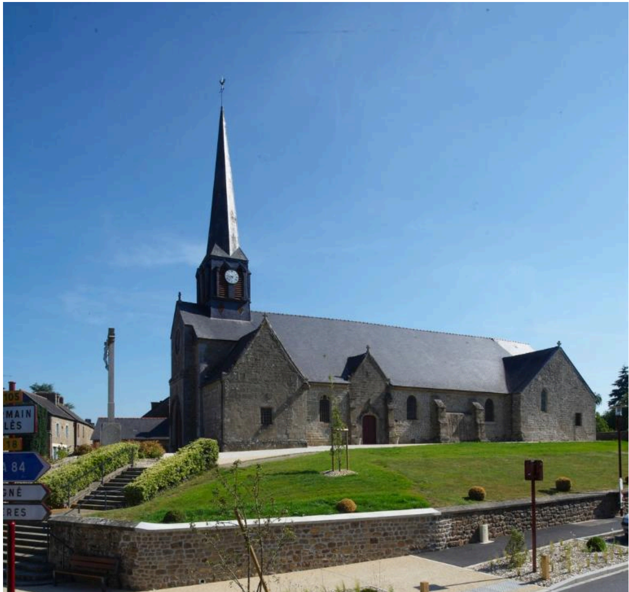
Elévation Sud : vue générale
