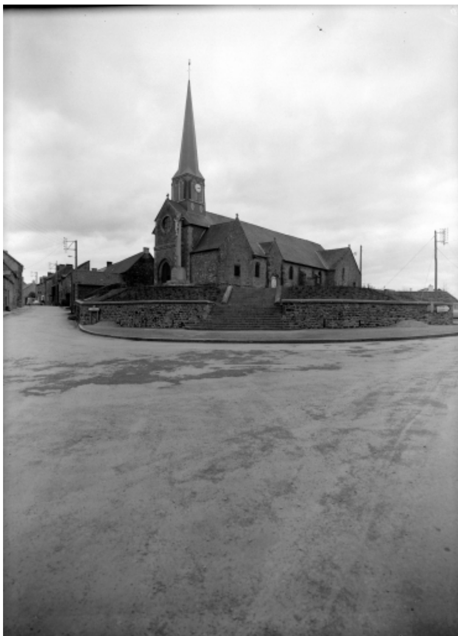
Elévation Sud-Ouest : vue générale
