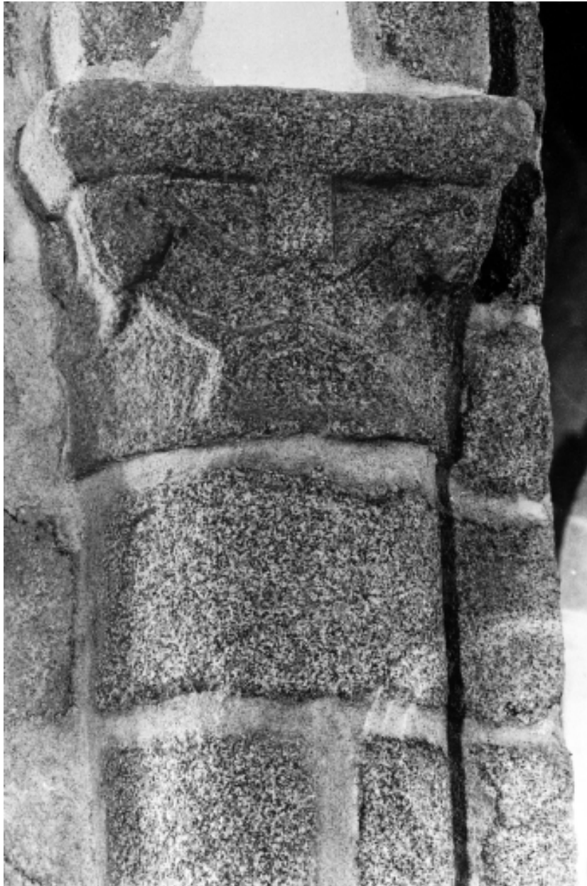
Intérieur : détail de la pile n°3, face est.
