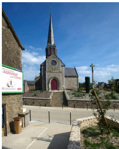
Elévation Ouest, le portail : vue générale Phot. Norbert Lambart IVR53_20143501125NUCA
