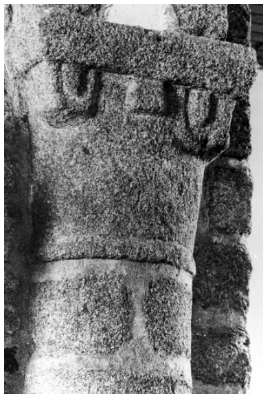
Intérieur : détail de la pile n°0, face est. Phot. Huart IVR53_19693500186V
