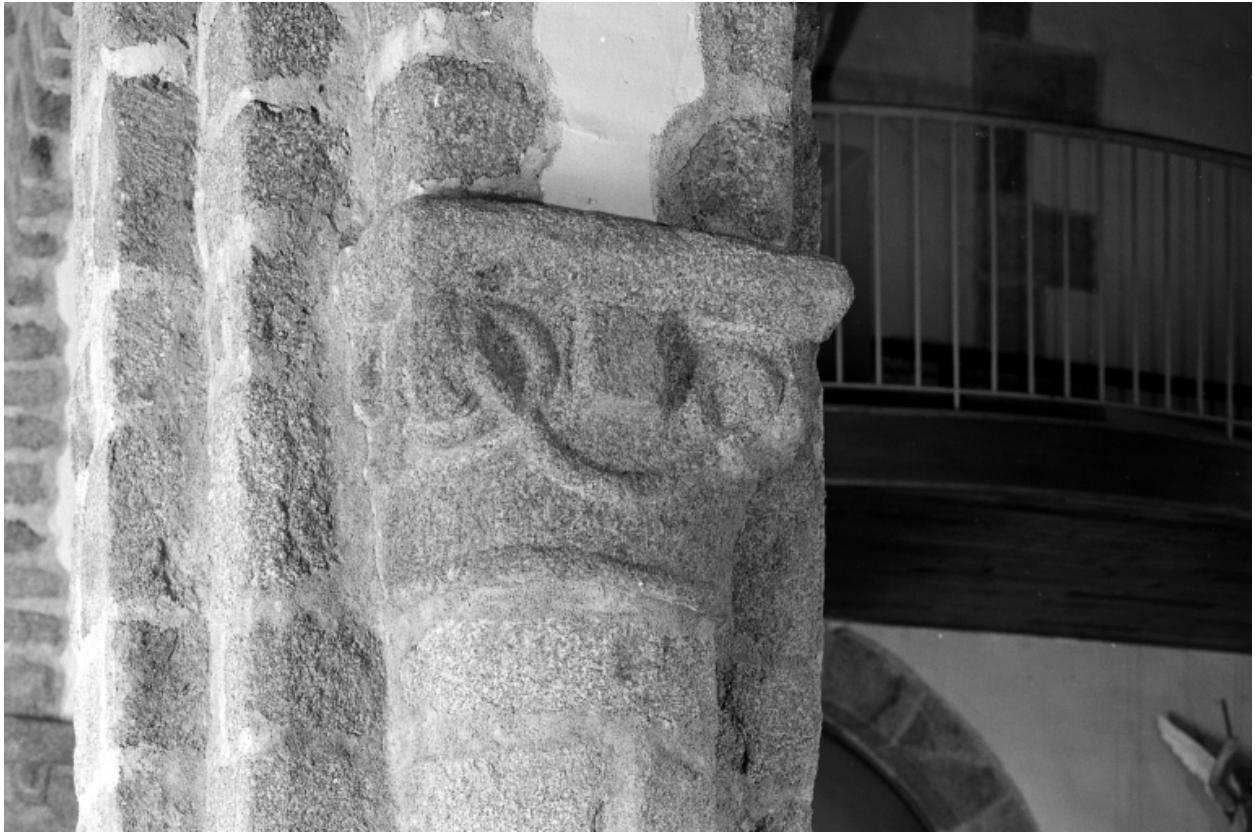
Intérieur : détail de la pile n°1, face est.
