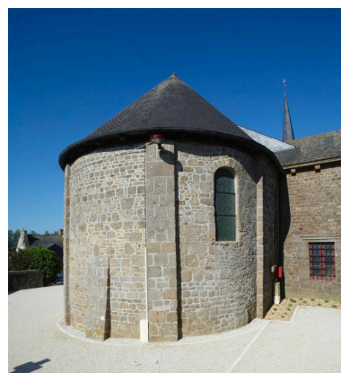
Elévation Est, le choeur : vue générale Phot. Norbert Lambart IVR53_20143500735NUCA
