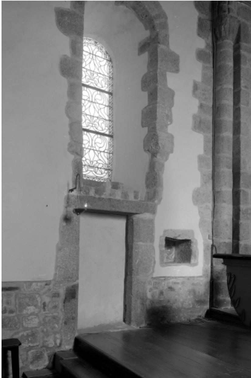
Intérieur, chœur, mur nord : vue générale.
