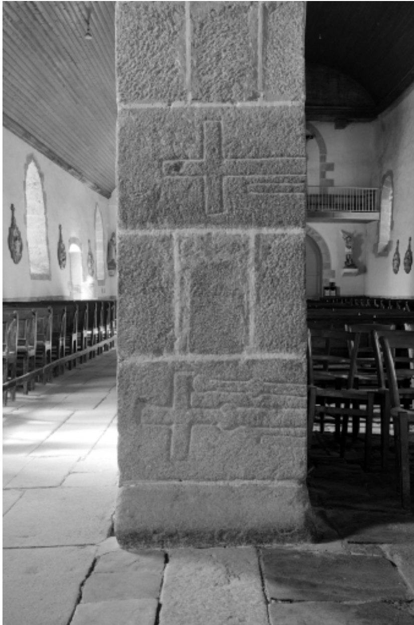
Intérieur, croisée du transept : détail de la pile Sud-Est.
