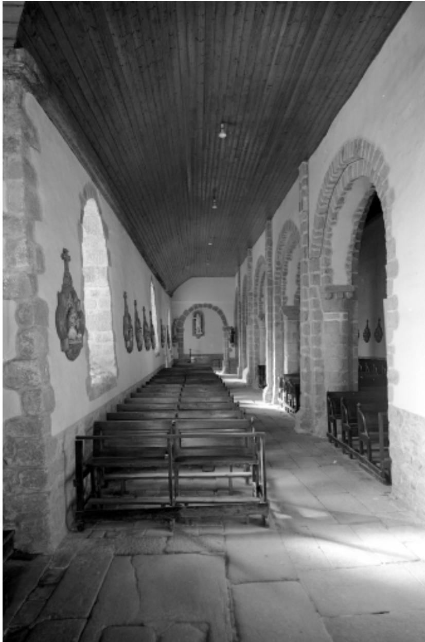
Intérieur, bas-côté : vue générale d'Est en Ouest.
