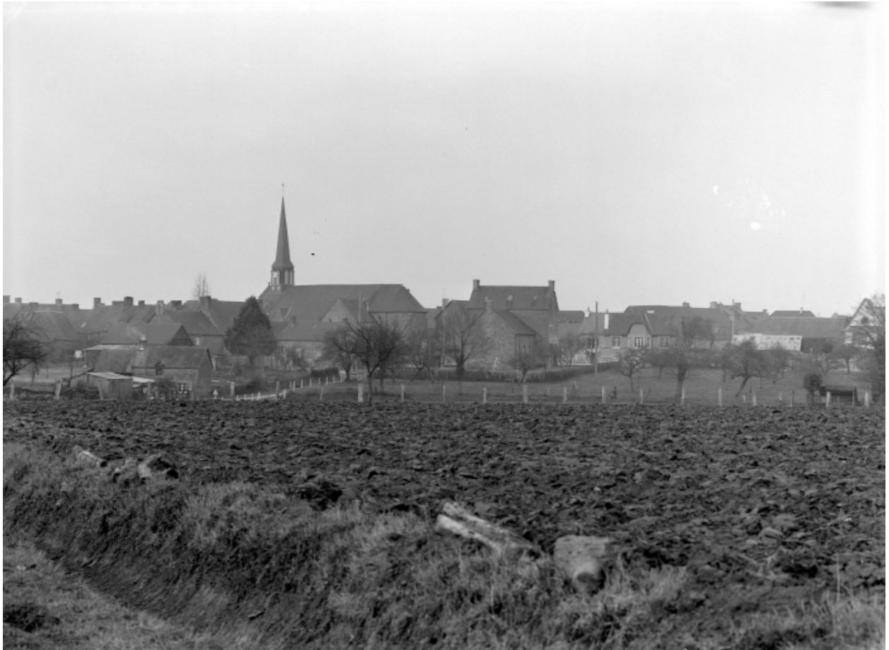
Elévation Sud-Est : vue de situation
