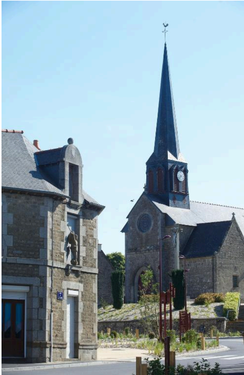
Elévation Ouest : vue générale du sud-ouest
