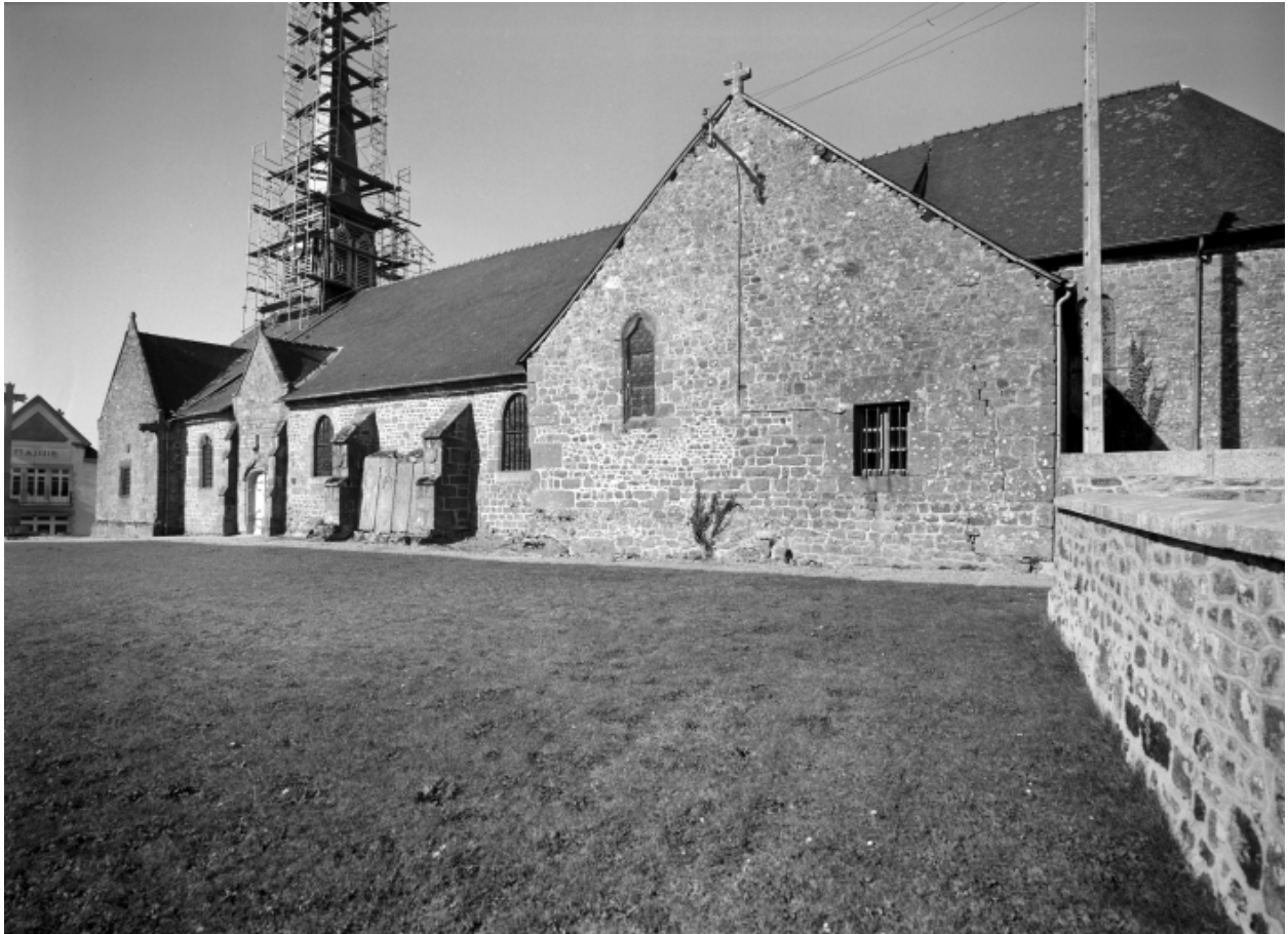
Elévation Sud : vue générale
