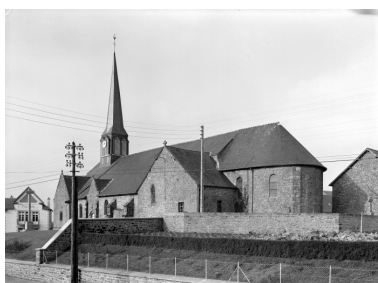
Elévation Sud-Est : vue générale Phot. Yvon Monnerais IVR53_19733500007V
