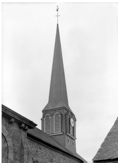
Elévation Nord, clocher : vue générale Phot. Yvon Monnerais IVR53_19733500012V
