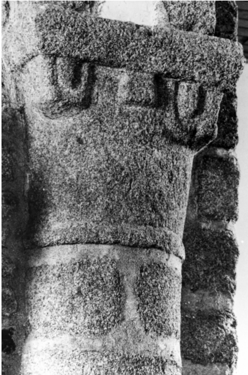
Intérieur : détail de la pile n°0, face est.
