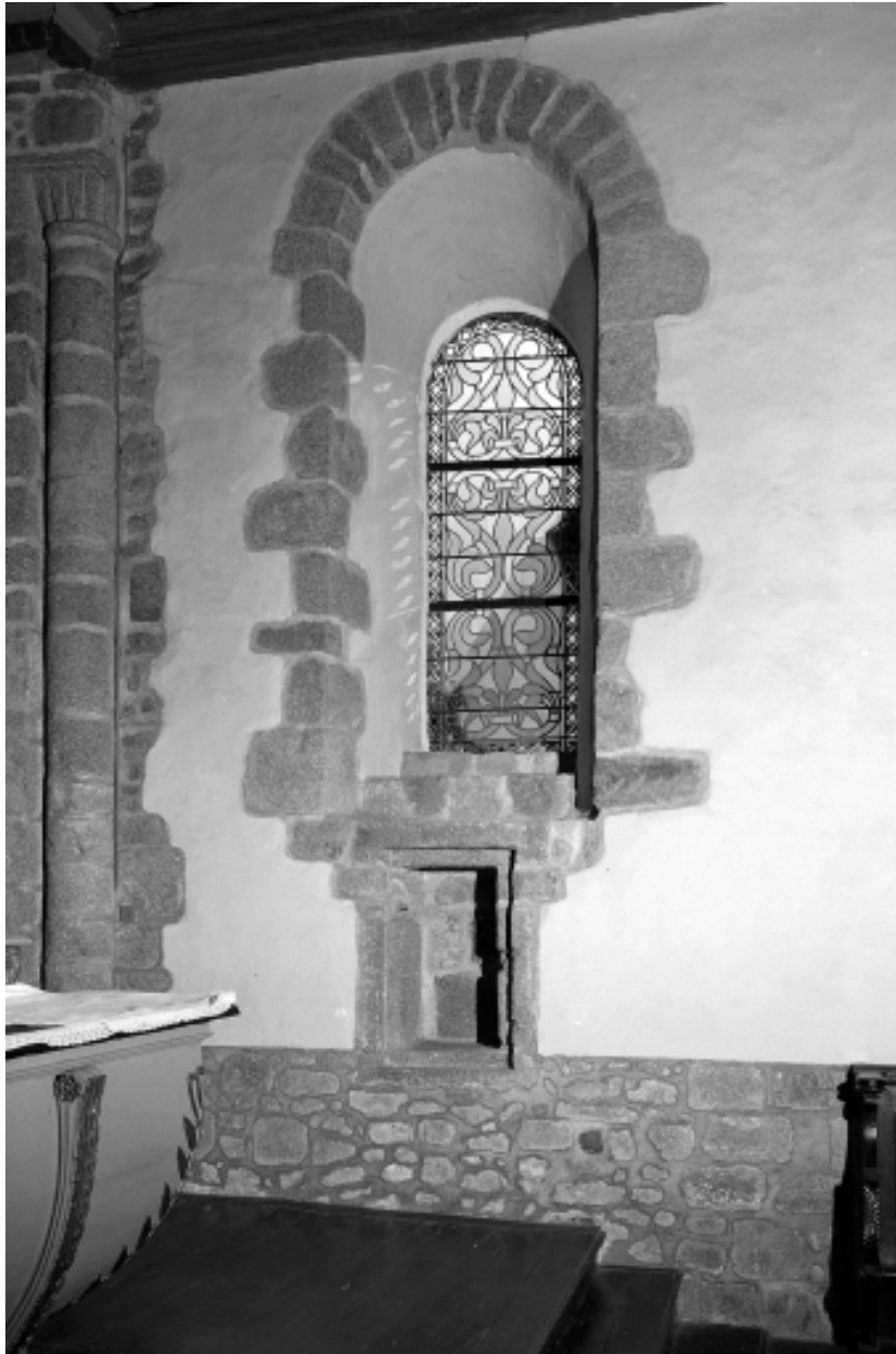
Intérieur, chœur, mur sud : vue générale.
