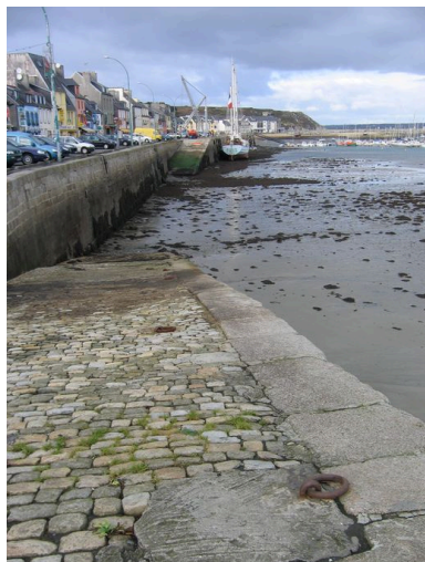
Cale sud du quai Toudouze Phot. Françoise Péron IVR53_20062908312NUCA
